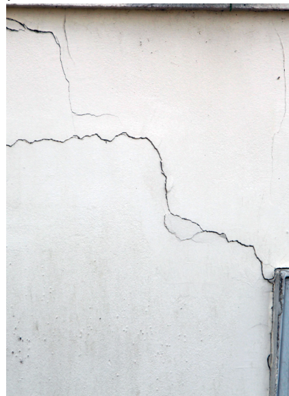
Déformation d'un bâtiment par tassement différentiel
