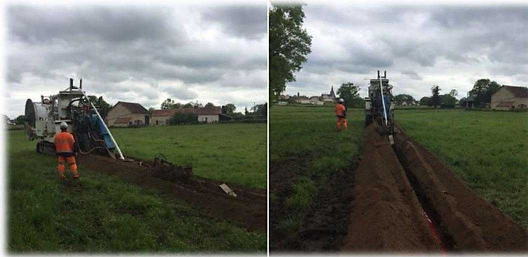
Figure 65 : Exemple de chantier d'enfouissement d'un réseau électrique en terres agricoles ( source : Cegelec infra)
