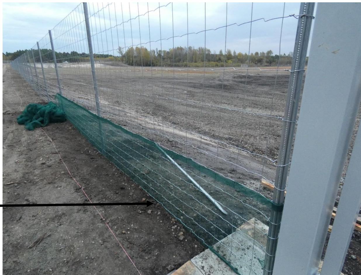
*Photo Erreur ! Signet non défini. : Exemple d'installation d'une barrière à batraciens au pied d'une clôture à maille large avant le chantier de construction d'un parc solaire*
