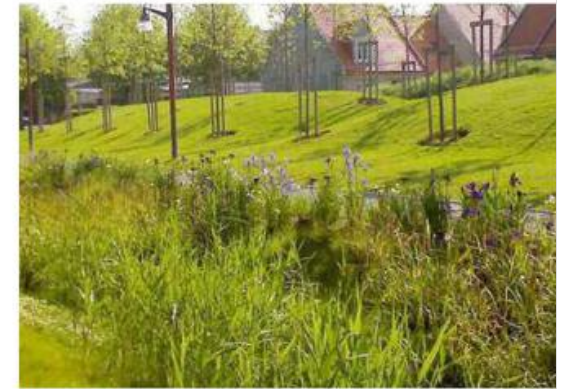
Végétalisation des noues d'infiltration
