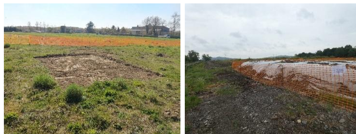
Exemples de station floristiques après décapage des horizons superficiels et merlon de stockage des banquettes de terre (Source : Simethis)
