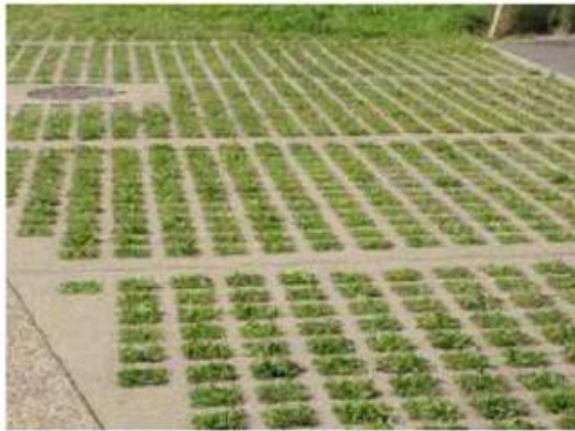
Stationnements perméables engazonnés
