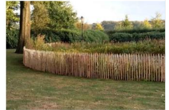
Ganivelle en protection de la zone d'évitement
