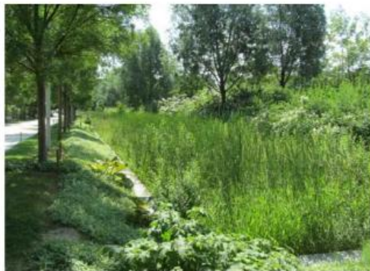
Végétalisation des noues d'infiltration
