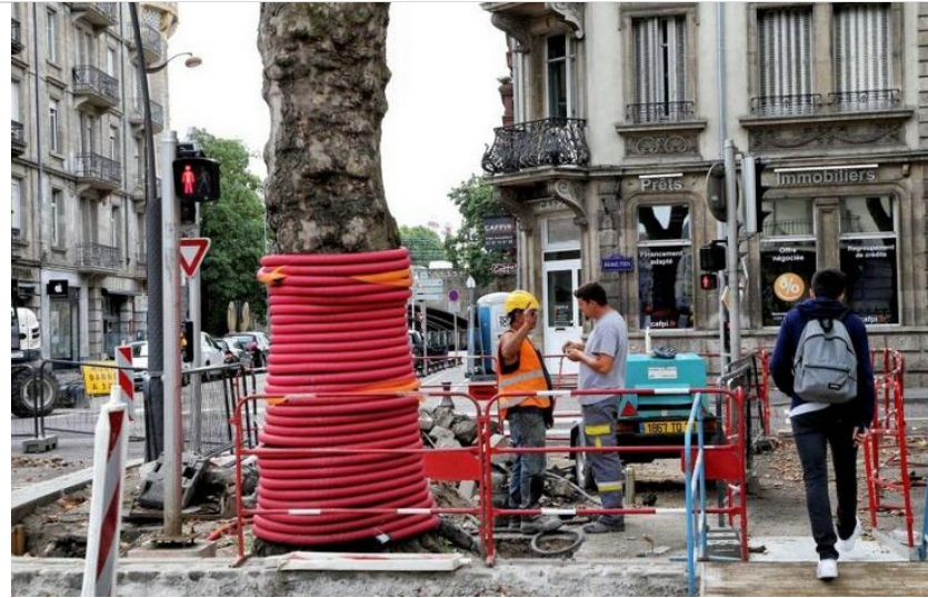
Protection des arbres par des drains agricoles (@ RL/Anthony PICORE)
