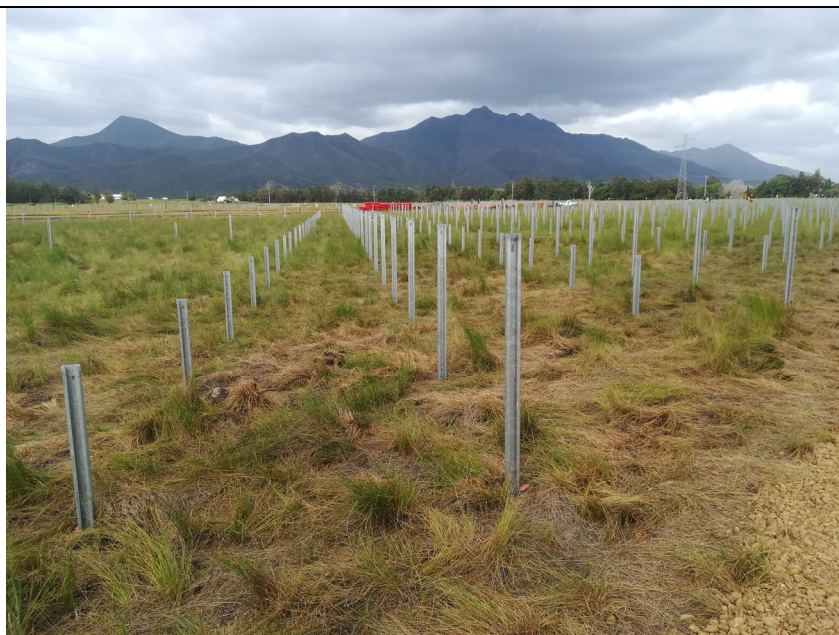
Figure 23 : Exemple d'ancrage par pieux battus -Source : Melvan
