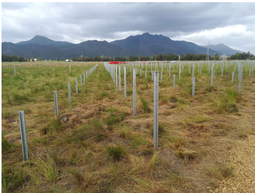
Figure 17 : Exemple d'ancrage par pieux battus -Source : Melvan
