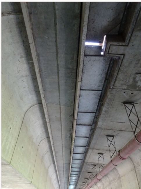
VUE DU TPC ET DE LA CORNICHE DU VIADUC SENS 2
