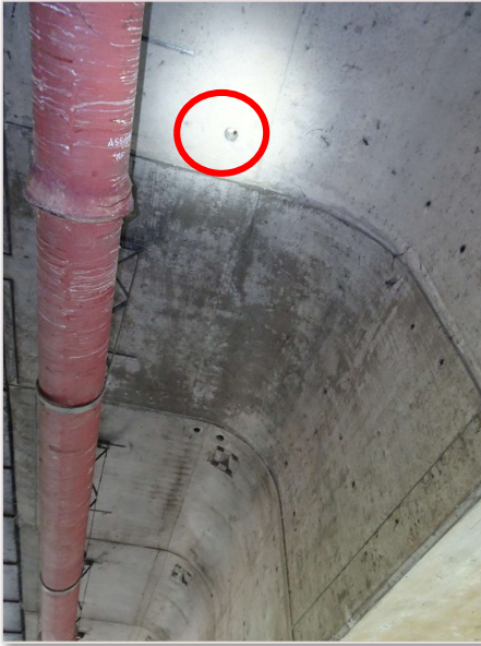
CERCLE ROUGE > TROU DE RESERVATION OCCUPE EN INTRADOS DU VIADUC EN SENS1 VERS LA CULEE C1 (AOÛT 2022)
