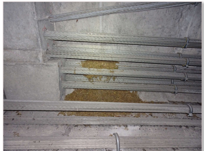
TRACE D'APPORT DE MATERIAUX PAR DES OISEAUX, MAIS SANS TRACE DE NIDIFICATION
