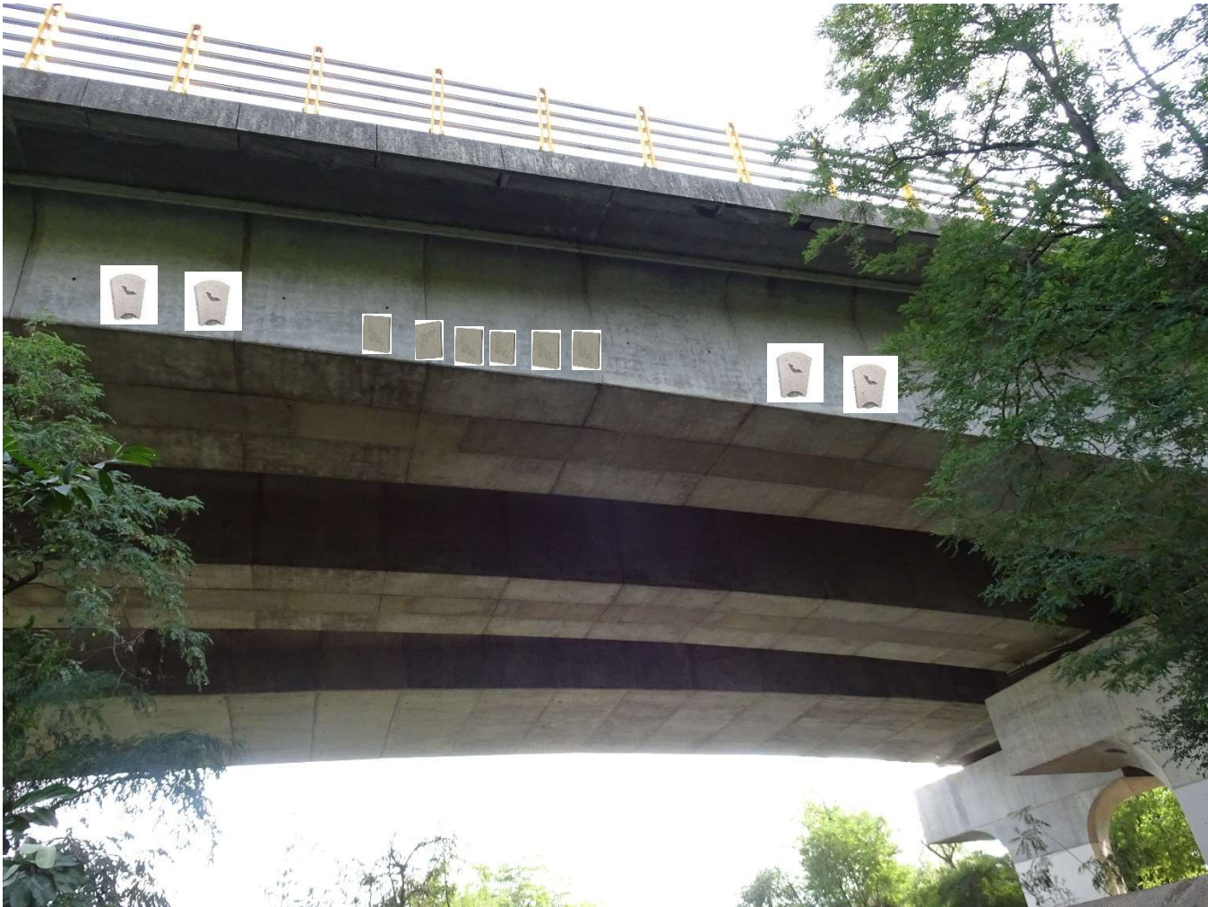
Figure 49. Implantation du module caisson 6 du chemin du Barris
