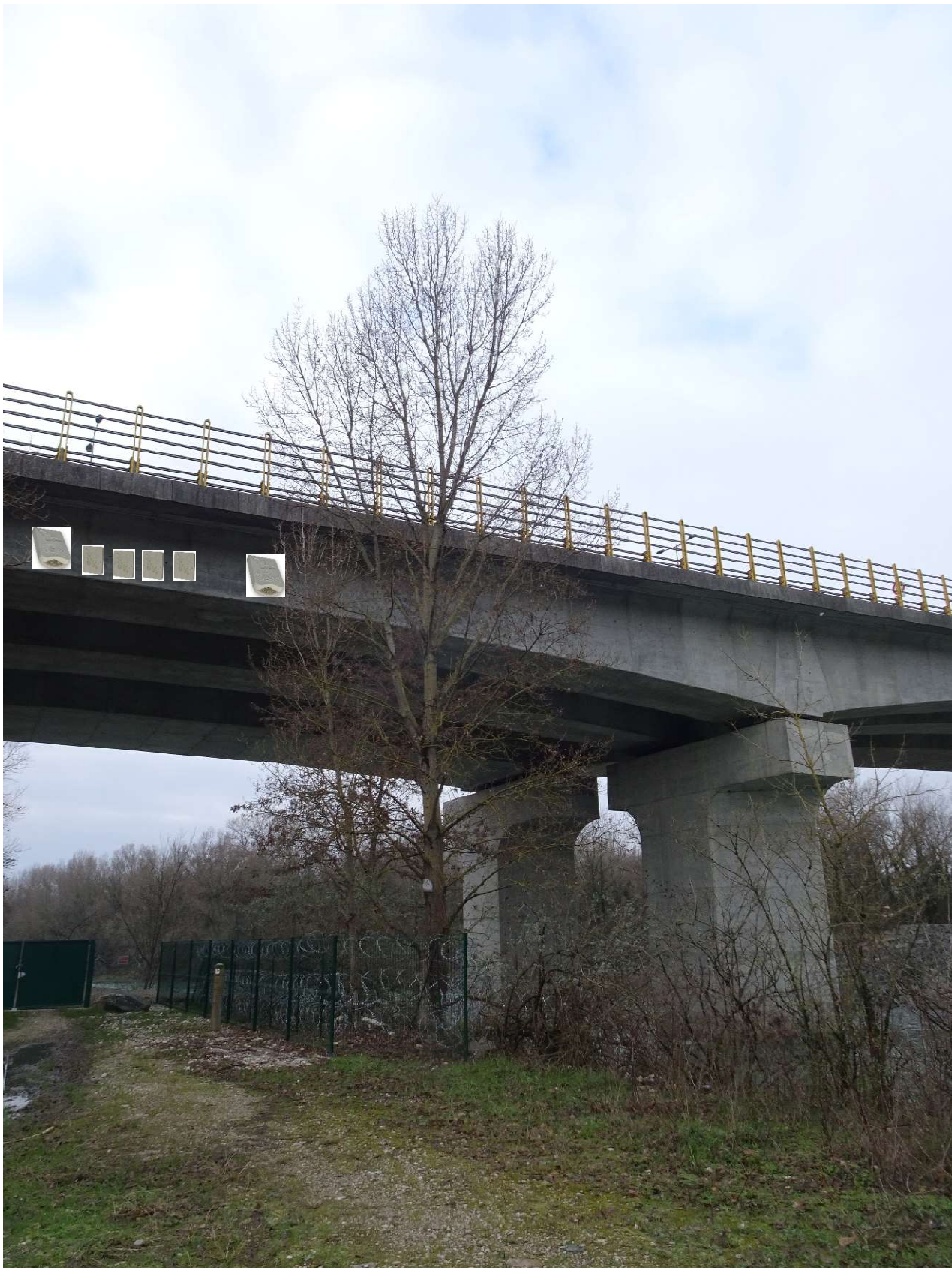
Figure 50. Implantation du module caisson 2 au niveau de l'allée des cavaliers
