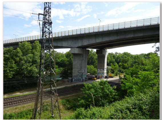
VUE DE LA VOIE SNCF ET DU CHEMIN DE HALAGE
