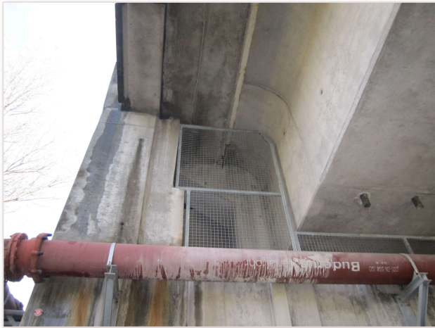
VUE DE LA GRILLE FERMANT L'ACCES A LA CULEE C6 EN SENS 2 EN NOVEMBRE 2013
