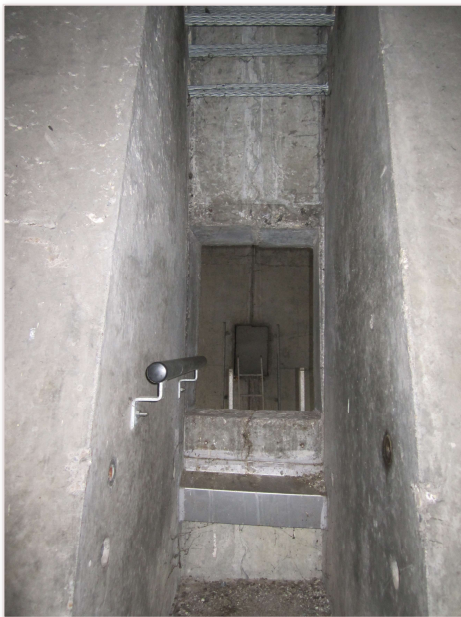
TRAPPE D'ACCES AUX PILES DU VIADUC EN SENS 2 OUVERTES EN NOVEMBRE 2013, VUES DEPUIS LE CAISSON
