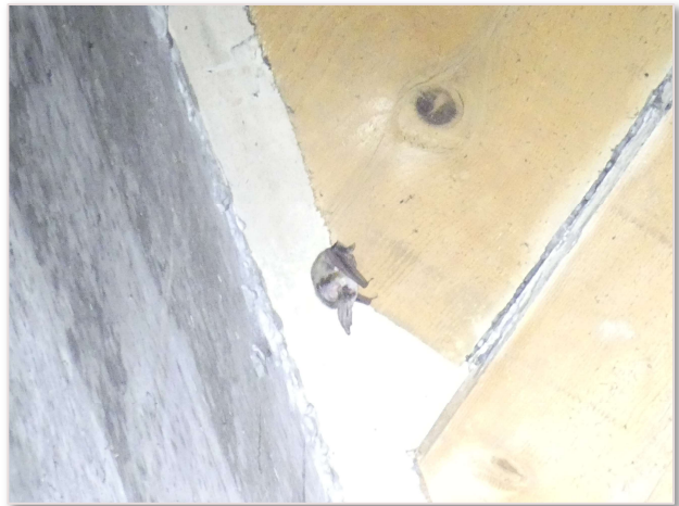
OREILLARD GRIS EN PLAFOND DANS LE VOLUME DE LA PILE P3 EN SENS 2
