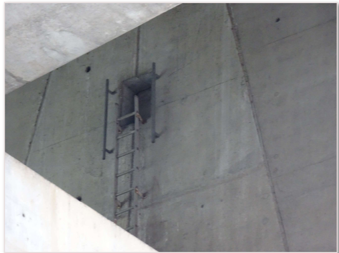
EN 2023, VUE D'UNE MEME TRAPPE D'ACCES DEPUIS L'EXTERIEUR, FERMEE
