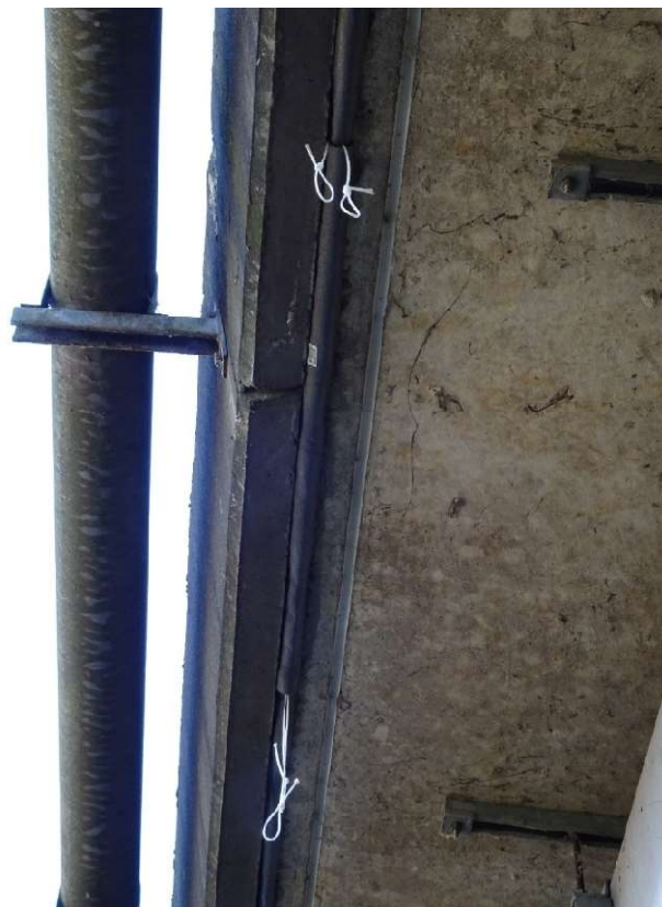
Figure 45. Illustration d'un manchon polypropylène entré en compression dans un espace corniche-tablier (Ribatto 2022, A40).
