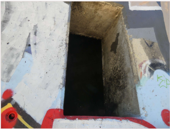
TRAPPE D'ACCES AU VOLUME DE LA PILE P3 EN SENS 2
