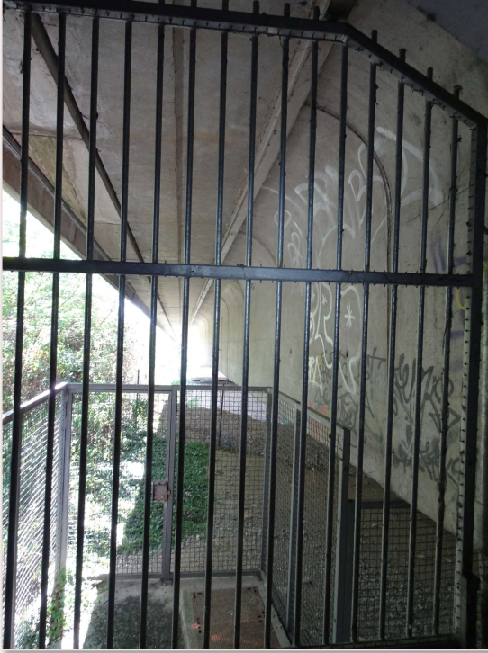
GRILLE DONNANT ACCES A LA CULEE C1 ET AUX CAISSONS DU VIADUC SENS2
