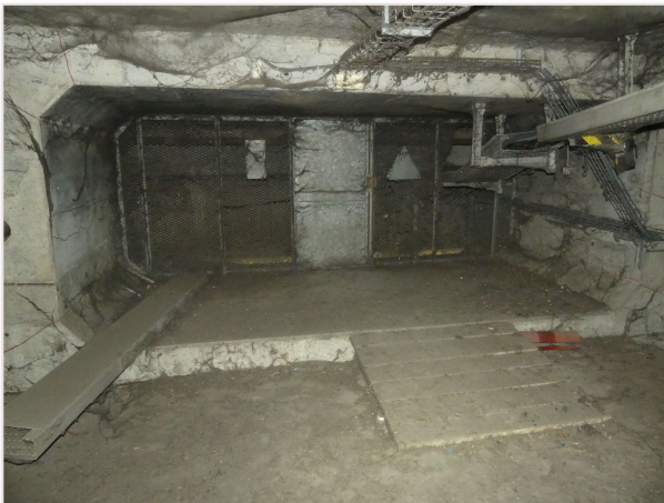
GRILLE ENTRE LE CAISSON ET LA CULEE EN SENS 1
