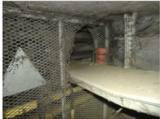
TROU DANS LE GRILLE POUR LE PASSAGE DE CABLE LE CAISSON ET LA CULEE EN SENS 1
