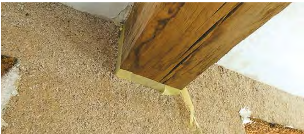
17. Noircissement d'une poutre apparente suite au contact avec la chaux.
