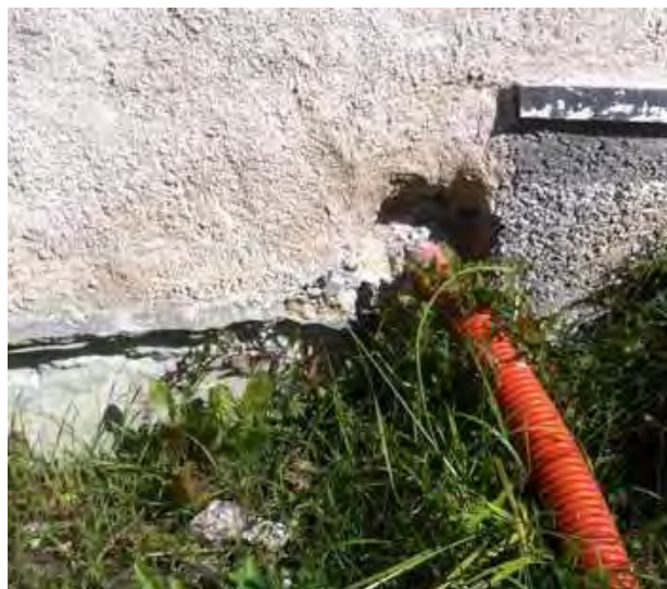
16. Pied de mur non conforme aux RP
