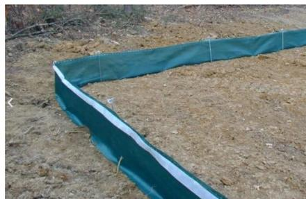
Figure 10: Exemple de barrière amphibien perméable
