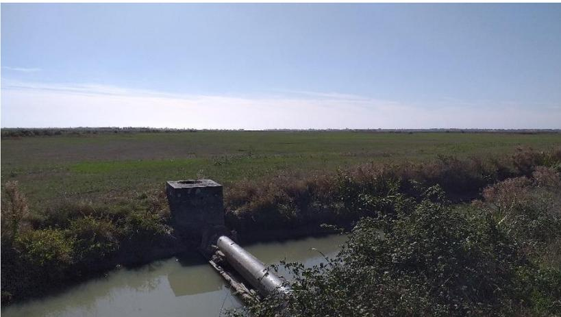
*Photo 5 - Franchissement d'un canal tertiaire (conduite existante visible à abandonner) – passage en souille en période d'assec*
