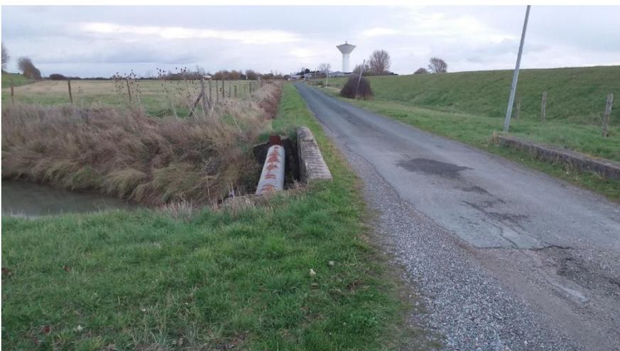
*Photo 27 - Passage de la conduite sous accotement sud de la voie communale (à droite sur la photo - conduite existante à abandonner à gauche sur la photo)*
