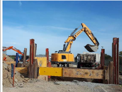
Mise en place du caisson n°3 en zone 4
