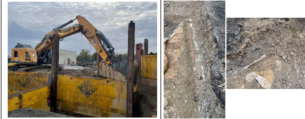
Terrassement en pleine masse de la zone 4
