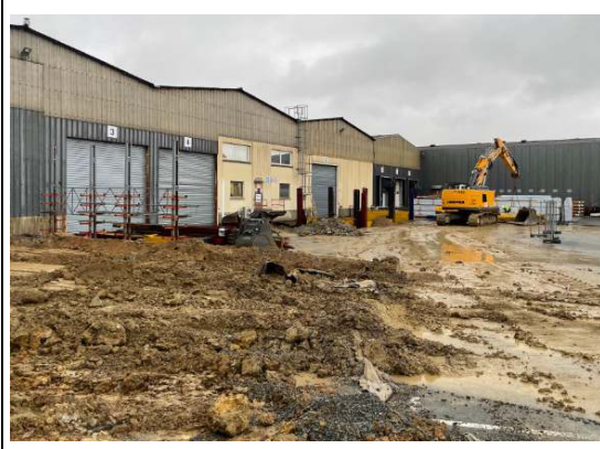
Remblaiement des caissons 1 et 2 de la zone 5
