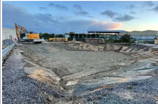
Remblaiement de la zone 4
