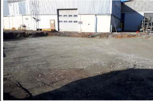
Remblaiement de la zone 4
