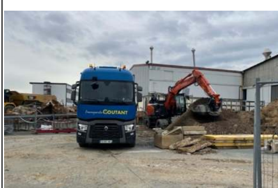
Chargement de semis des terres issues de la zone 1, 4 et des sablons de la cuve en zone 5
