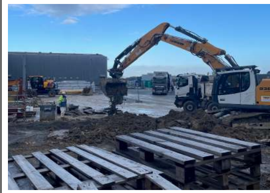
Tri des matériaux sur l'aire de stockage
