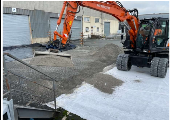
Mise en place de la zone de stockage
