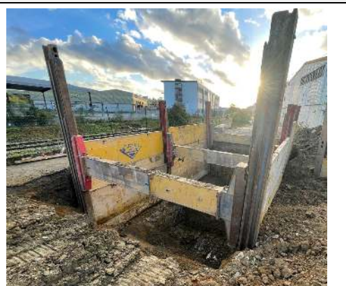
Mise en place du H du caisson n°4 en zone 4
