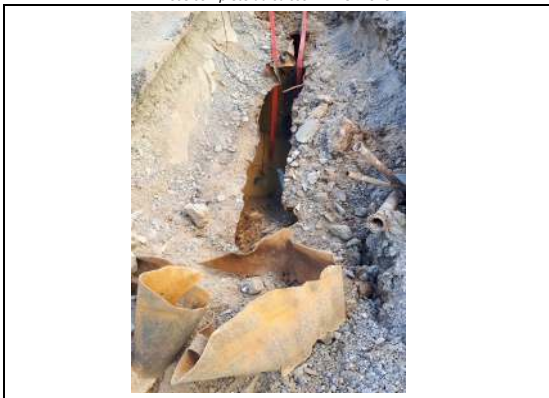
Vidange complète de la cuve en zone 1
