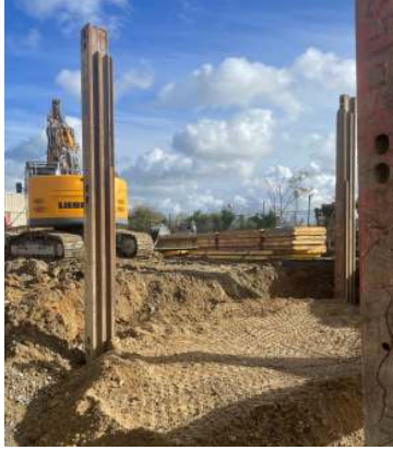
Remblaiement du caisson n°4
