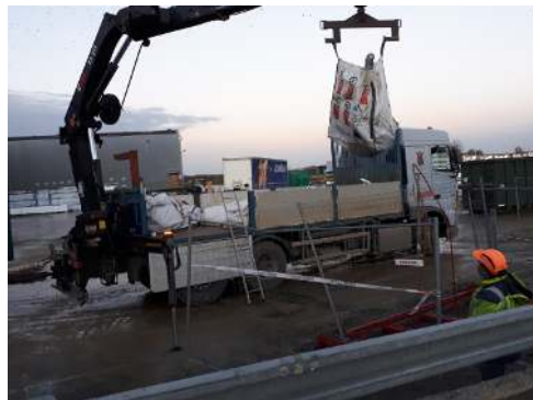
Evacuation des big-bags contenant les matériaux amiantés
