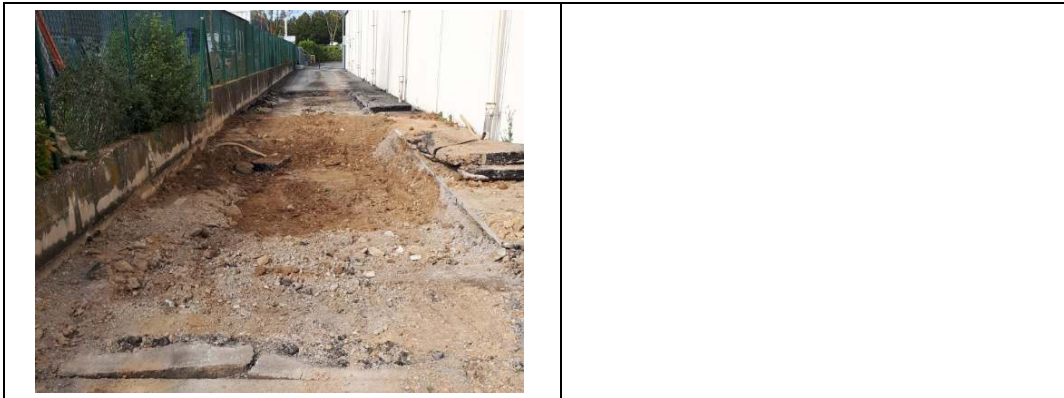
Remblaiement de la cuve en zone 1
