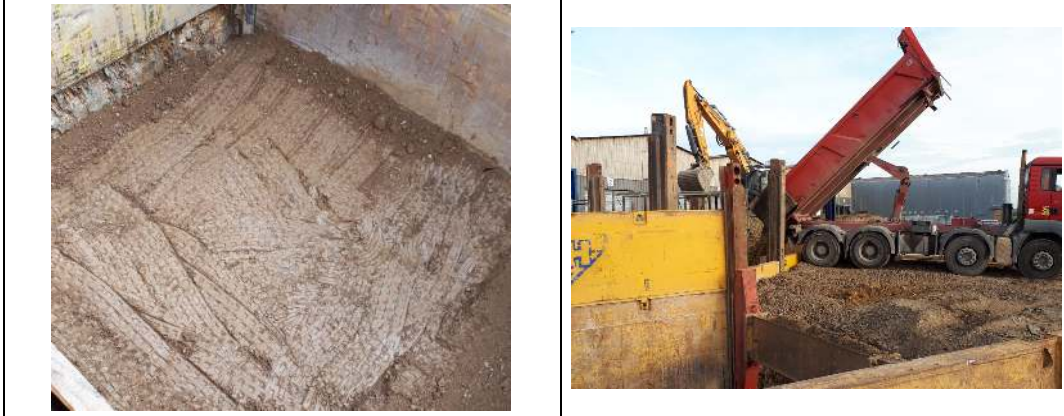
Remblaiement du caisson n°1 en zone 4
