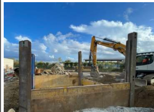
Mise en sécurité de la zone de terrassement
