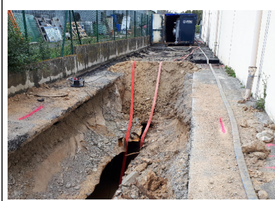
Pompage de la cuve en zone 1 avant remblaiement de cette dernière
