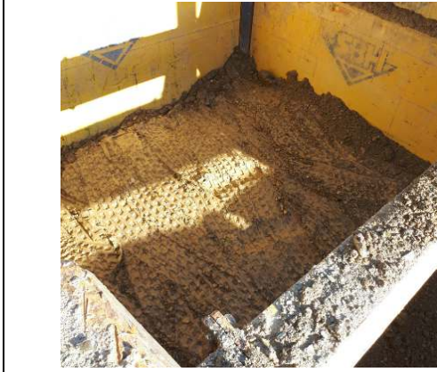
Compactage du caisson 2 en Z5
