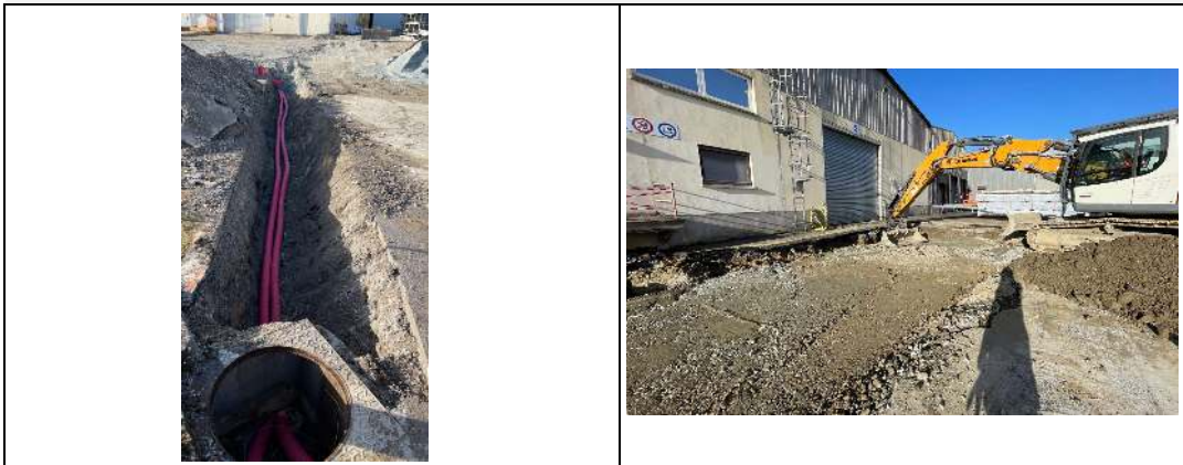
Passage des fourreaux
