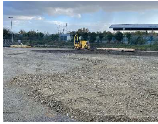
Remblaiement de la zone 4
