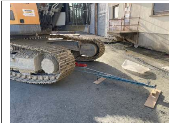
Réalisation des essais de plaques sur la zone 4 et 5
