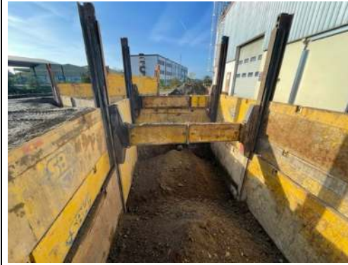
Remblaiement des caissons n°3 et 4 en zone 4
