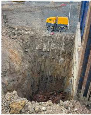
Terrassement en pleine masse
