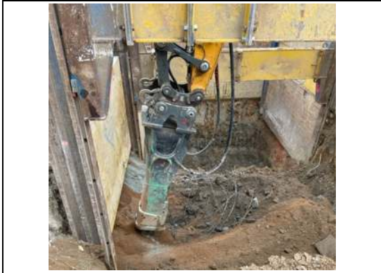
Démolition du radier de la cuve en zone 4
