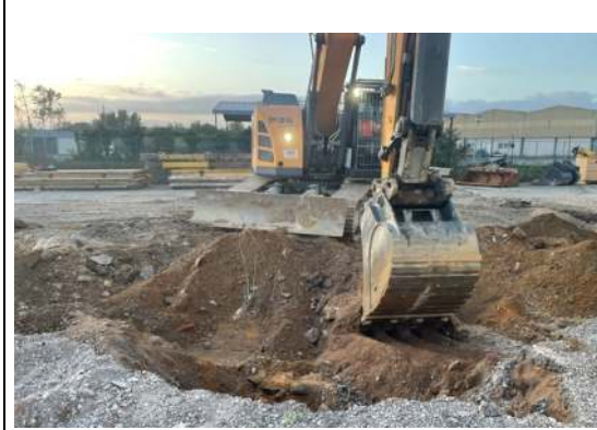
Démarrage de la préfouille du caisson n°1
