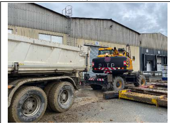
Terrassement de la zone 5
