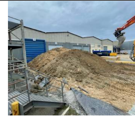
Zone de stockage
