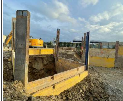
Terrassement du caisson n°5
