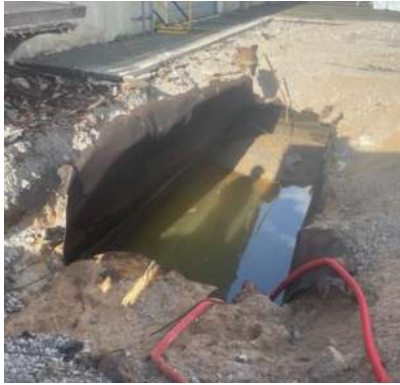
Pompage des eaux présentes dans la cuve en zone 5
