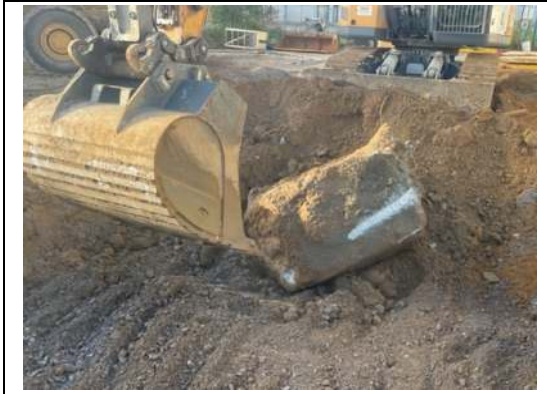
Découverte de fondations lors de la préfouille
