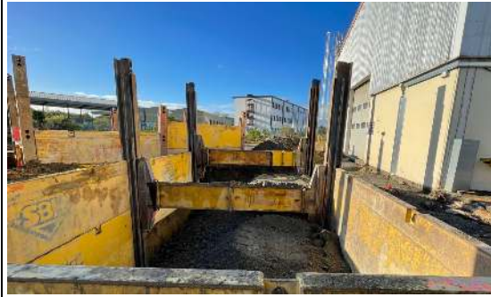
Retrait des panneaux côté bâtiment
