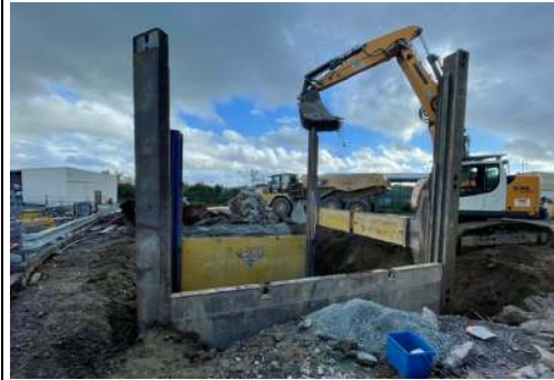
Mise en place du caisson n°1
