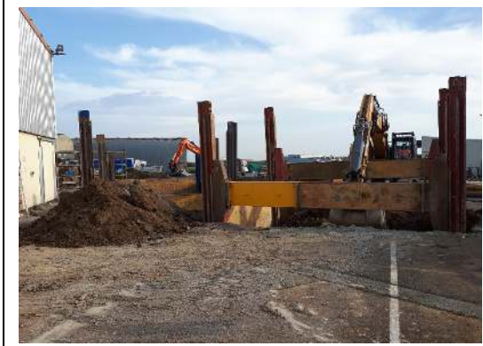
Terrassement dans le caisson n°3 en zone 4
