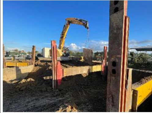
Retrait des blindages du caisson 4
