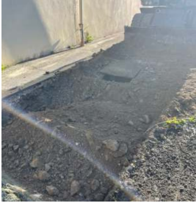
Découverte de la cuve sur la zone 1
