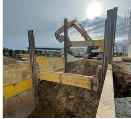
Mise en place du caisson n°2
