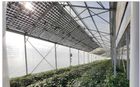
Serre photovoltaïque de Grisolles (82). Passage de lumière versant Sud 17%. Utilisation : maraîchage diversifié en agriculture biologique
