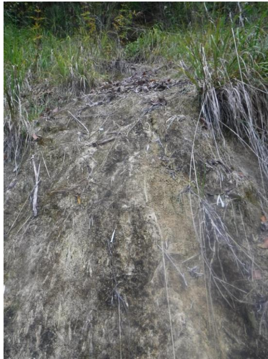
Figure 240 : Tuf identifié sur site
