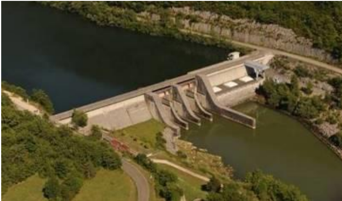
Figure 7 : Vue aérienne de l'aménagement de Coiselet
