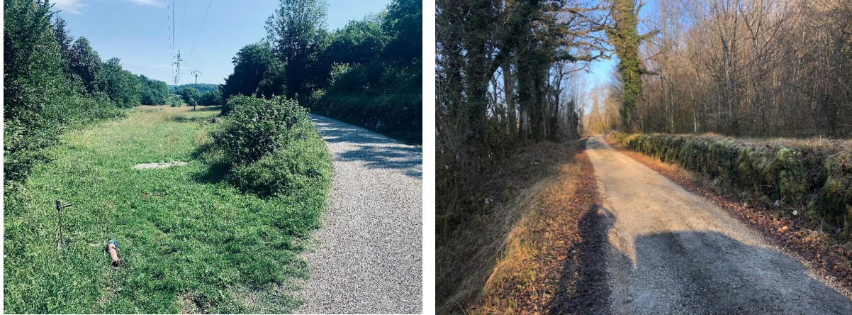
Figure 16 : Piste communale existante à élargir (à gauche) et vue des murs de soutènement amont (à droite)
