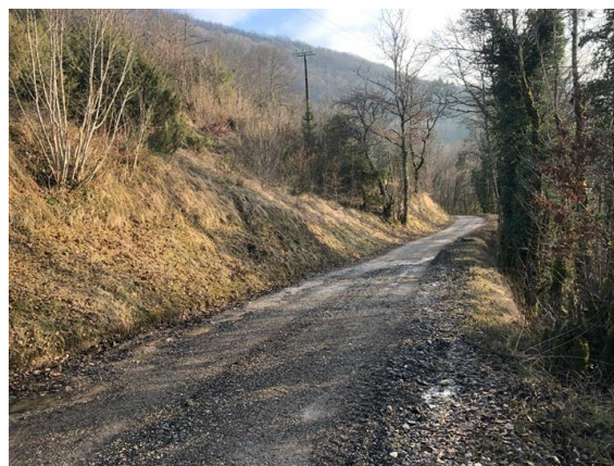
Figure 19 : Piste communale à élargir pour accéder à la plateforme usine
