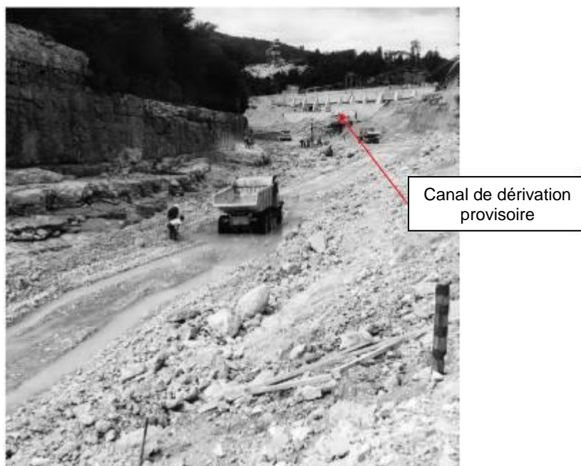
Figure 66 : L'Ain à l'aval de Saut-Mortier lors des travaux de recalibrage de 1962
