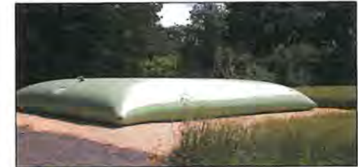
Figure 3 : Exemple de citerne incendie capable d'accueillir 1000 litres (source : H&M Quadrant)
