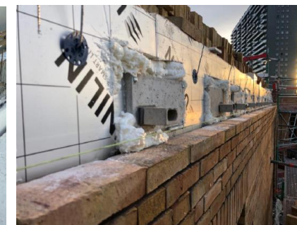
Dans l'isolation extérieure
