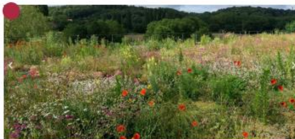
TOITURE VÉGÉTALISÉE : GRAMINÉES ET VIVACES
