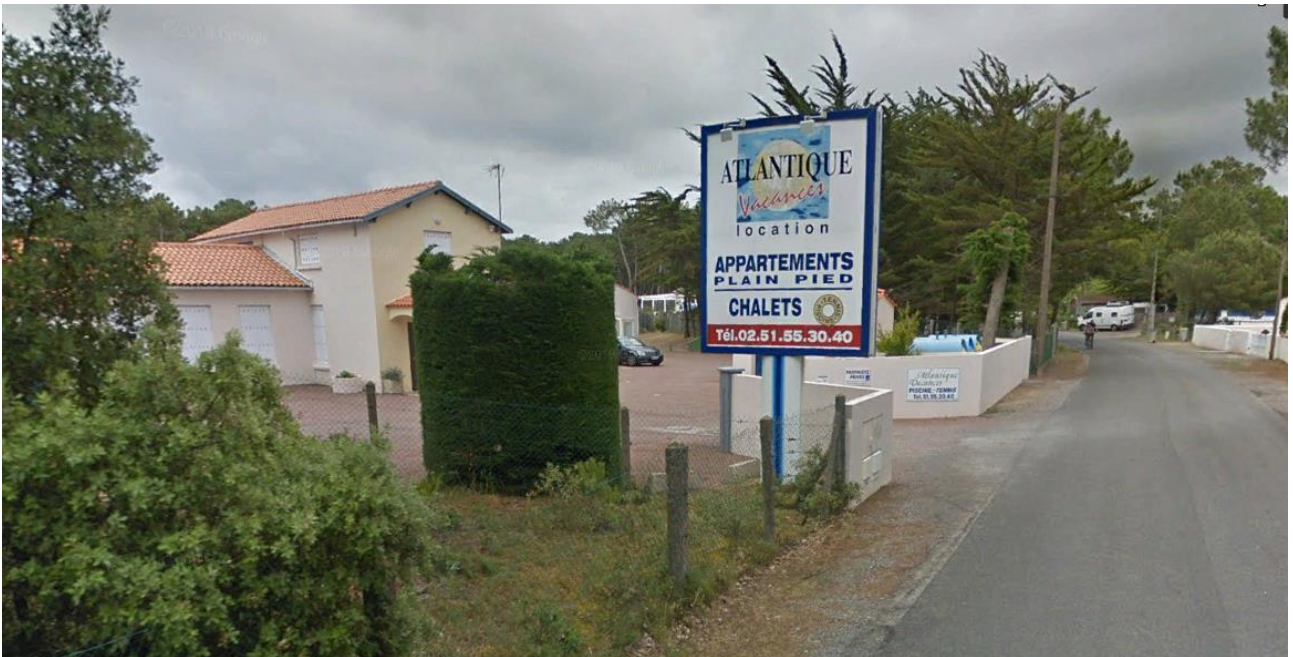
Figure 11 - Vue sur l'entrée - chemin de la Conge (d'Ouest en Est)
