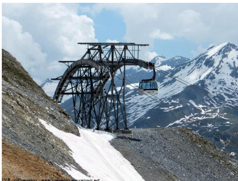
Exemple de pylônes imposants pour un appareil de type 3S ou 2S\_remontées - mécaniques.net
