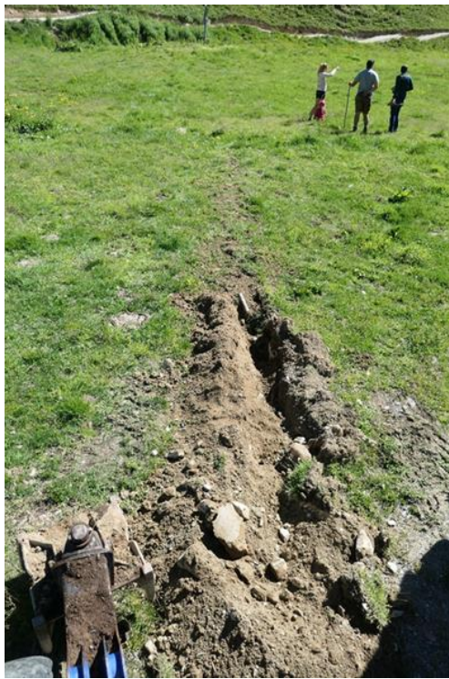
Etape 2 : Remise en place manuelle des mottes (source : KARUM)
