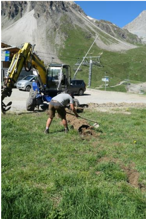
Etape 2 : Remise en place manuelle des mottes (source : KARUM)
