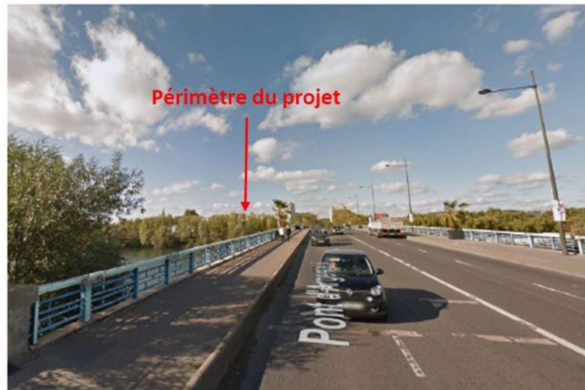
Figure 103 - Vue sur le périmètre du projet depuis le pont d'Argenteuil (5)
