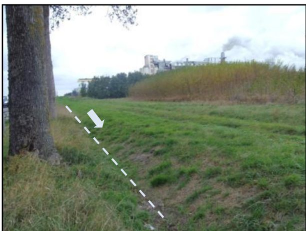
10 : Fossé de la route départementale, vue vers GIE La Chardonneuse
