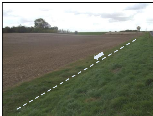
11 : Fossé de la route départementale, vue vers Pauvres
