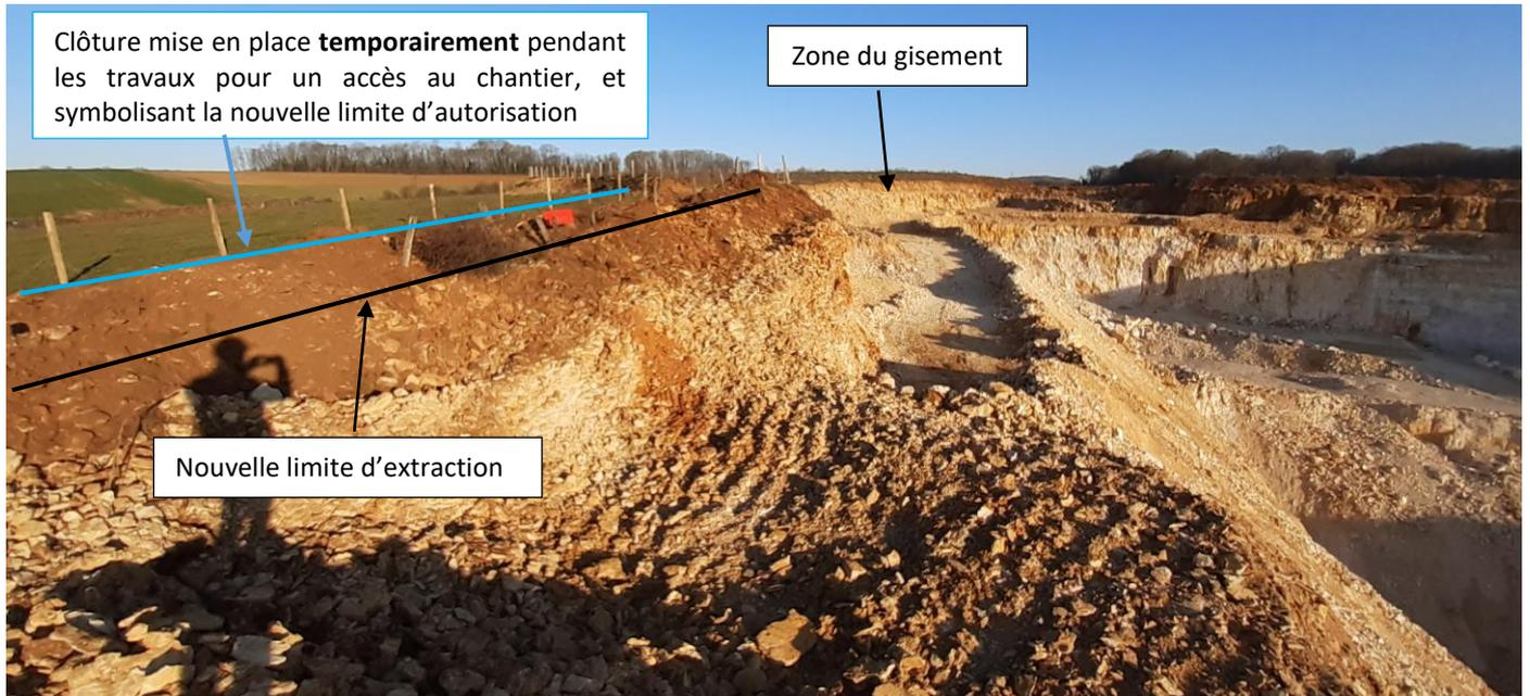
Figure 4 Travaux d'abaissement de la piste Ouest de la carrière de Scy-Sur-Saône
