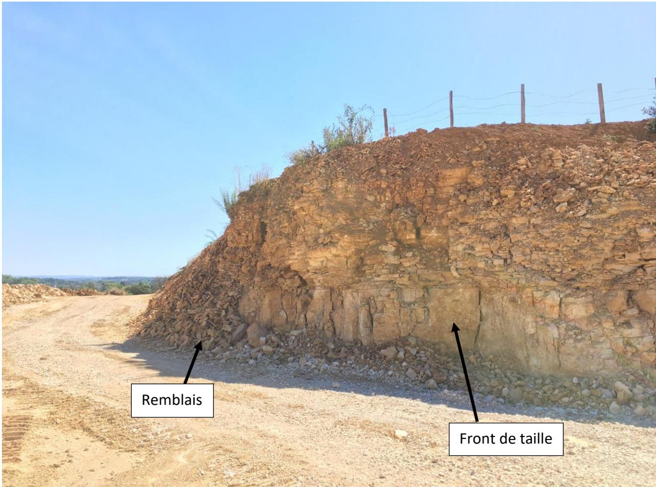
Figure 9 Front de taille stable à l'extrémité Nord de la piste d'accès
