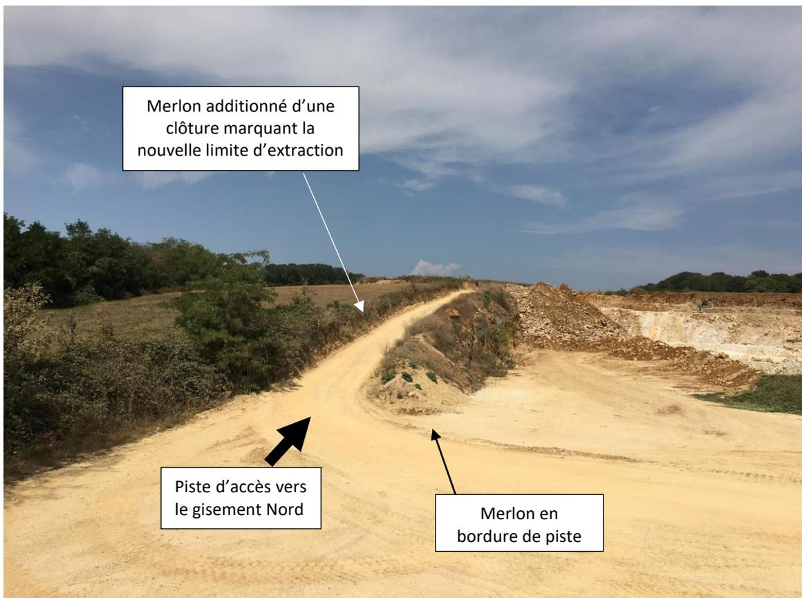
Figure 7 Piste d'accès au gisement Nord et merlons périphériques
