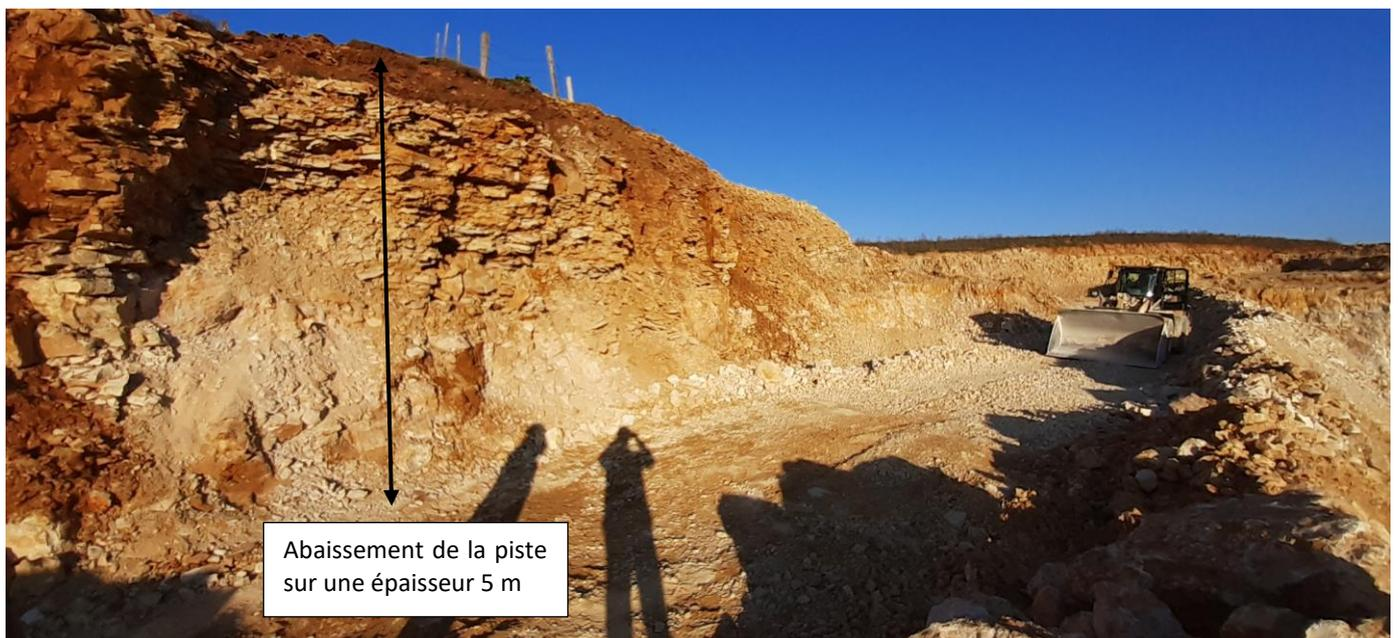
Figure 5 Travaux d'abaissement de la piste Ouest de la carrière de Scy-Sur-Saône
