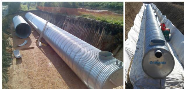
**Exemples de cuve de rétention des eaux pluviales**
