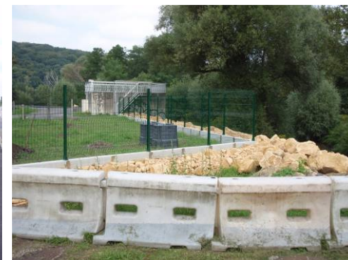
Mur en L coté RN 3 avec empierrement
