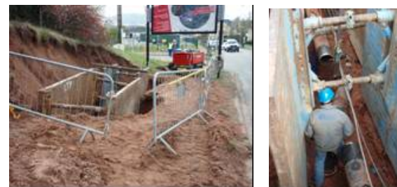
La tranchée d'accès à la fuite le long de la rocade Nord - Les travaux de réparation
