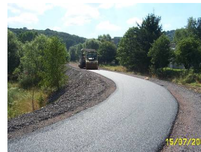
Le rehaussement de la digue et la réalisation de l'enrobé de la piste cyclable
