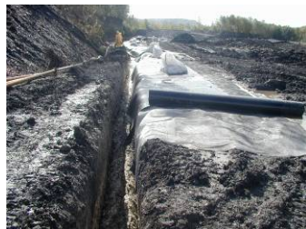
Raccord de la membrane sur la paroi
