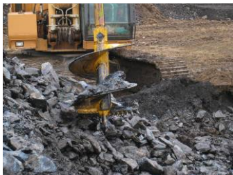
Le forage des puits à la tarière
