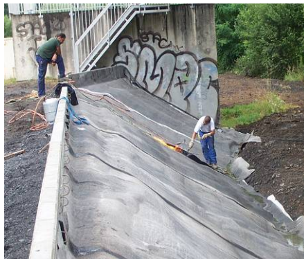
Pose de la géomembrane
