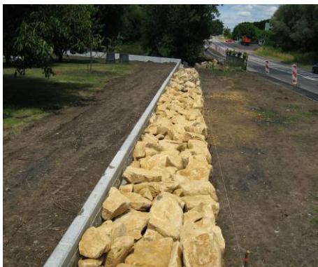
Enrochement le long du muret en L
