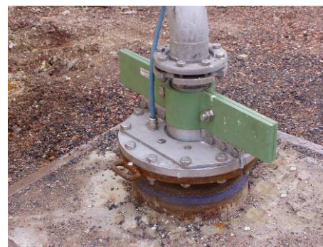
Le raccord étanche en tête de puits
