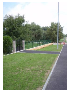
Mur en L coté RN 3 avec empierrement
