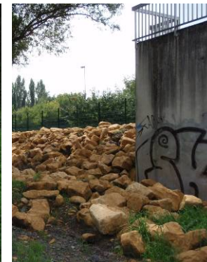
Mur en L coté Weihergraben avec empierrement
