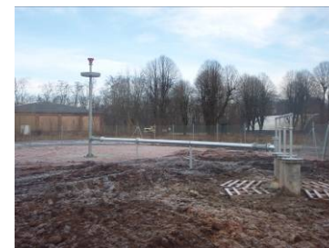
Raccordement des conduites du puits à l'exutoire
