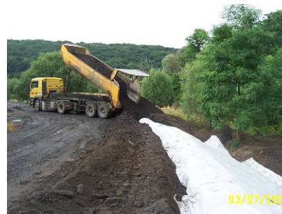
Le rehaussement de la digue et la réalisation de l'enrobé de la piste cyclable
