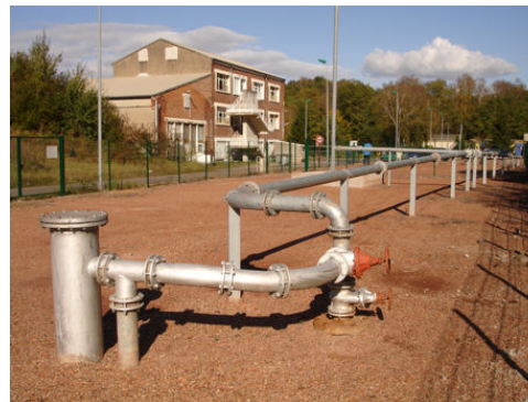
Les conduites de gaz sortant des puits 1-2 La Houve vers l'exutoire gaz
