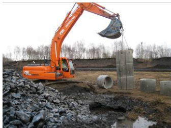
La pose des puits de surveillance
