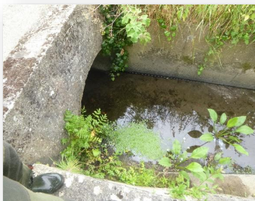
Radier béton soutenant un passage busé situé sur Port Royal (D97)
