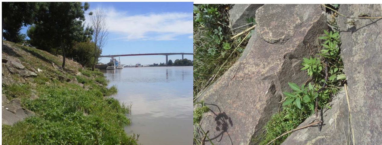
Exemple d'aménagement en simple talus à enrochement à Saint-Herblain, jeune pied d'angélique poussant entre les blocs
