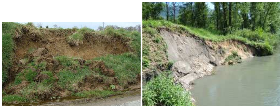
Exemple de glissement de talus – évolution à moyen terme
