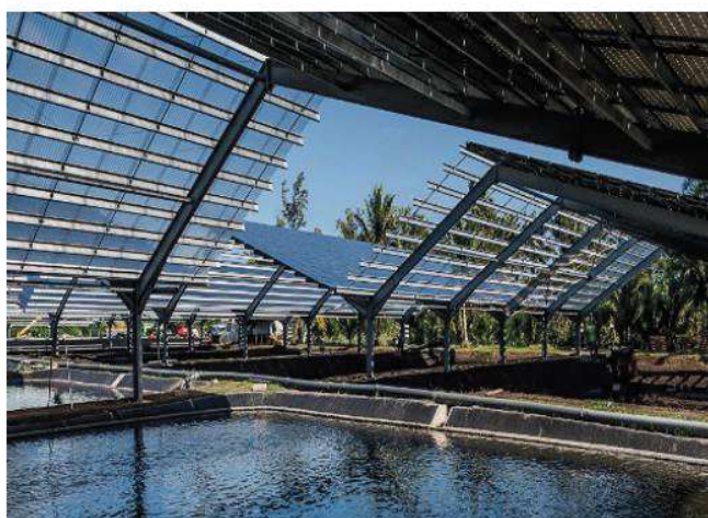
Figure 12 : Exemple d'ombrière photovoltaïque installée au-dessus de bassins aquacoles à La Réunion
