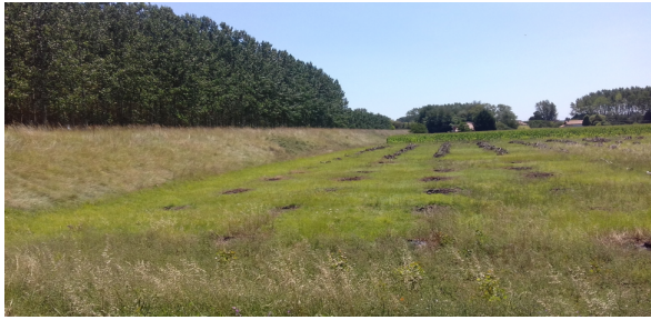
Illustration 34 : Digue proche Marmande - © Cerema
