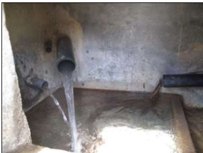
Illustration 12 : Photographie de l'intérieur du captage de Pietravezza 1
