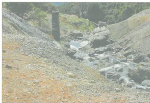
Les berges de la Presa sont couvertes d'arsénolite.
