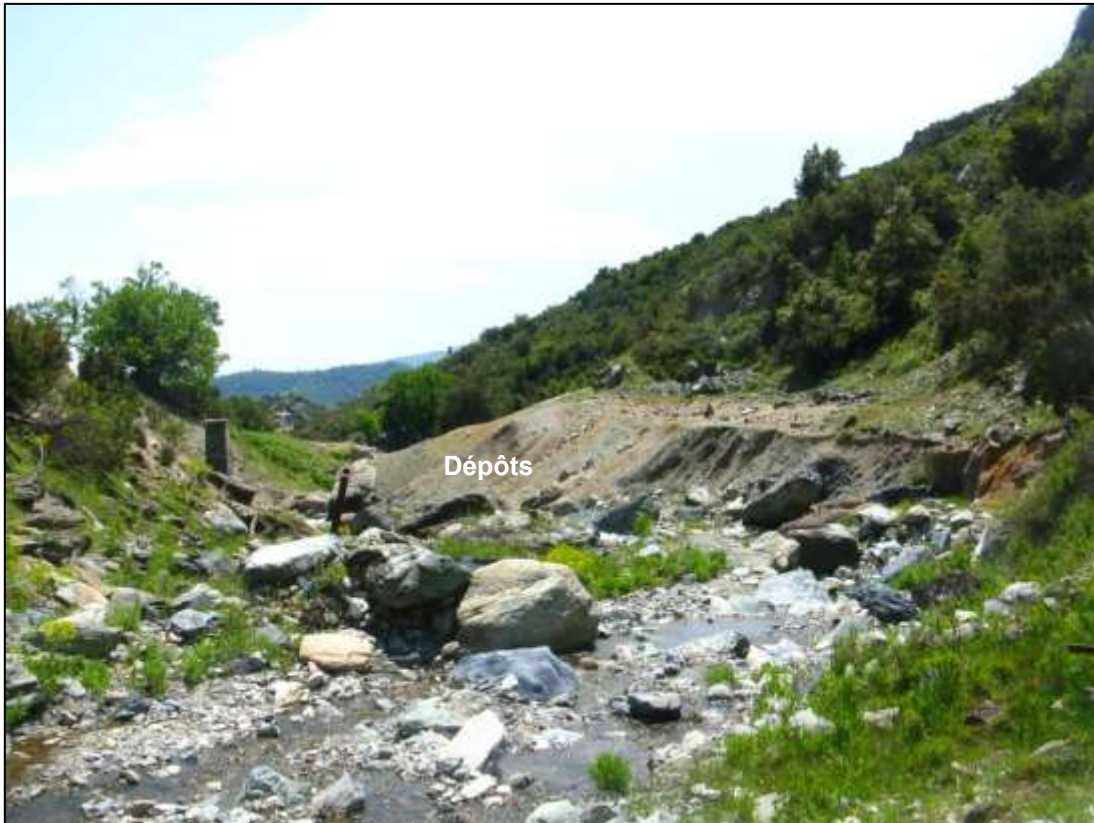
Illustration 9 : Dépôts situés en aval de l'exutoire de la galerie n°2, au niveau de l'ancien pont
