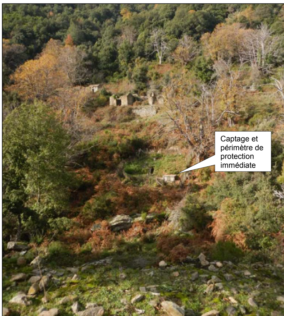
Illustration 13 : Environnement du captage de Pietravezza 1. La photographie a été prise depuis la Presa.
