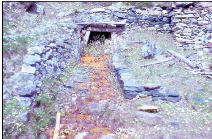
Figure 27 : Etat de la galerie G2 en 1970 (DOMMANGET, 2004)
