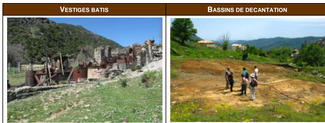
Figure 8 : Vestiges de l'usine de flottation et bassins de décantation associés
