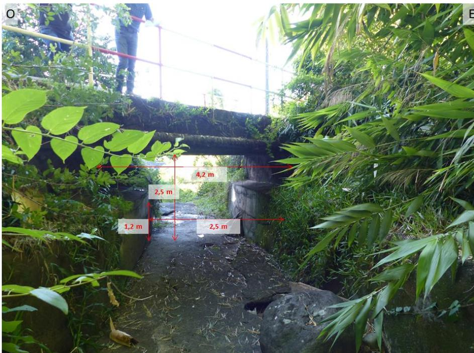
Figure 7 : Ouvrage hydraulique de franchissement du Chemin Jacquemin en amont de la parcelle BV98
