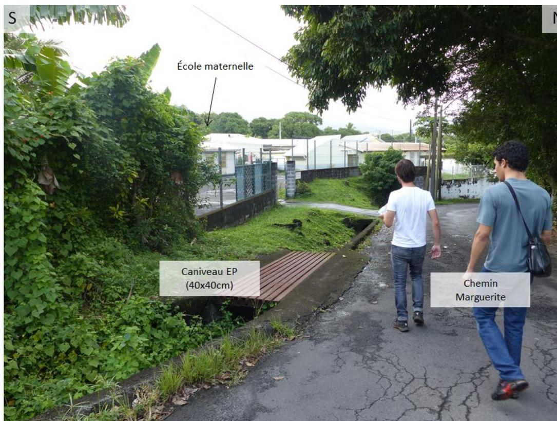
Figure 24 : Ouvrages de gestion des eaux pluviales en aval de la parcelle BM83
