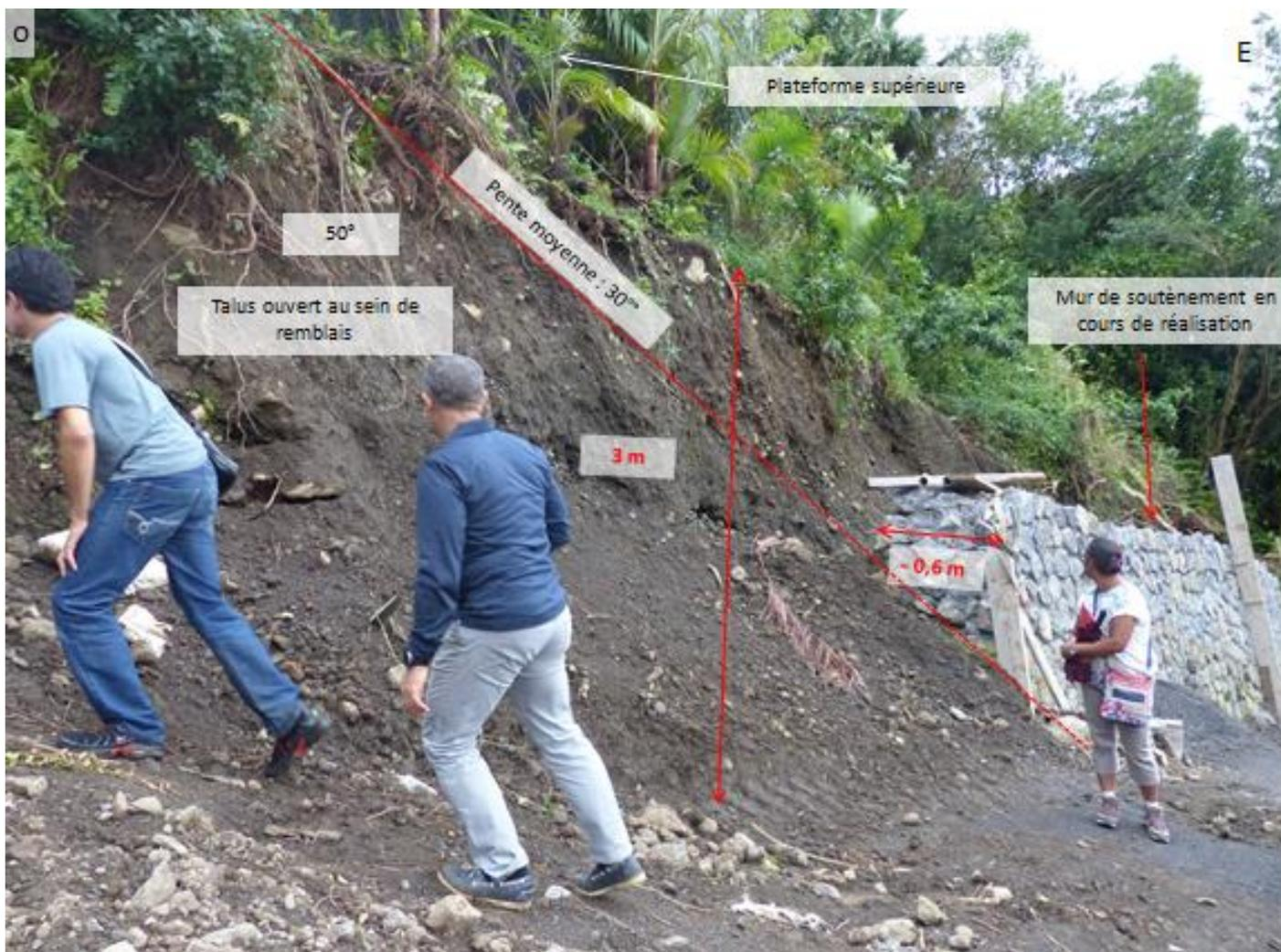
Figure 36 : Talus aval de plateforme amont raidi et mur de soutènement en cours de réalisation
