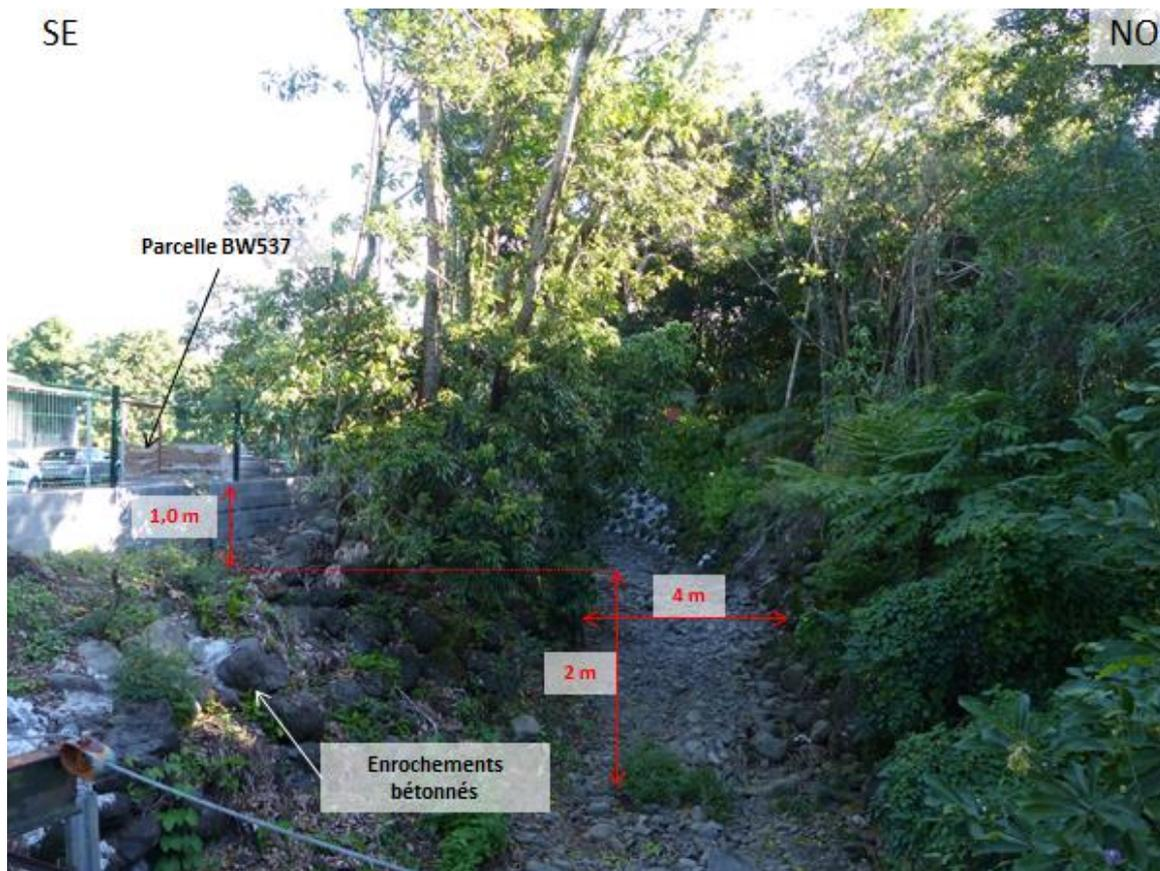
Figure 11 : Morphologie du cours d'eau et ouvrages d'endiguement au droit de la parcelle BW537
