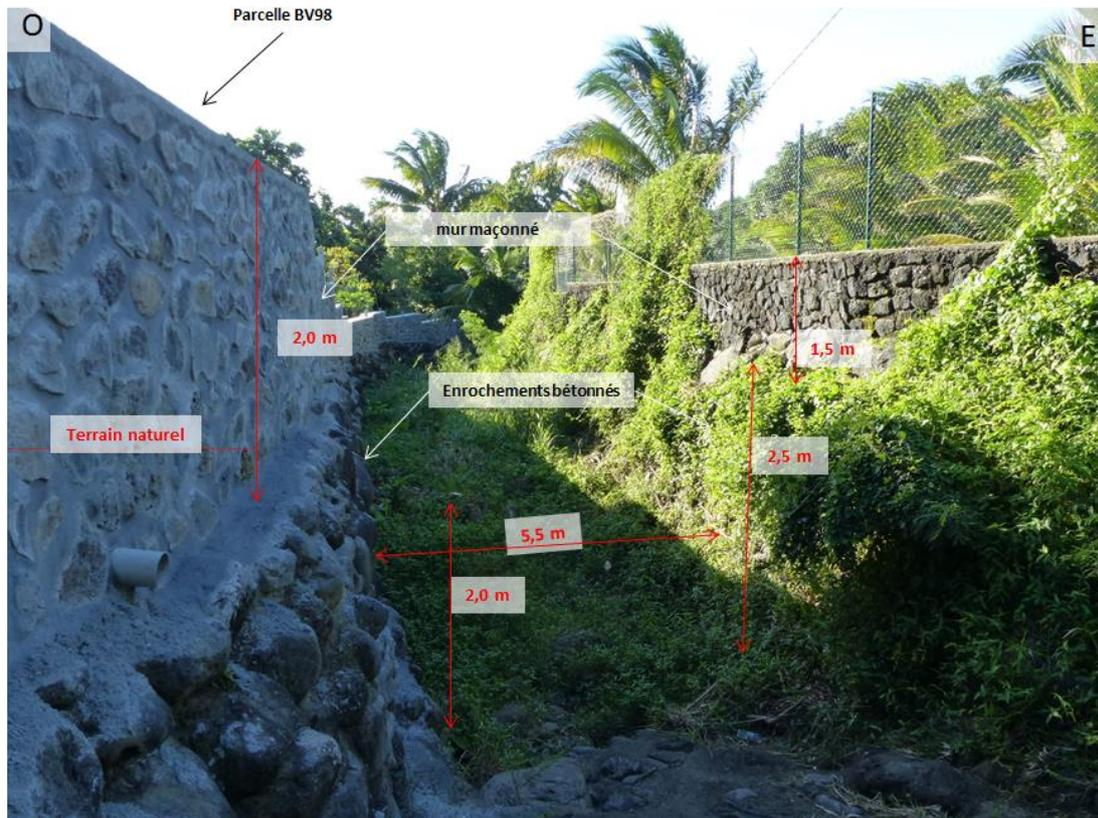
Figure 8 : Morphologie du cours d'eau et ouvrages d'endiguement au droit de la parcelle BV98 (partie amont)
