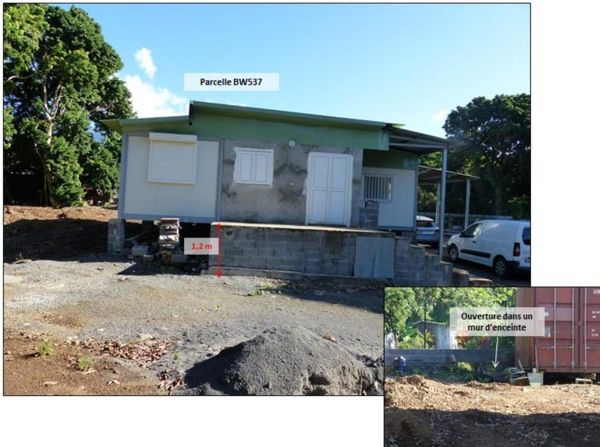
Figure 13 : Disposition constructives existantes vis-à-vis des eaux de ruissellement sur la parcelle BW537 (surélévation du premier plancher et ouvertures au sein des murs d'enceinte)
