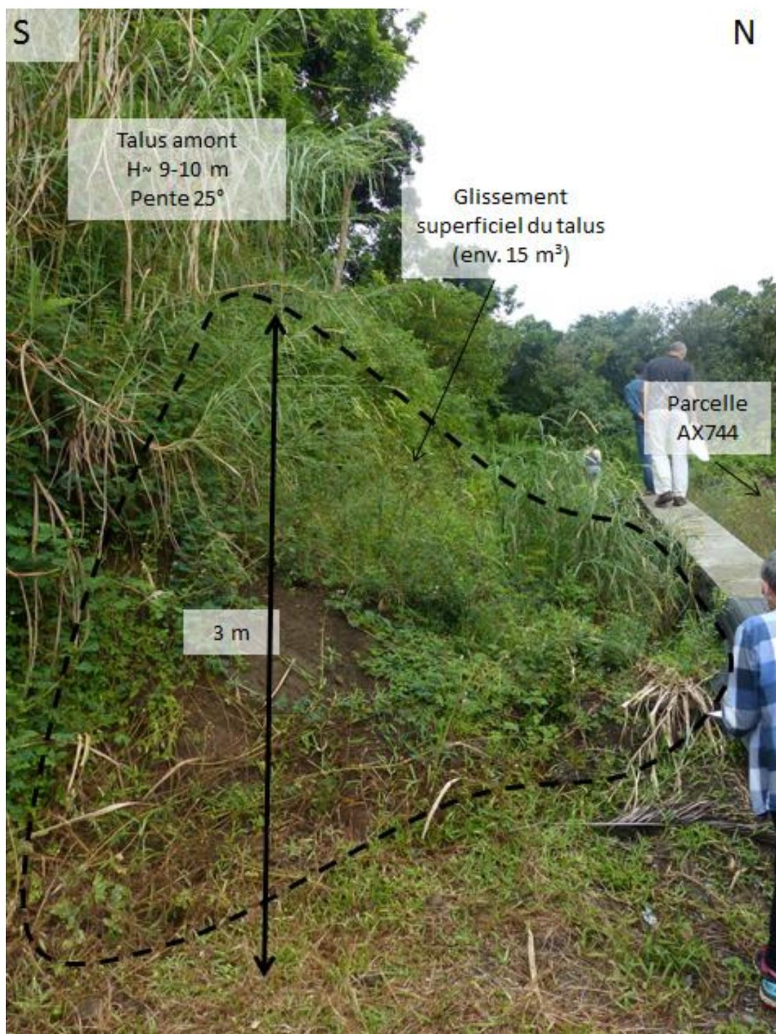
Figure 53 : Talus au sud-est de la parcelle AX744 et constat d'un glissement superficiel récent
