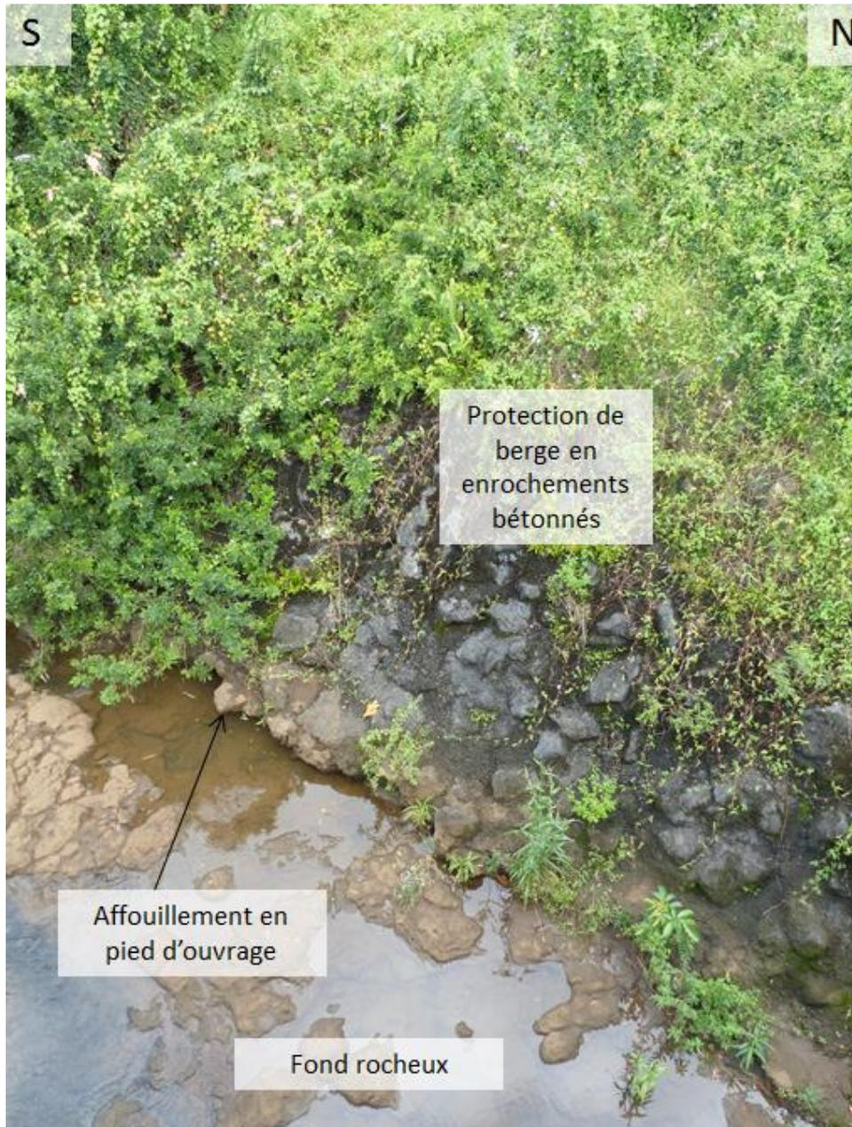
Figure 29 : Ouvrage de protection des berges en enrochements bétonnés (en rive gauche en amont immédiat du pont de la RD54)
