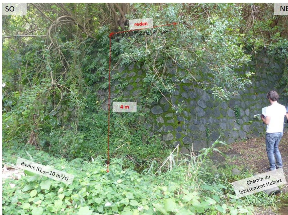
Figure 32 : Ouvrage de soutènement (mur aval) au droit de la parcelle AE333
