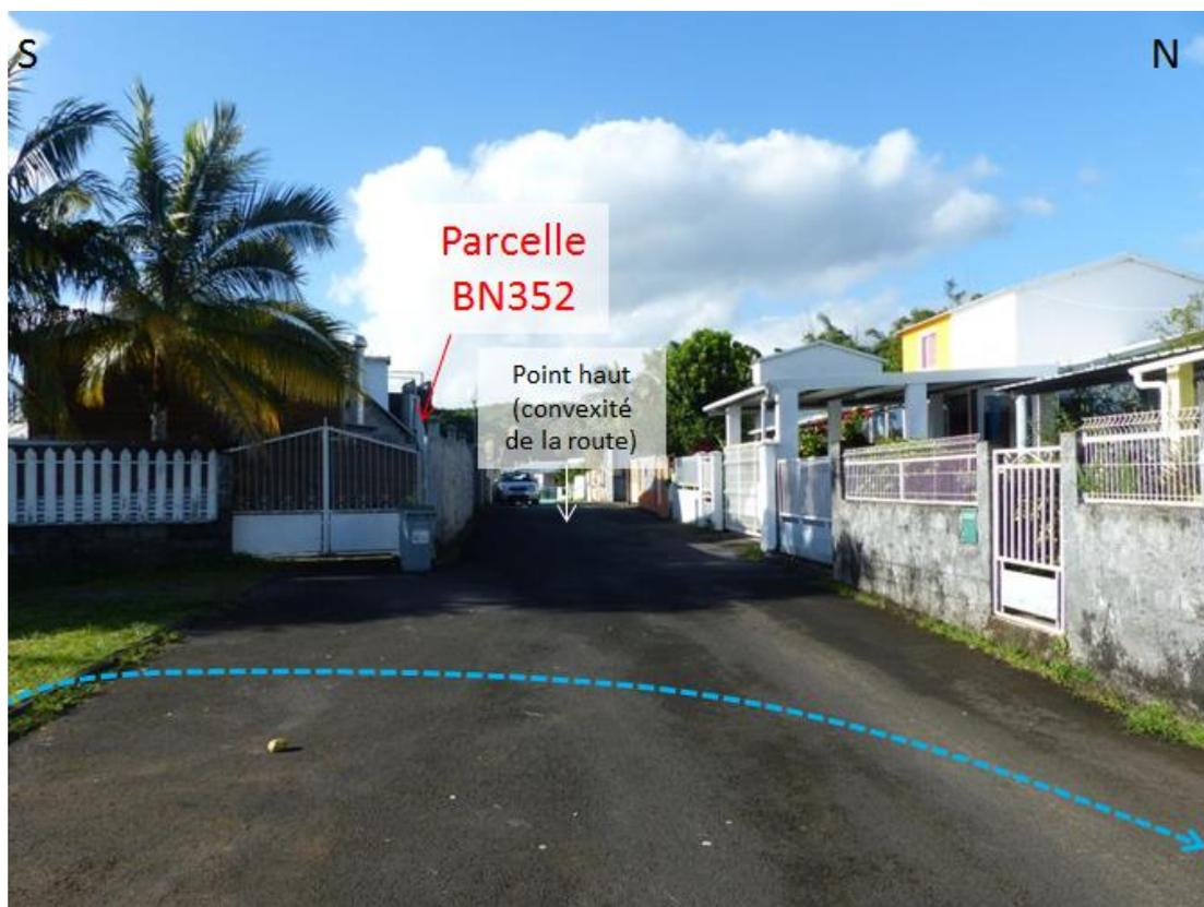
Figure 2 : Conditions d'écoulement des eaux en aval immédiat de la parcelle BN352
