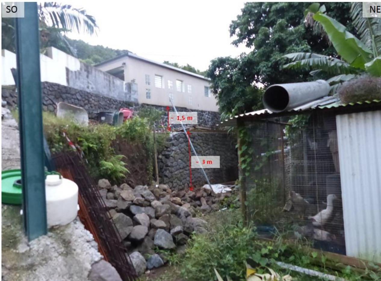
Figure 49 : Plateforme terrassée en recul immédiat de la rupture de pente sur la parcelle AH677
