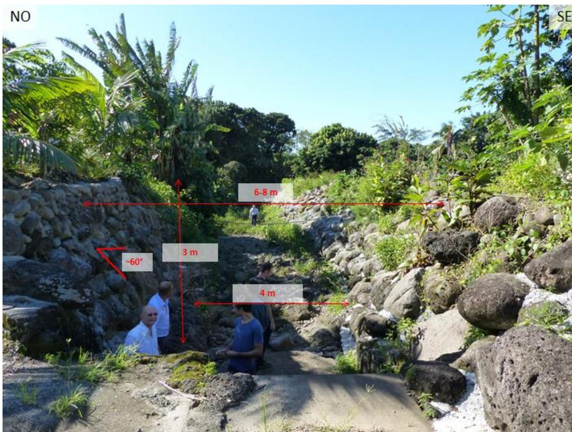
Figure 10 : Morphologie du cours d'eau et ouvrages d'endiguement en amont de la parcelle BW537
