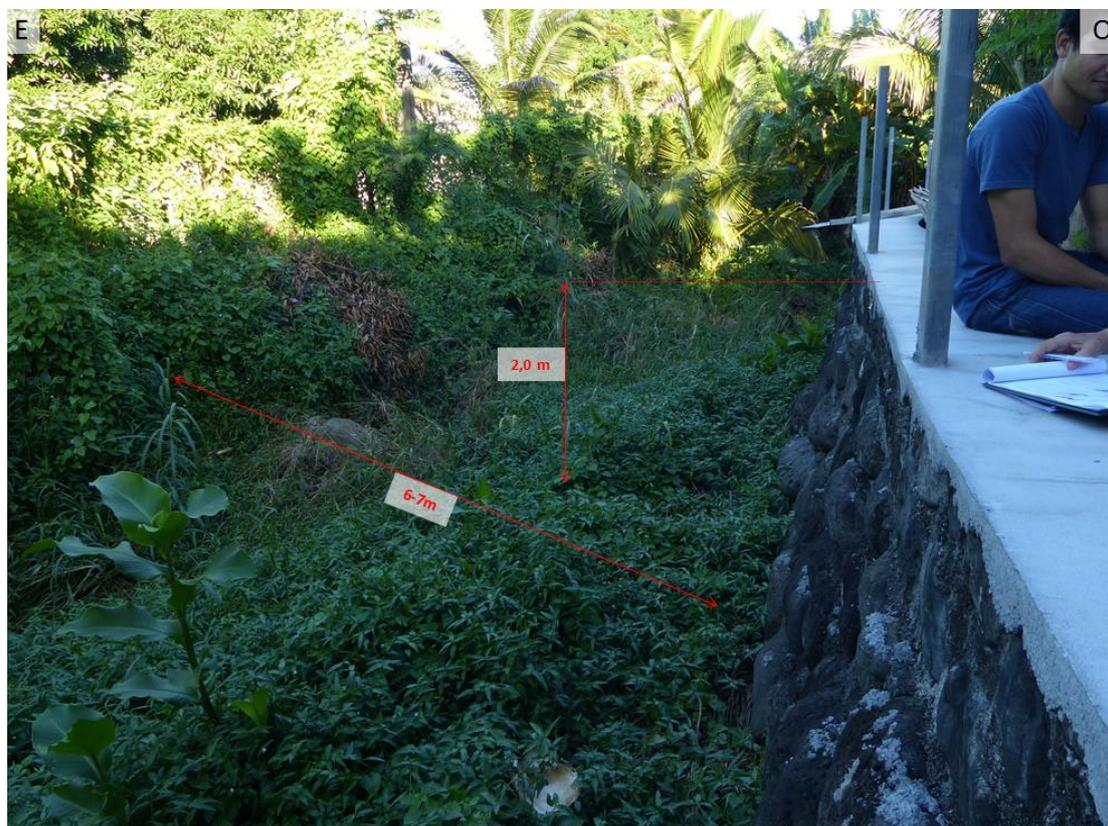
Figure 9 : Morphologie du cours d'eau et ouvrages d'endiguement au droit de la parcelle BV98 (partie aval)
