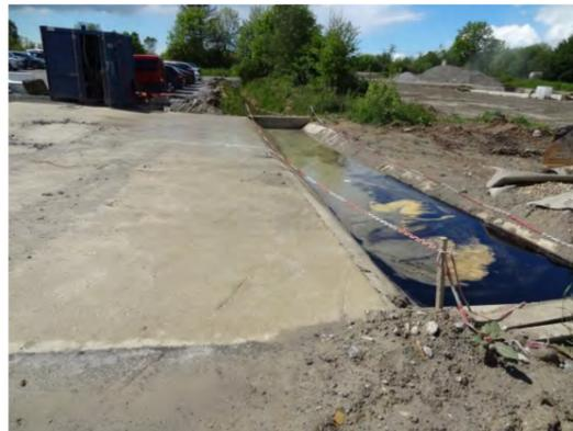
**Photographie 19 : Exemple de bassin de stockage de produits polluants, d'aire de lavage de goulotte de toupies et d'aire de lavage d'engins équipée en sortie d'un débourbeur-déshuileur (© Egis / D. Ferreira)**
