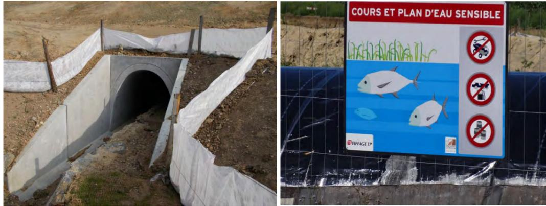
Photographie 21 : Principe d'implantation de clôtures géotextile pour protéger le cours d'eau du Petite Doré et sa ripisylve et panneau de sensibilisation (© Egis / D. Ferreira)
