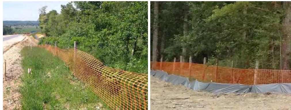
Photographie 37 : Barrière-type de délimitation d'emprise de chantier (© Egis)
