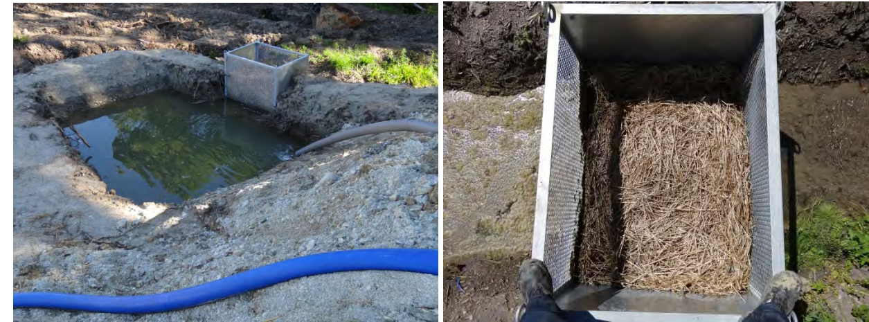
Photographie 45 : Exemples de dispositifs d'assainissement provisoire mis en place en phase travaux (© Egis / D. Ferreira)
