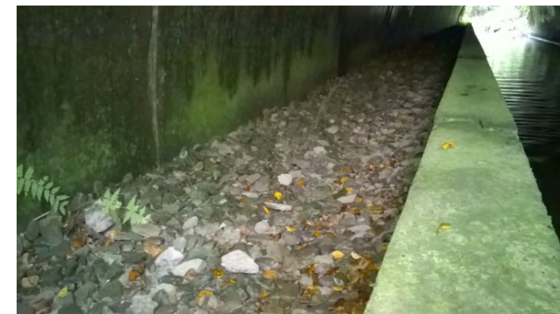
Photographie 36 : Ouvrage de rétablissement actuel du cours d'eau du Petit Doré sous la RN164 actuelle et sa banquette
