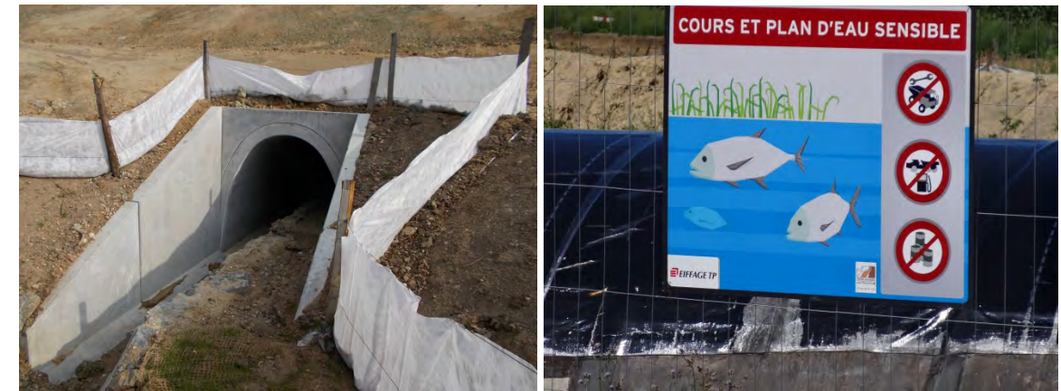
Photographie 47 : Principe d'implantation de clôtures géotextile pour protéger le cours d'eau du Petite Doré et sa ripisylve et panneau de sensibilisation (© Egis / D. Ferreira)
