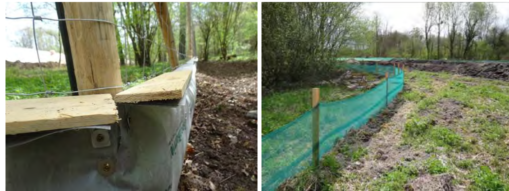
Photographie 39 : Exemple de fixation de bavolet et barrières anti-intrusion posées (© Egis)
