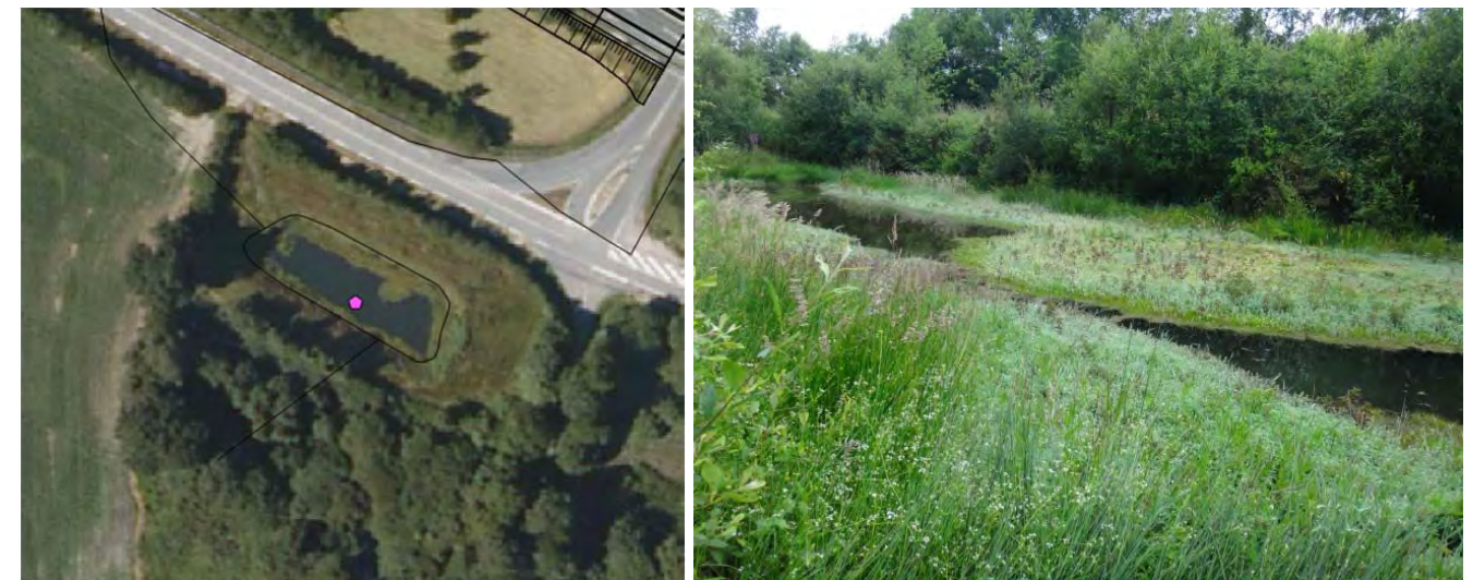
Figure 11 : Localisation de la station dans la zone d'étude et bassin de Kermaudez (© Althis)
