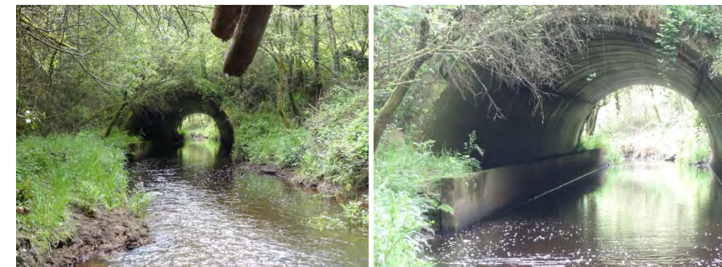
Photographie 2 : L'ouvrage mixte hydraulique-faune du Doré à l'état actuel
