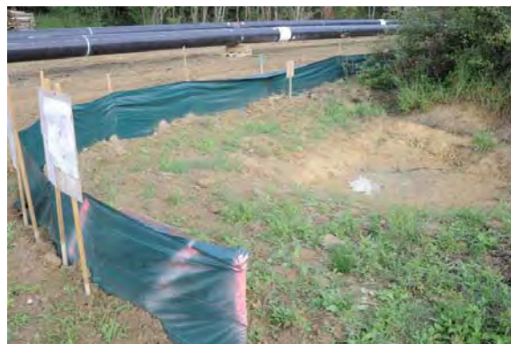
Photographie 40 : Coude de retournement en limite d'emprises du chantier (© Egis)
