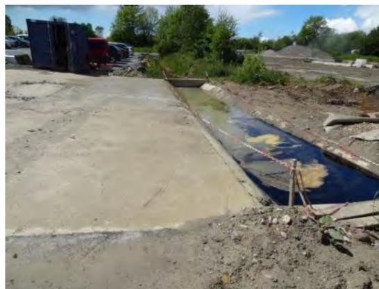
Photographie 46 : Exemple de bassin de stockage de produits polluants, d'aire de lavage de goulotte de toupies et d'aire de lavage d'engins équipée en sortie d'un débourbeur-déshuileur (© Egis / D. Ferreira)
