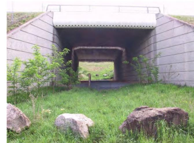
De manière à diminuer au maximum l'effet tunnel, il est prévu des murs en en retour ou en aile qui permettront également d'optimiser l'éclairage et les possibilités de développement de la végétation à l'intérieur de l'ouvrage.
