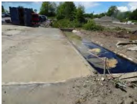
**Photographie 41 : Exemple de bassin de stockage de produits polluants, d'aire de lavage de goulotte de toupies et d'aire de lavage d'engins équipée en sortie d'un déboureur-déshuileur (© Egis / D. Ferreira)**
