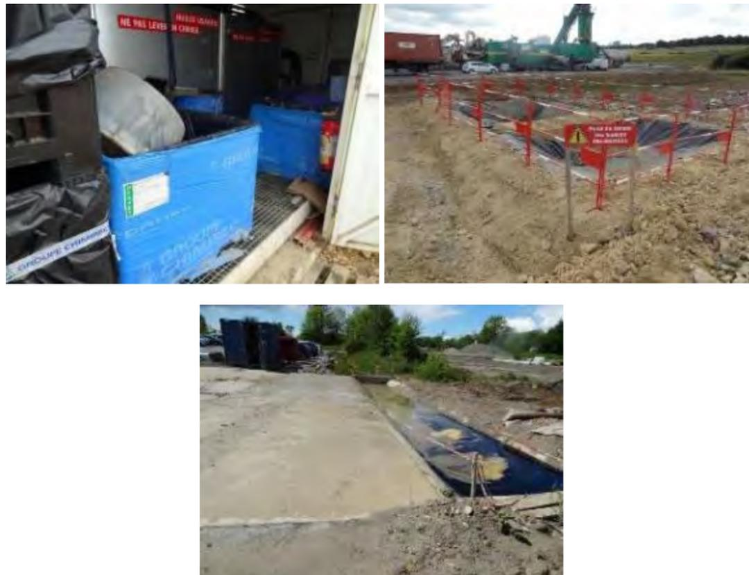
**Photographie 44 : Exemple de bassin de stockage de produits polluants, d'aire de lavage de goulotte de toupies et d'aire de lavage d'engins équipée en sortie d'un débourbeur-déshuileur (© Egis / D. Ferreira)**
