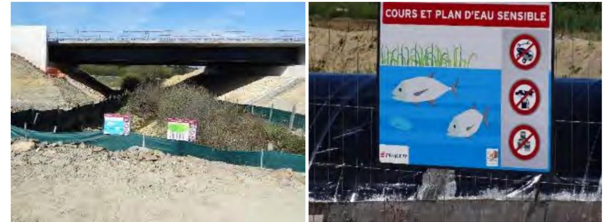
**Photographie 39 : Exemple de protection de cours d'eau par clôtures géotextile sous un ouvrage de type cadre ouvert avec préservation de la végétation rivulaire et exemple de signalétique de la FNTP pour la protection de cours d'eau (© Egis / D. Ferreira)**
