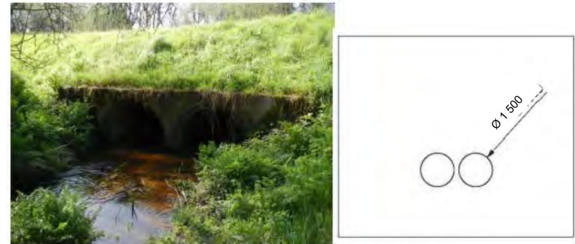
Figure 3 : Ouvrages sous la RN164 actuelle : 2 Ø1500 mm
