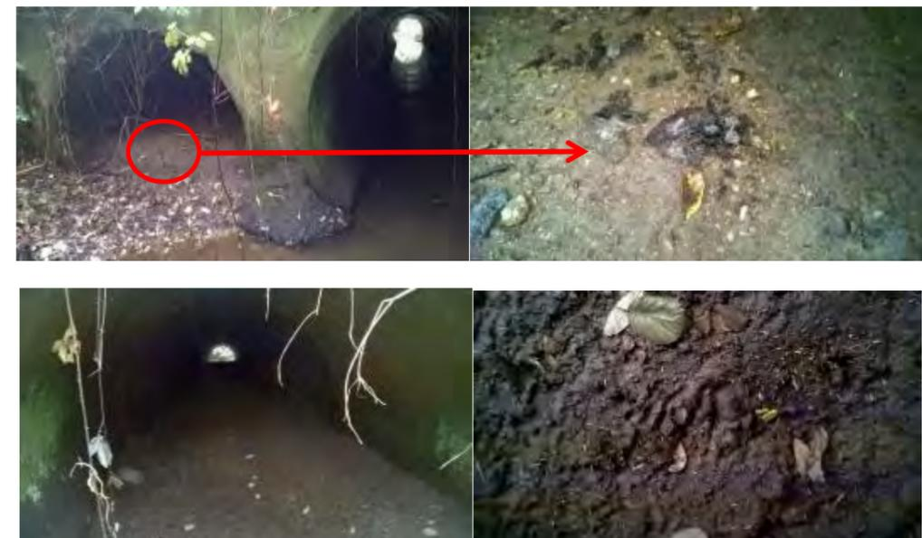
Figure 4 : Ligne 1 : Intérieur de la buse Ouest vue de l'aval. Ligne 2 : à gauche, tête de l'OH à l'aval ; à droite excréments. Ligne 3 : à gauche, tête de l'ouvrage à l'amont ; à droite, traces de passage de petite faune (© Egis / David FERREIRA)
