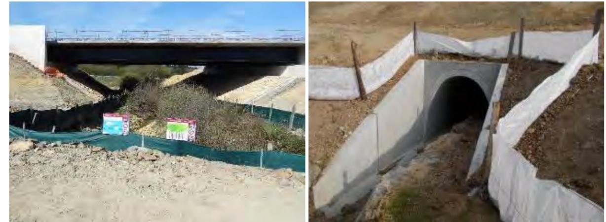
**Photographie 42 Exemple de protection de cours d'eau par clôtures géotextile sous un ouvrage de type cadre ouvert avec préservation de la végétation rivulaire et principe d'implantation de clôtures géotextile pour protéger les cours d'eau (© Egis / D. Ferreira)**
