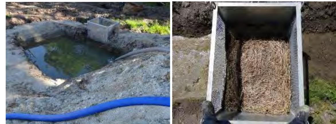
**Photographie 43 : Exemples de dispositifs d'assainissement provisoire mis en place en phase travaux (© Egis / D. Ferreira)**
