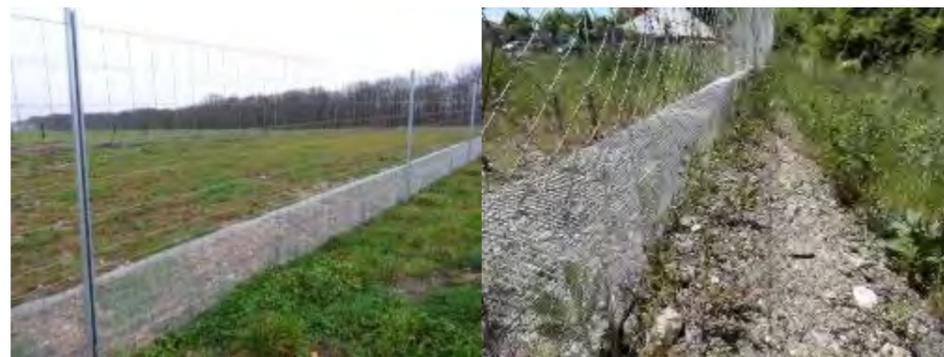
**Figure 25 : Exemple de clôtures à mailles fines 6 mm x 6 mm (© Egis)**
