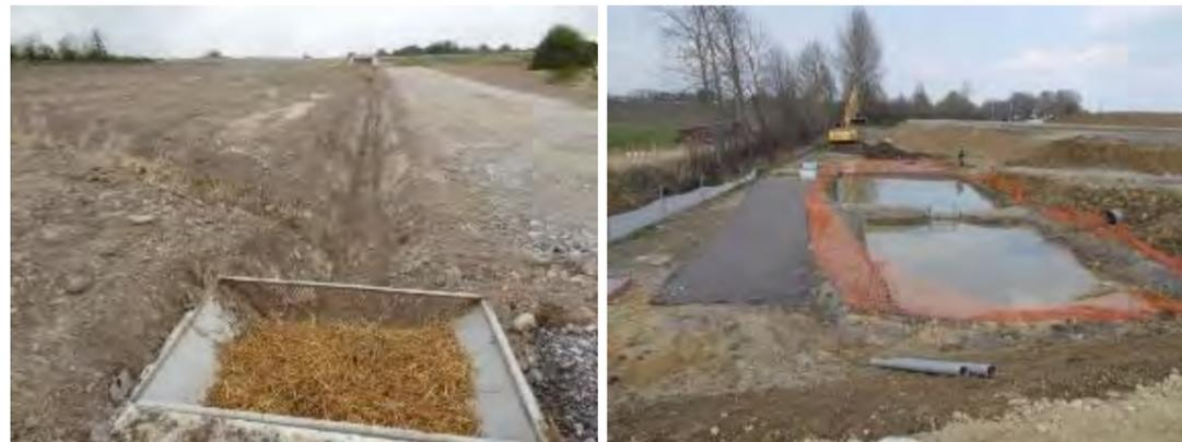
**Photographie 40 : Exemples de dispositifs d'assainissement provisoire mis en place en phase travaux (© Egis / D. Ferreira)**
