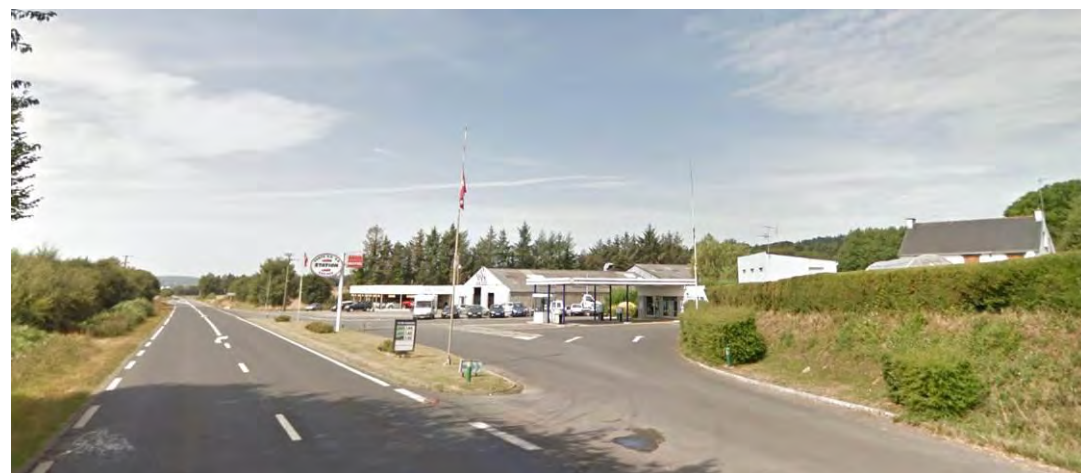
Vue n°16 : Perception sur un garage depuis la RN164 actuelle
