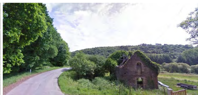
Vue n°12 : Perception actuelle vers le projet depuis la RD63 au Sud, le viaduc sera visible depuis ce secteur
