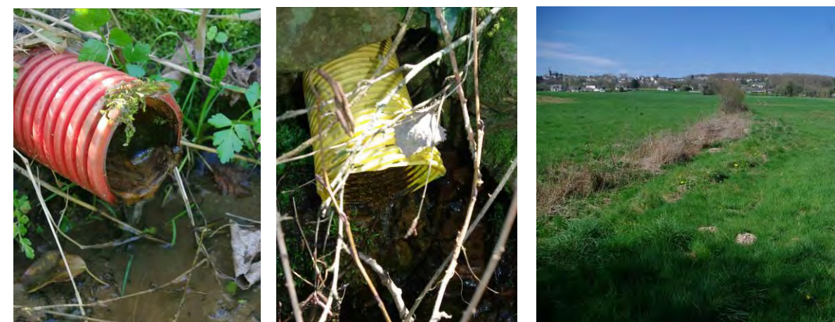
Vue des drainages (à gauche) et du fossé drainant (à droite) observés sur l'aire d'étude
