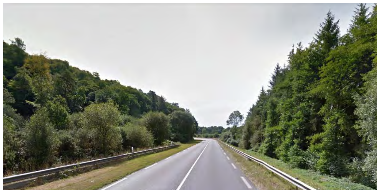
Vue n°10 : Traversée de la vallée par l'actuelle RN164
