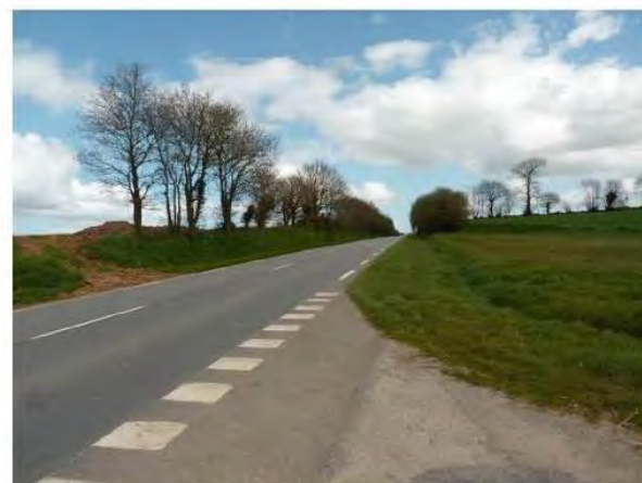
20. Vue depuis la RN164. Secteur en déblais, fermé par un talus bocager.
