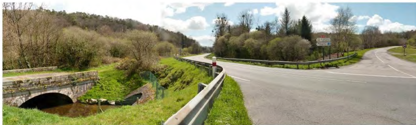
12. Vue sur le carrefour RN164/D63. Traversée du ruisseau du Poulancre.
