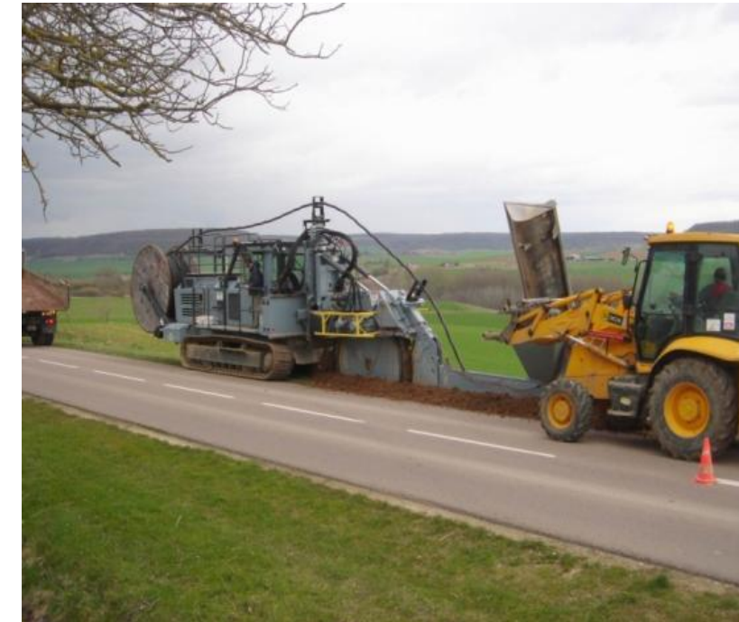
Exemple de travaux de raccordements au poste source
