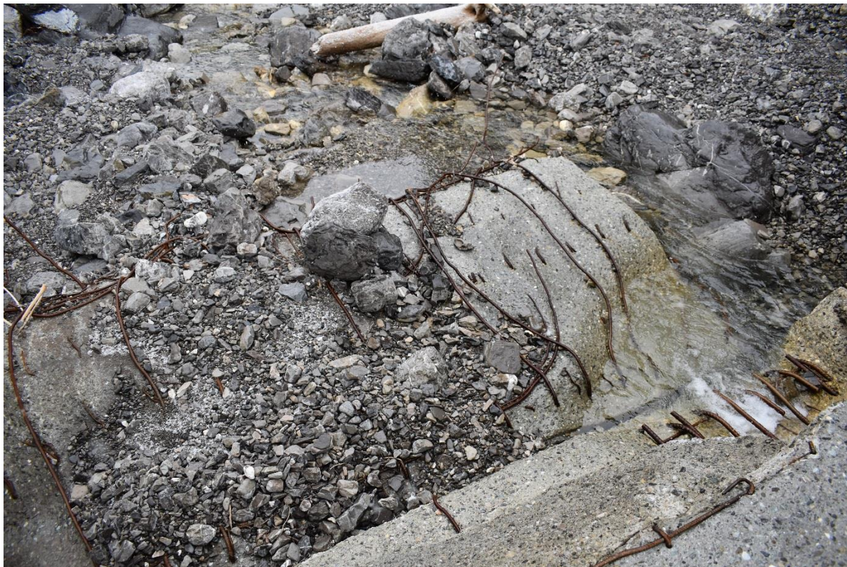
Figure 13 : Radier du pertuis de sortie de la plage de dépôt (Améten, fév. 2020)
