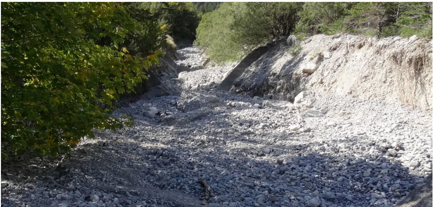
Photo 71 : Succession de barrages entre le passage à gué et la plage de dépôt.
