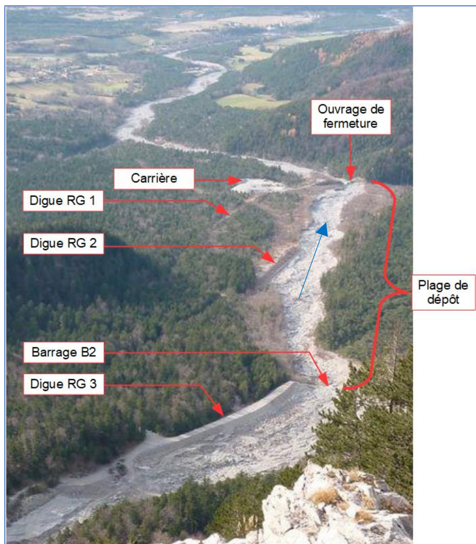
Figure 5 : Vue d'ensemble de la plage de dépôt
