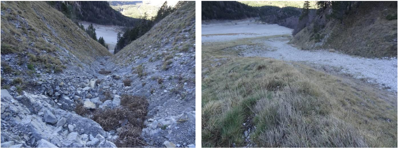
Photo 29 : Écoulement dans la branche Nord.
