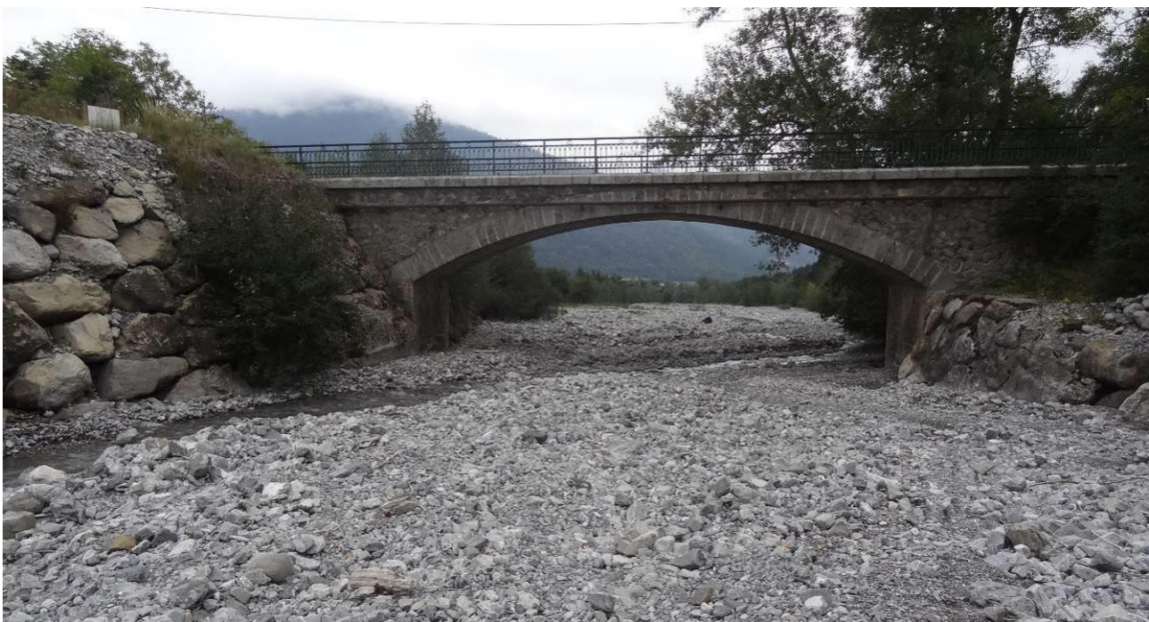
Photo 84 : Pont de la RD 216 à Château Méa.
