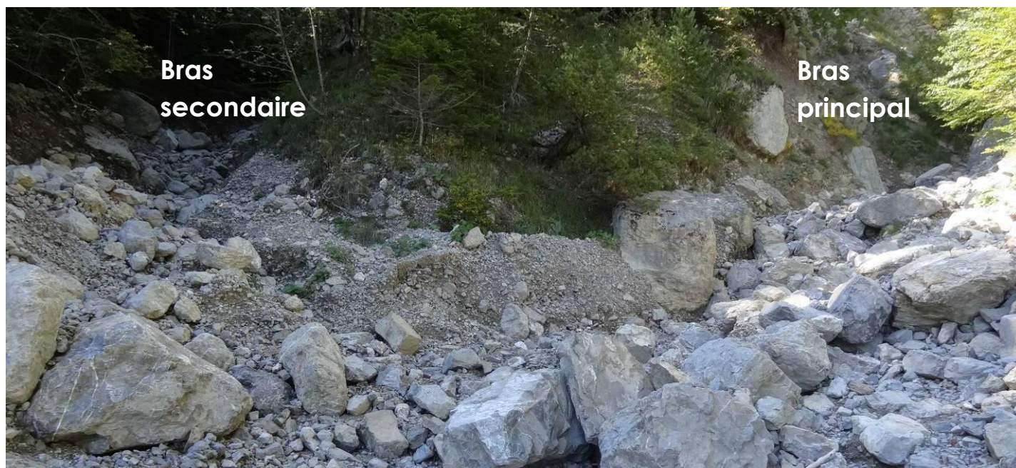
Photo 69 : Confluence du bras principal et du bras rive gauche.
