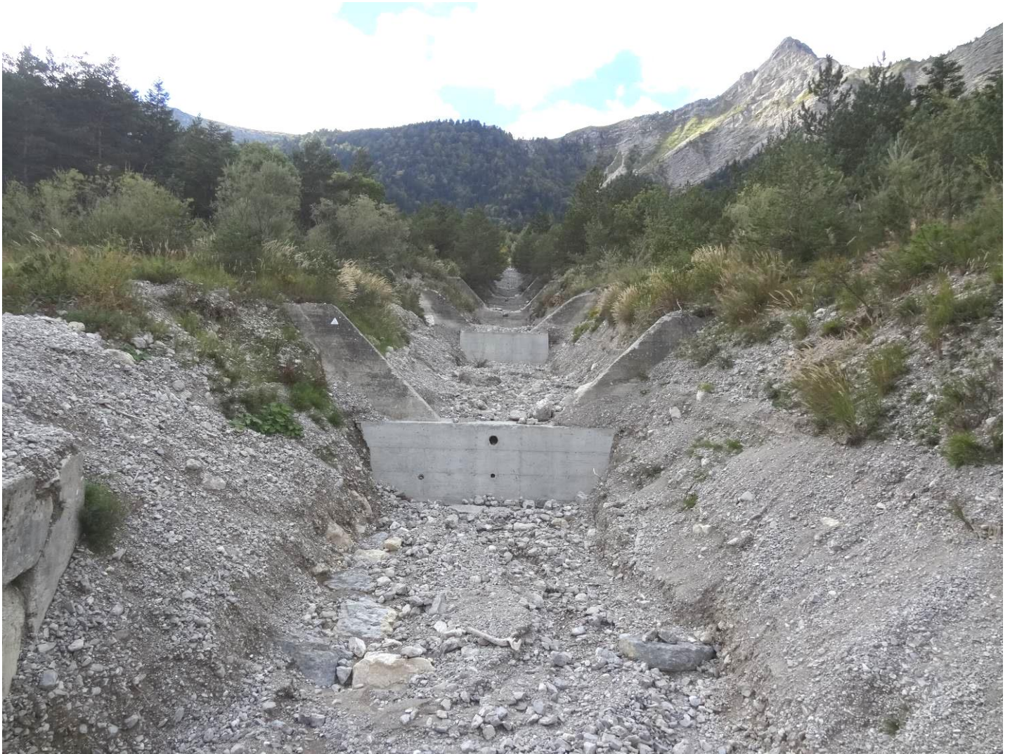
Photo 73 : Confortement des seuils en amont du pont.
