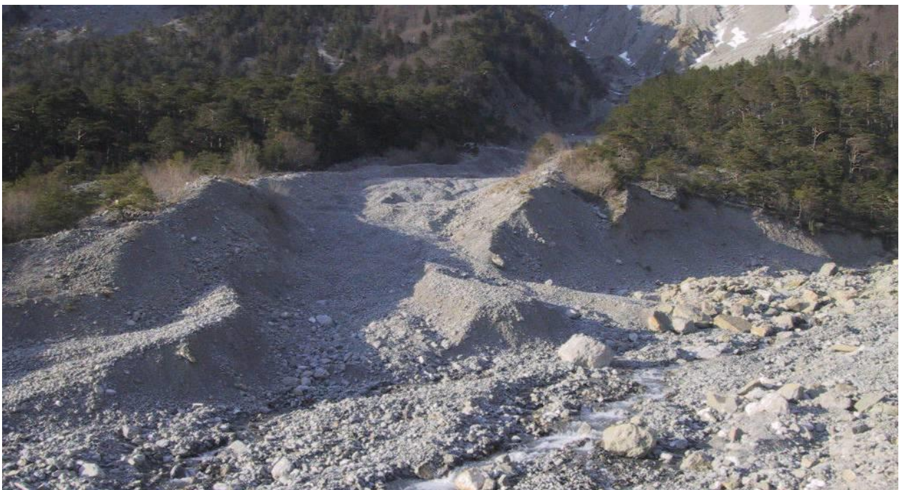
Photo 20 : Lit actuel nettement remonté à la confluence Pravert / Ebron
