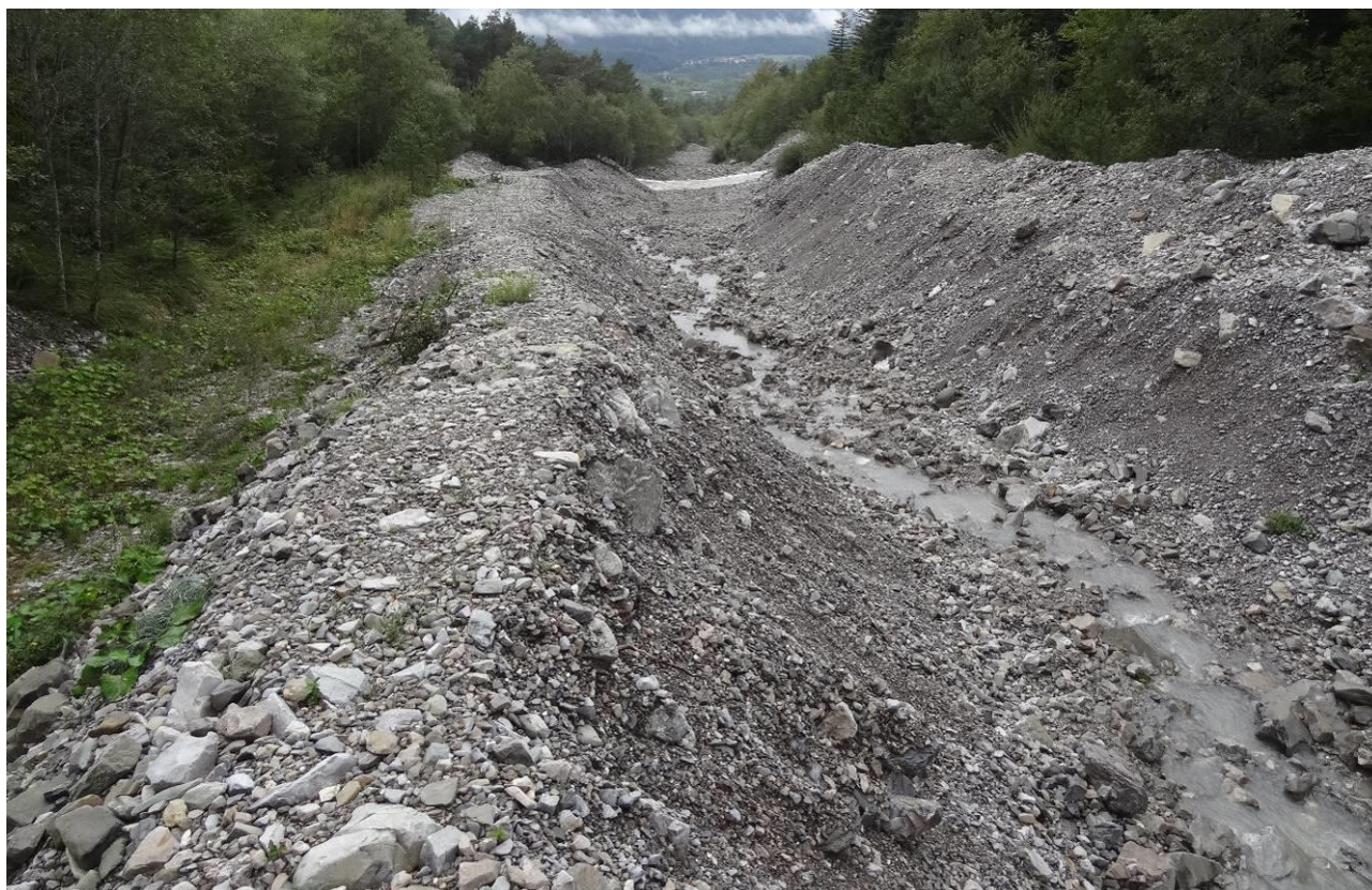
Photo 43 : Section limitée du chenal après dépôts des matériaux en berge.
