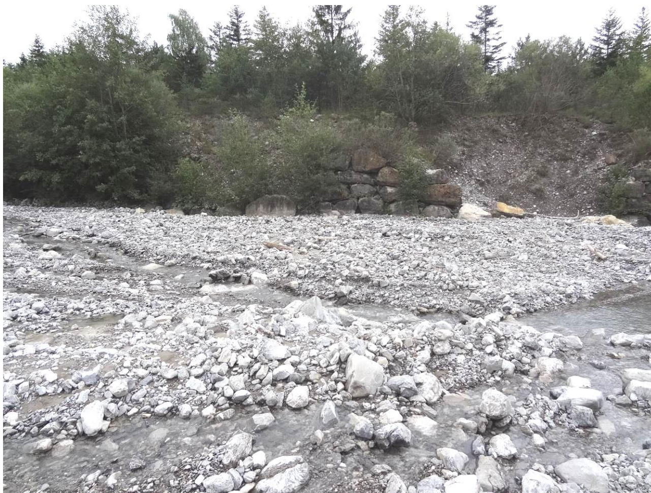
Photo 85 : Poursuite de la destruction de la digue rive gauche de Château Méa.
