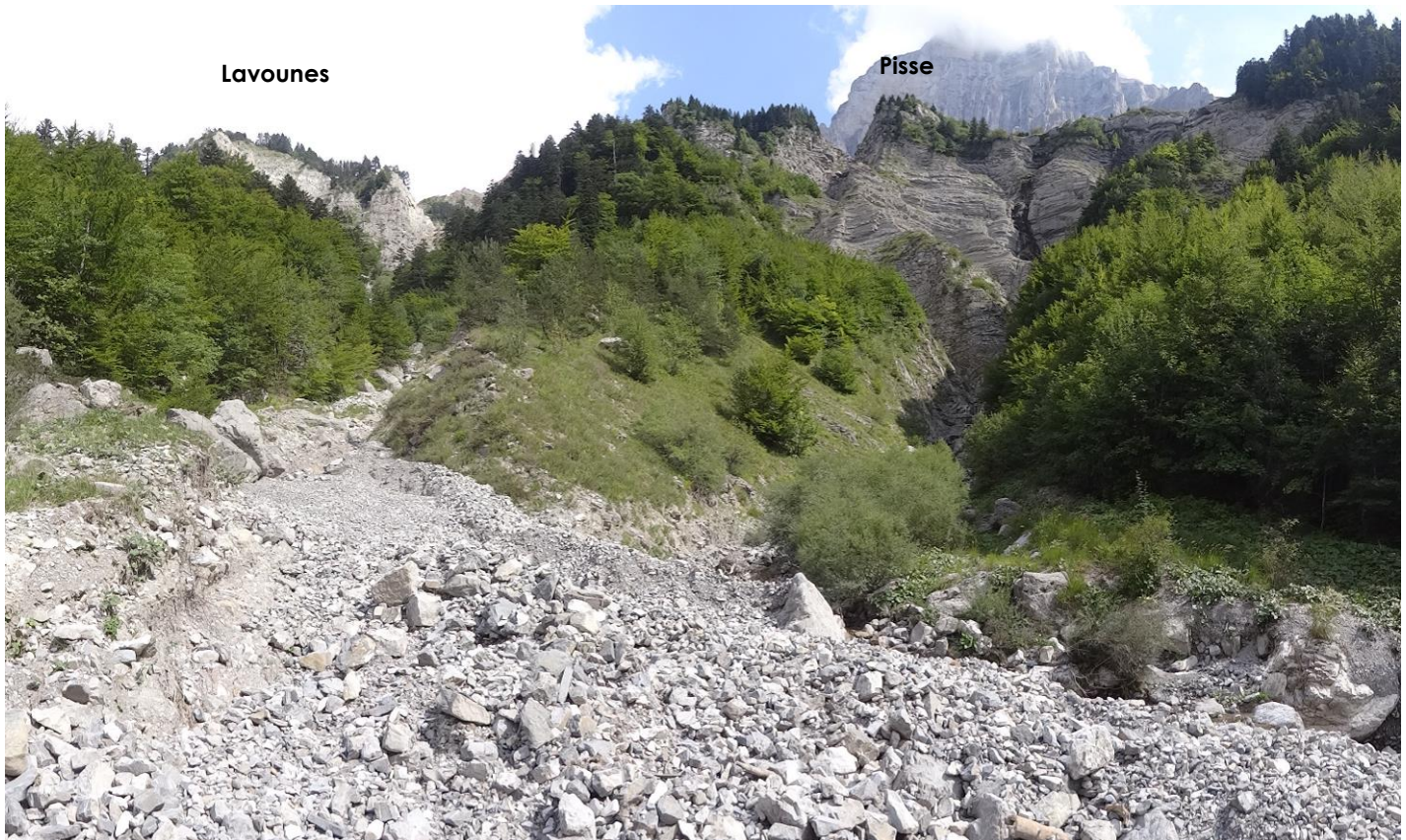
Photo 48 : Confluence aux sources du torrent du Rapidet.
