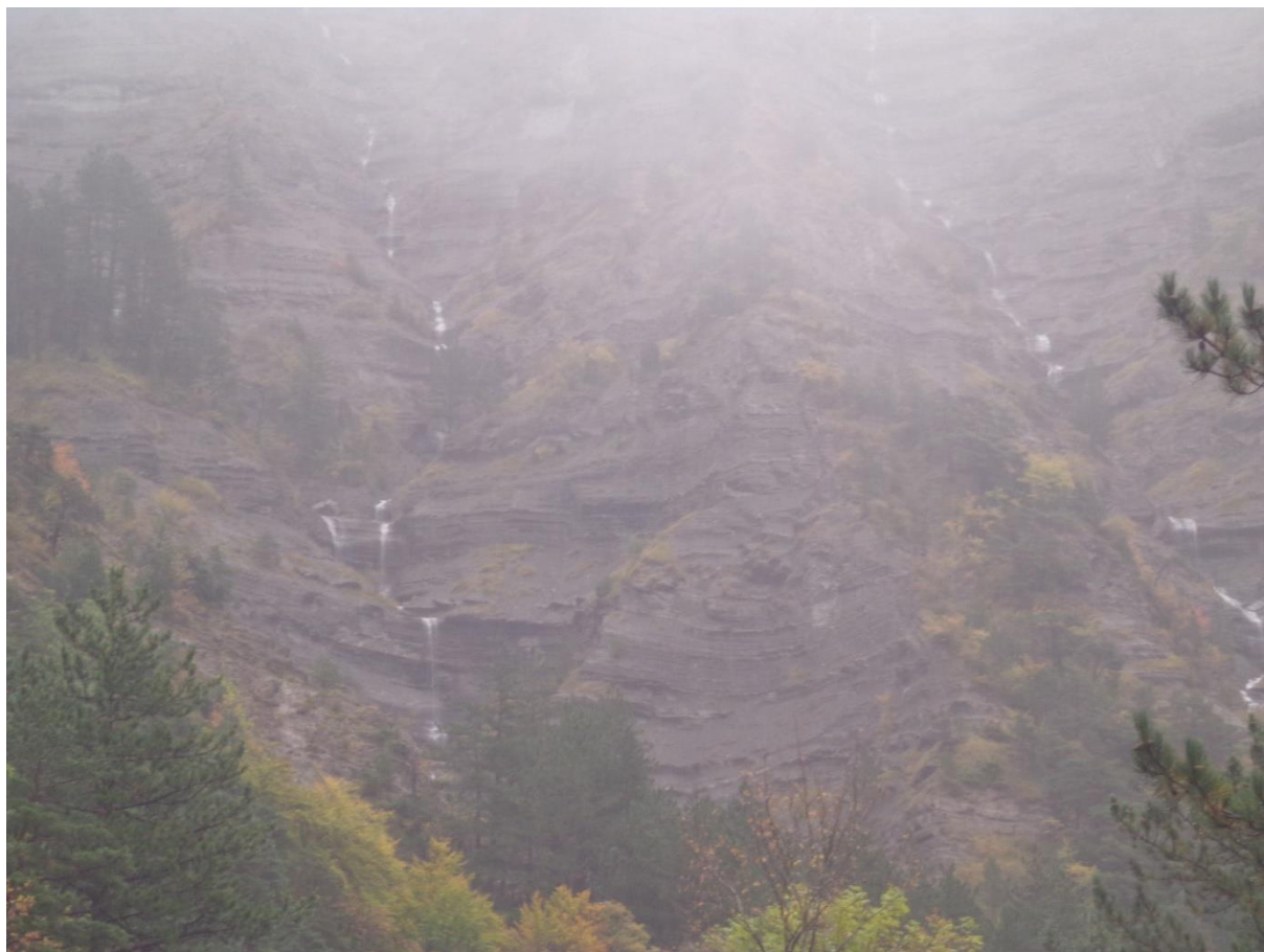
Figure 77 : Vue du versant des Echareennes depuis la RD 216 (écoulements dues à une forte pluie)
