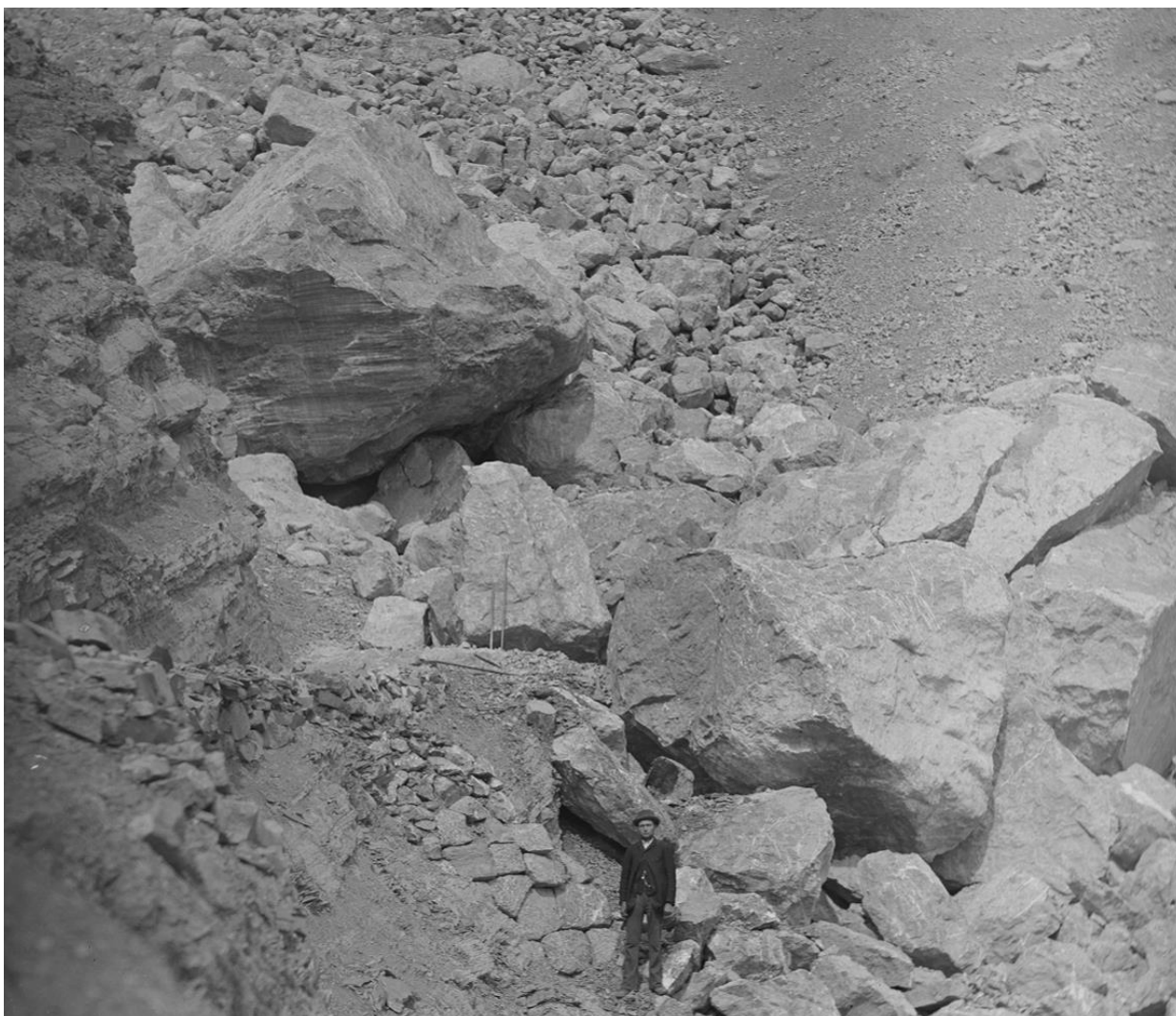
Figure 95 : Reste de barrage dans la branche C.
