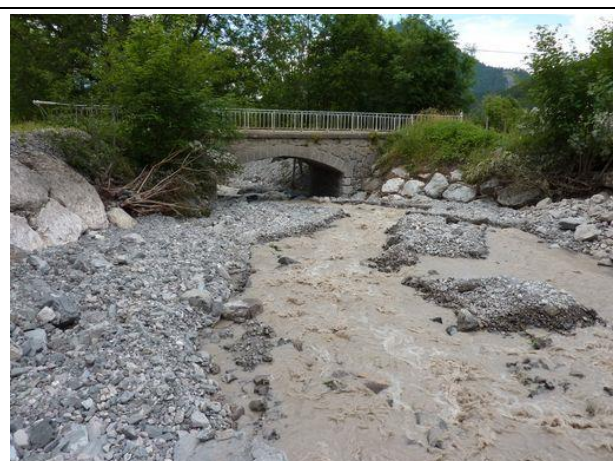
Figure 116 Pont du Serre (photo JB NICAISE 2013)
