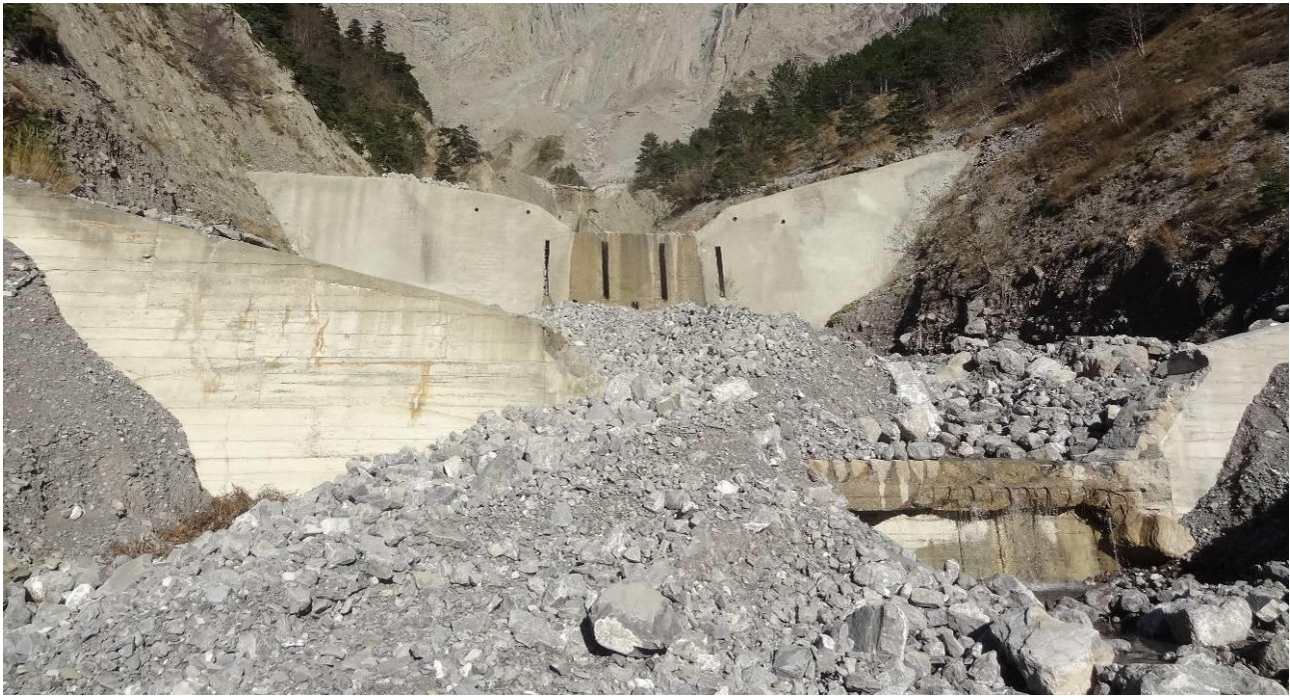
Photo 18 : Ensemble des deux barrages aval fondés sur le rocher.
