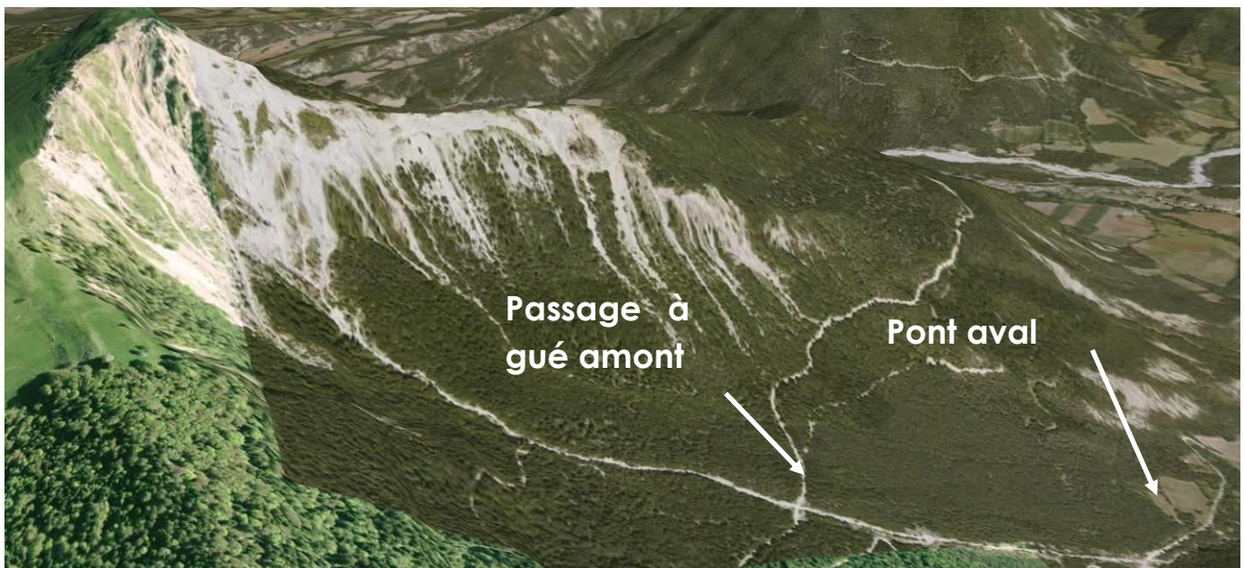
Figure 130 : Vue d'ensemble du torrent.
