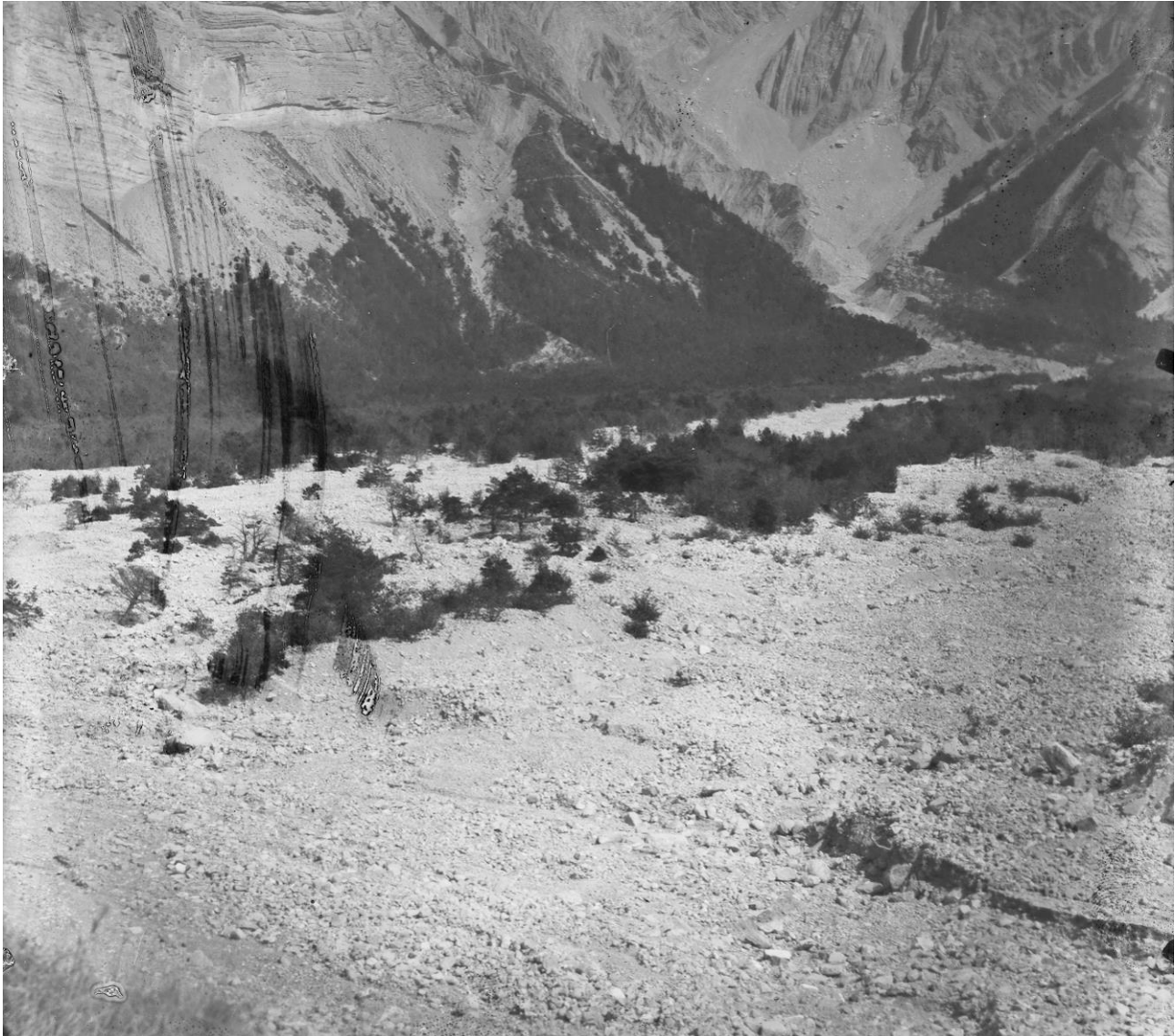
Figure 142 : Lit de l'Ebron au XIX ème siècle au droit de l'actuelle plage de dépôt.
