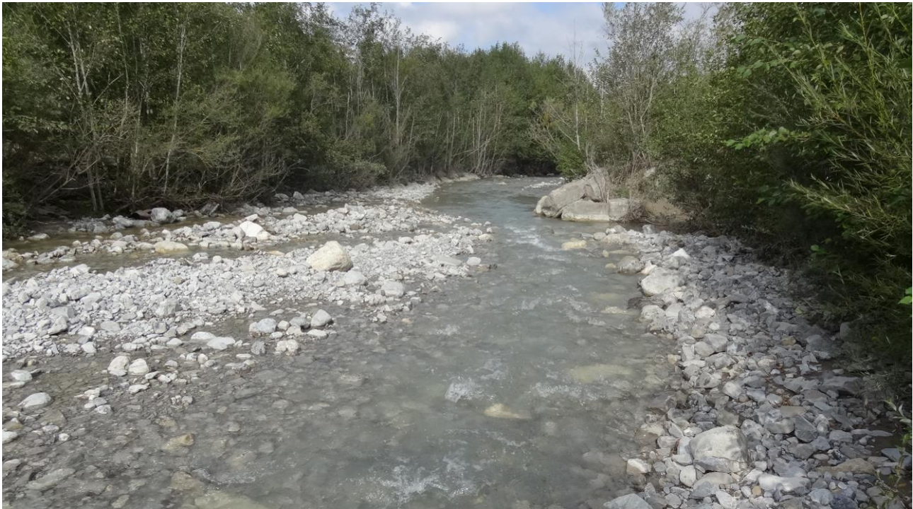
Photo 91 : Vestige de l'un des seuils.
