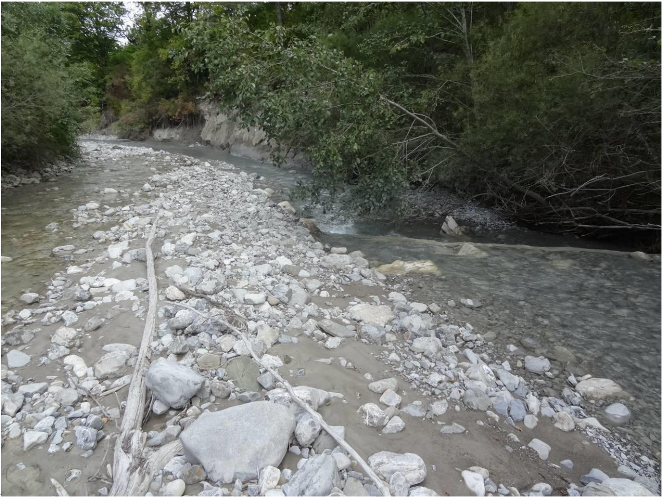
Photo 92 : Lit étroit et forte érosion de berge entre Combe Noire et les Petits Moulins.
