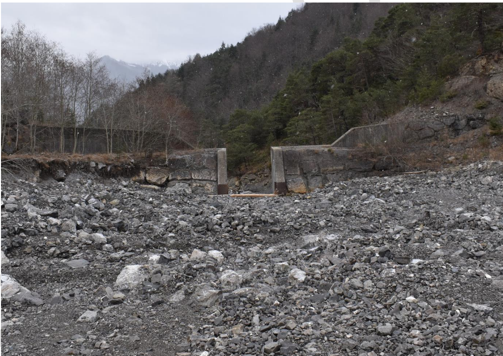
Figure 7 : Ouvrage de fermeture actuel de la plage de dépôt (Améten, fév. 2020)
