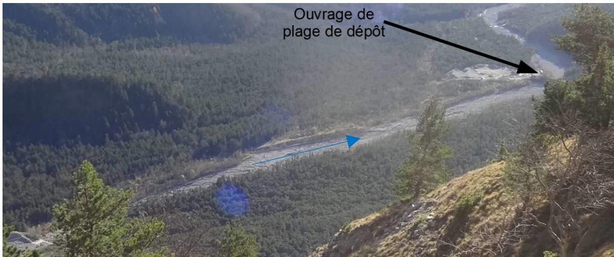
Figure 4 : Vue d'ensemble de la plage de dépôt (source : ONF - RTM)
