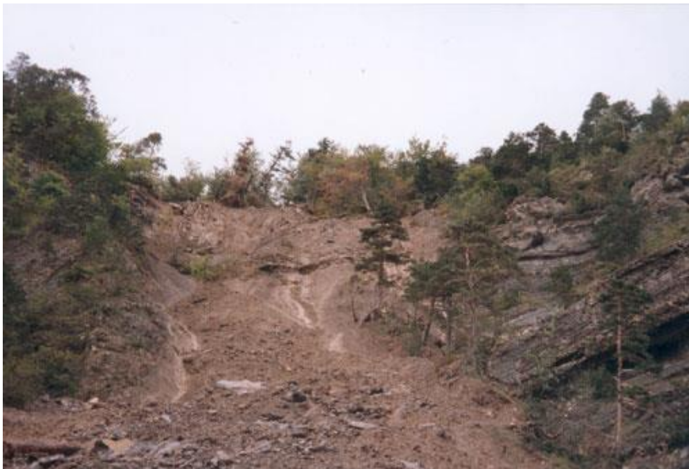
Figure 82 : Vue du glissement en 1994, prise depuis le bas de la zone glissée (photo RTM)
