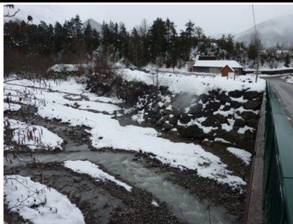
Photo JBN 2014 – amont du pont
