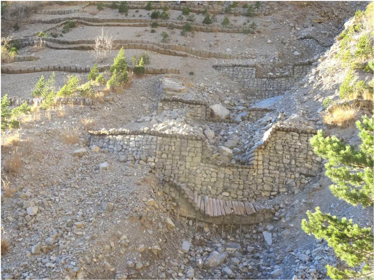
Photo 9 : Correction de la partie aval de la ravine amont (Branche A).
