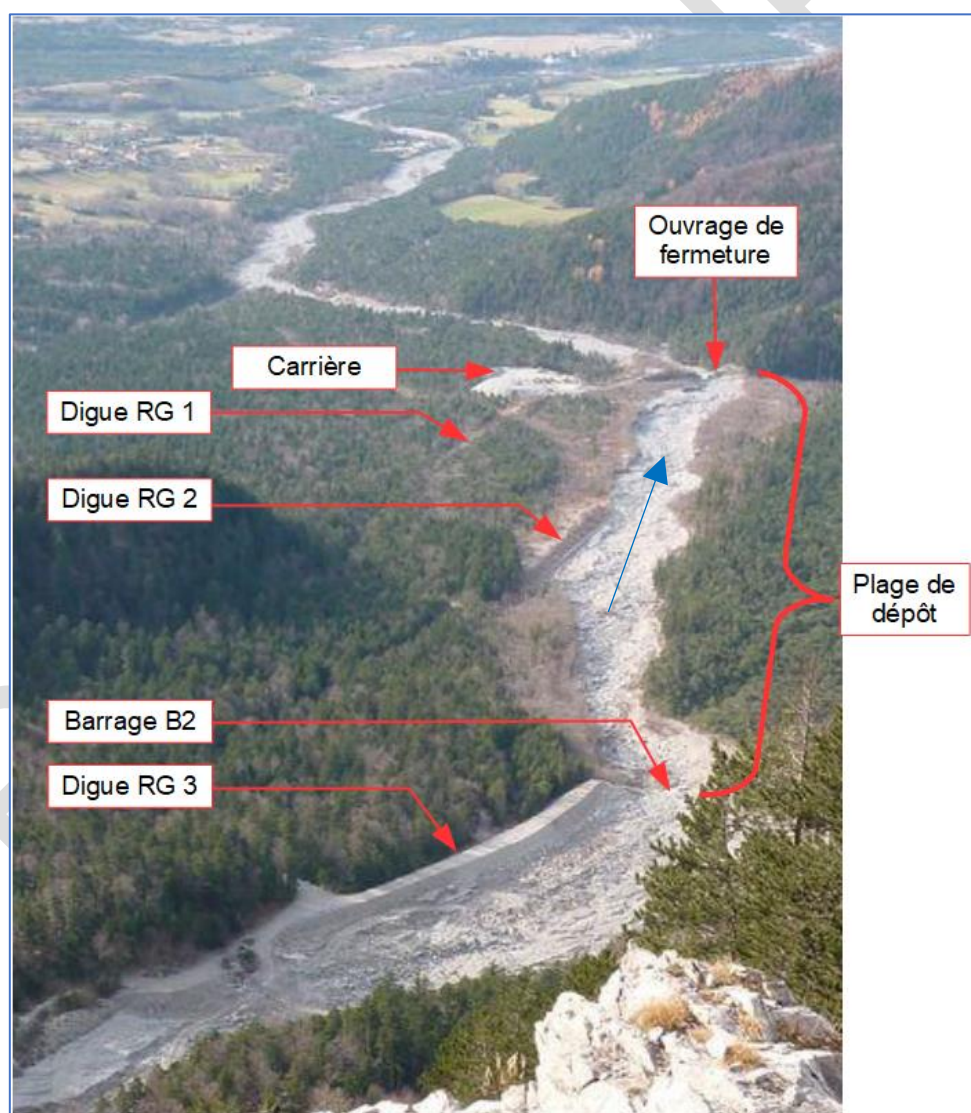
Figure 55 : Vue d'ensemble de la plage de dépôt
