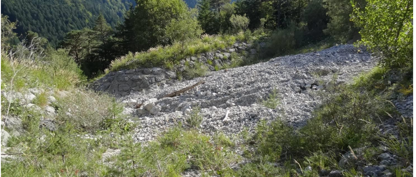
Photo 72 : Plage de dépôt dans la partie centrale de la correction.
