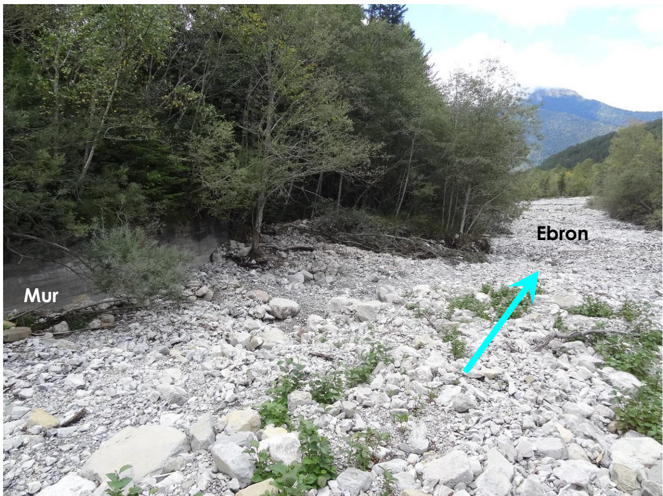
Photo 27 : Mur de protection aval.
