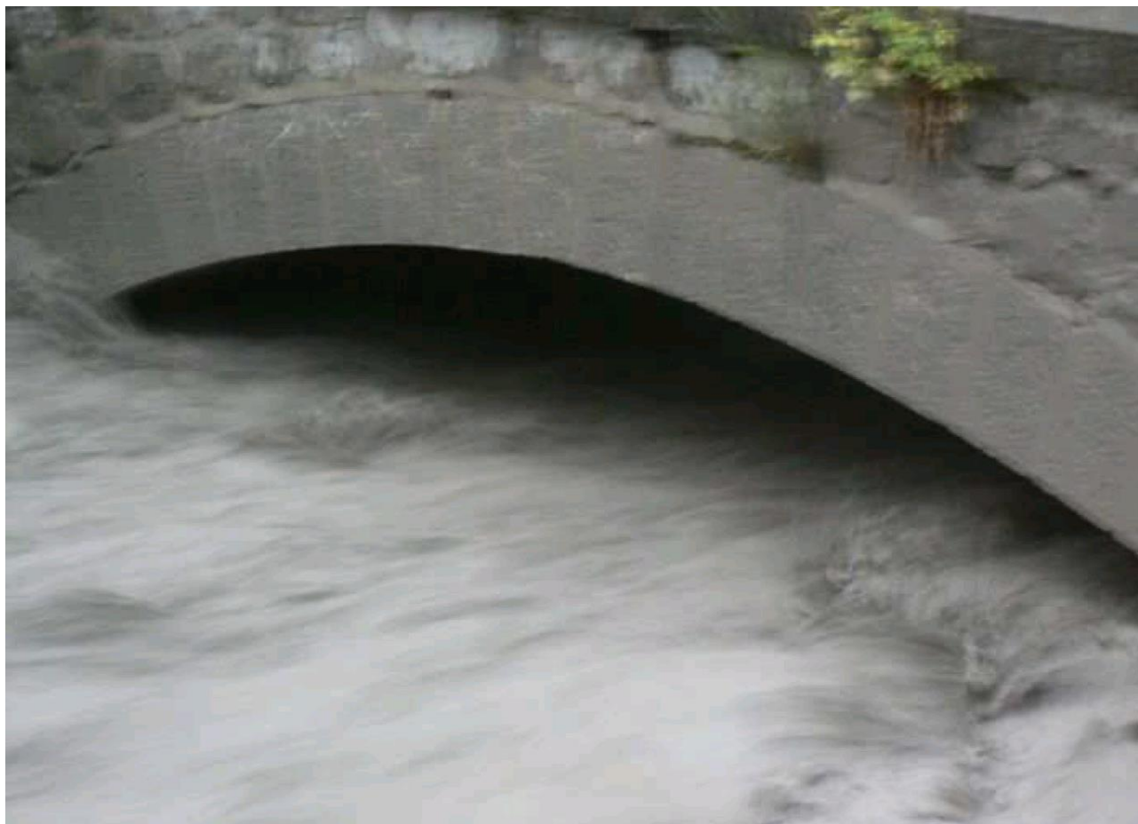
Photo 54 : Pont du Serre en limite de passage en charge (photo mairie de Tréminis).
