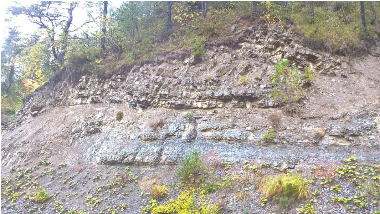
Figure 67 : Affleurement marno-calcaire de l'Oxfordien au droit de la piste forestière du versant sud du Ménil
