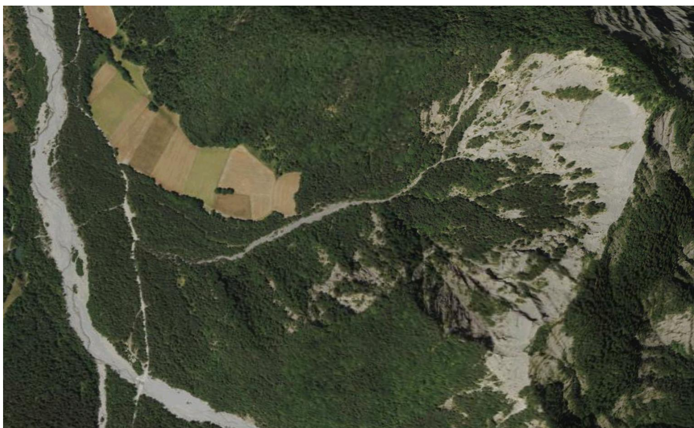
Figure 85 : Lit du torrent du Rattier actuel.
