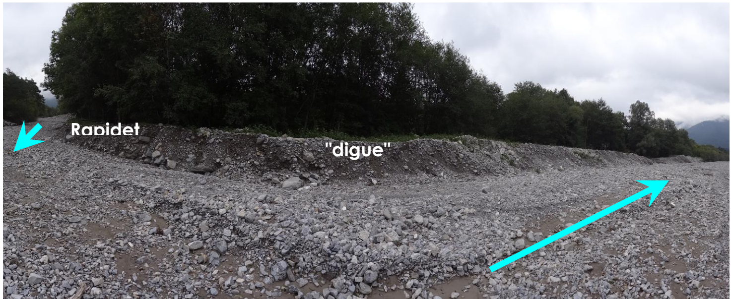
Photo 83 : Merlon en rive gauche à la confluence avec le Rapidet.
