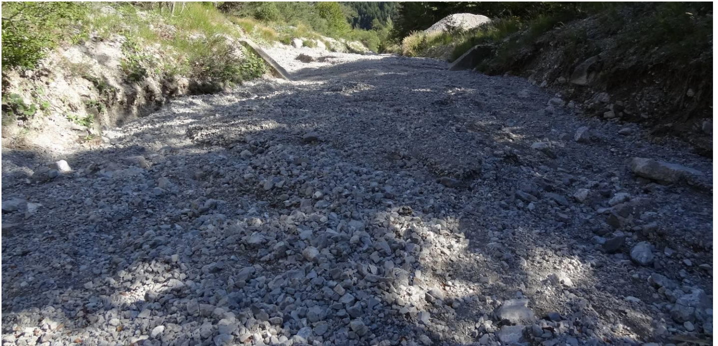
Photo 70 : Bouchon en amont du passage à gué.
