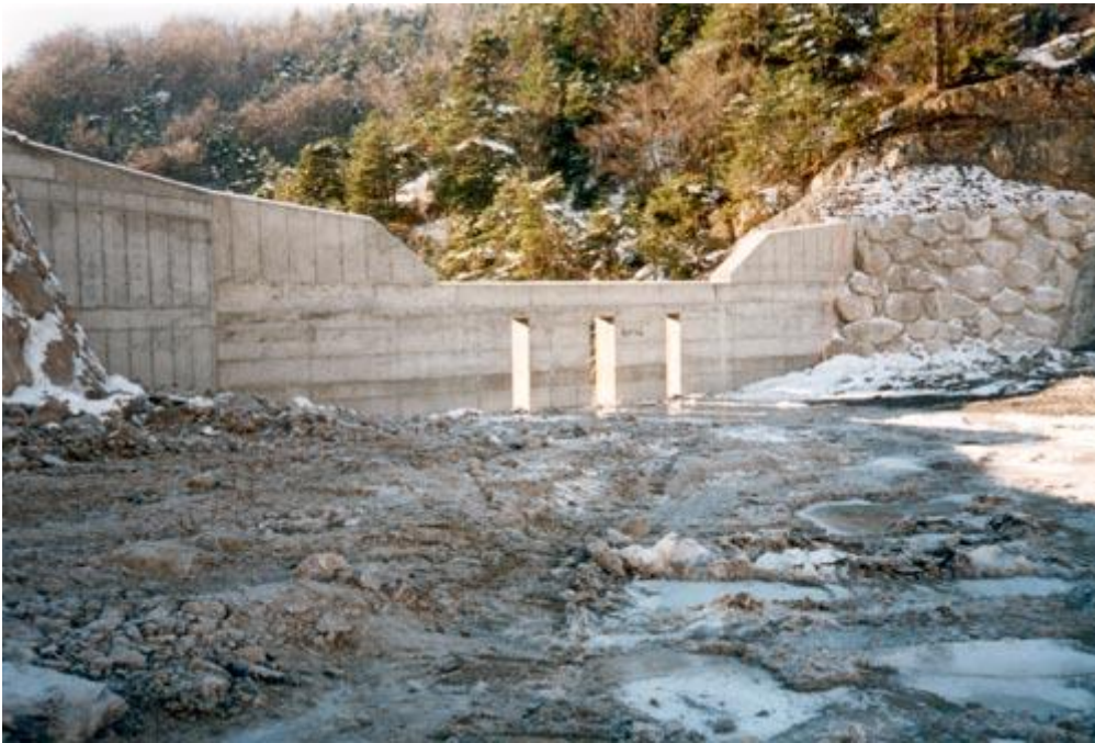
Figure 6 : Barrage de sédimentation de la plage de dépôt avant ouverture (service RTM, oct.1990)
