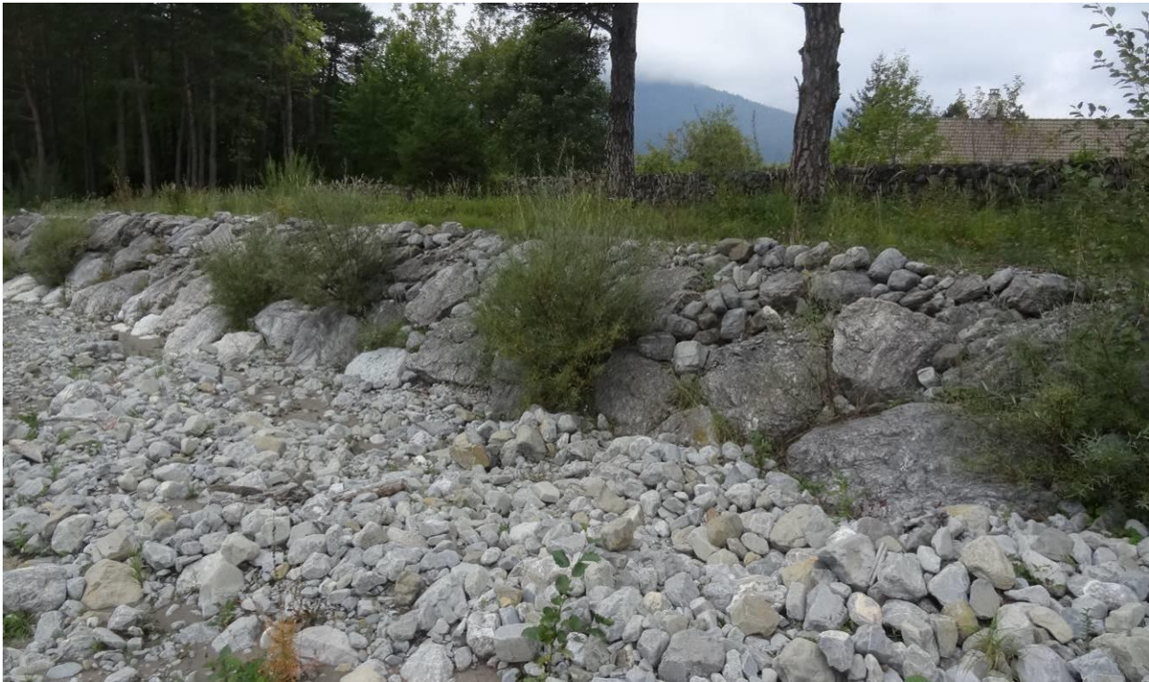
Photo 82 : Double protection en rive droite en aval du pont.
