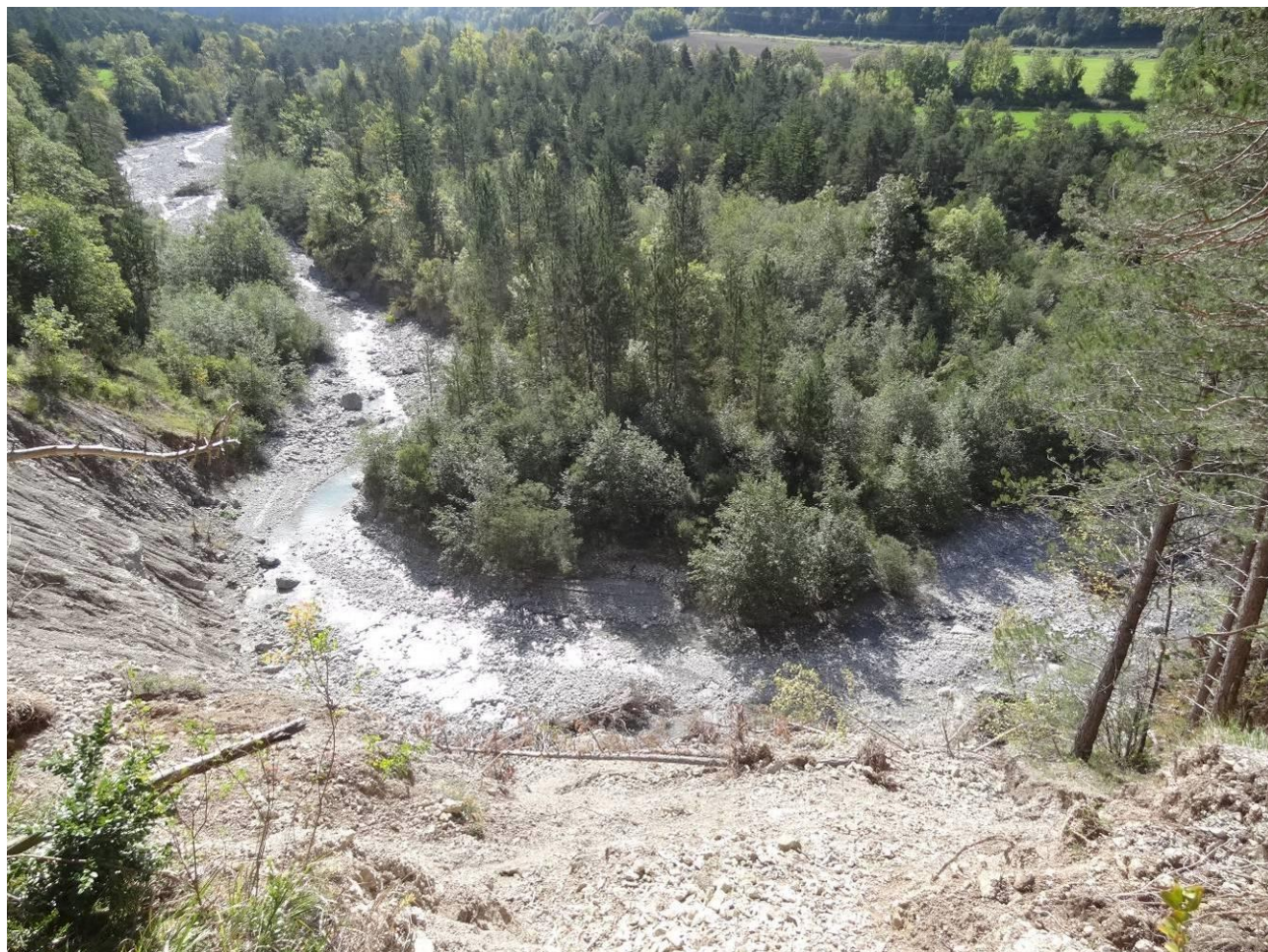
Photo 90 : Seuil de Combe Noire vu de la rive droite.
