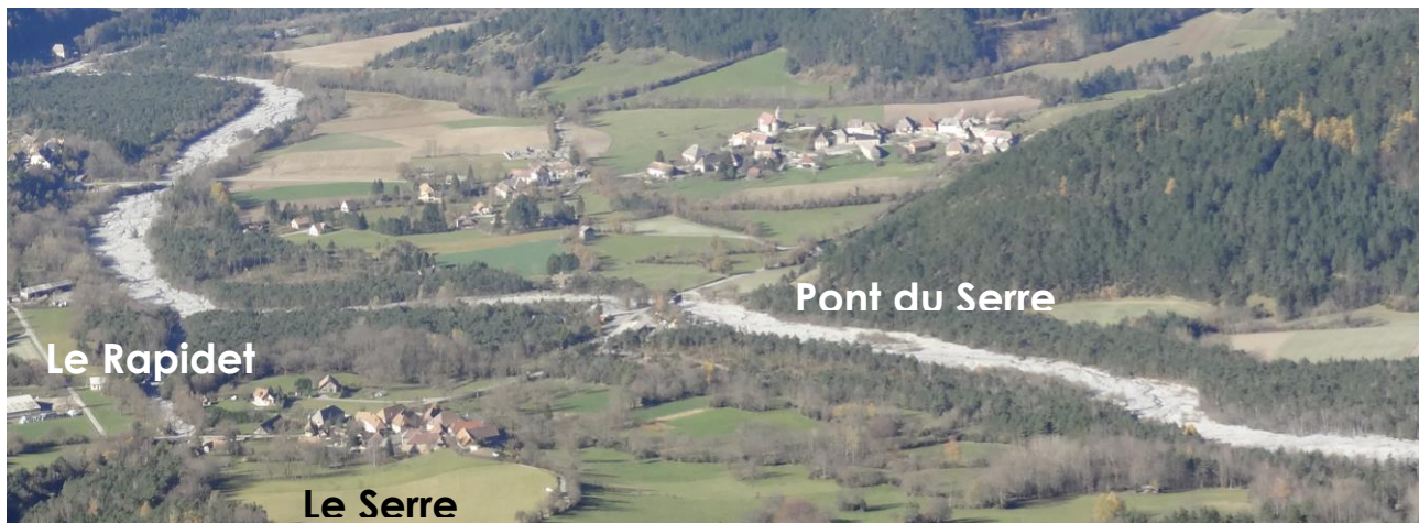
Photo 80 : Vue d'ensemble de l'Ebron en amont du Bourgeneuf.
