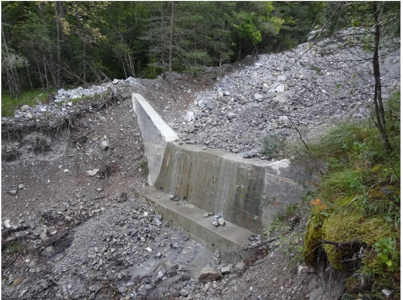
Photo 40 : Barrage dans le torrent de la Ruine.
