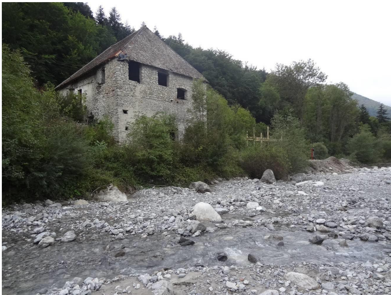
Photo 86 : Pavage localisé au confluent avec le Bourgeneuf.
