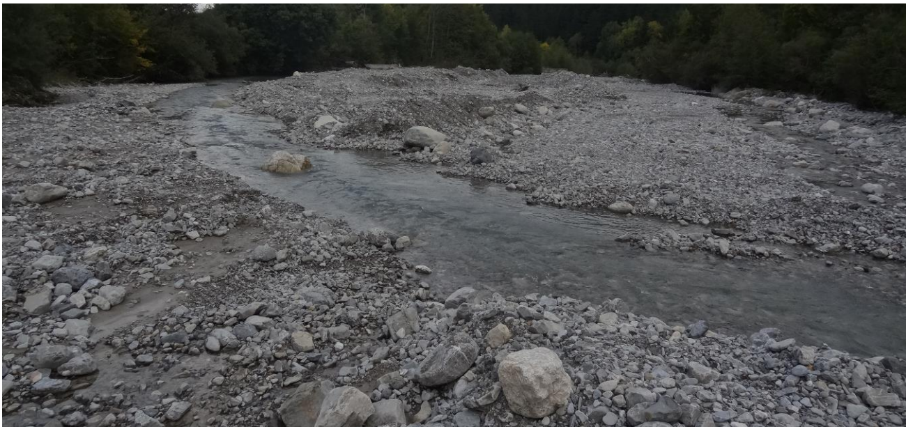
Photo 89 : Barrage temporaire pour l'alimentation en eau de la microcentrale.
