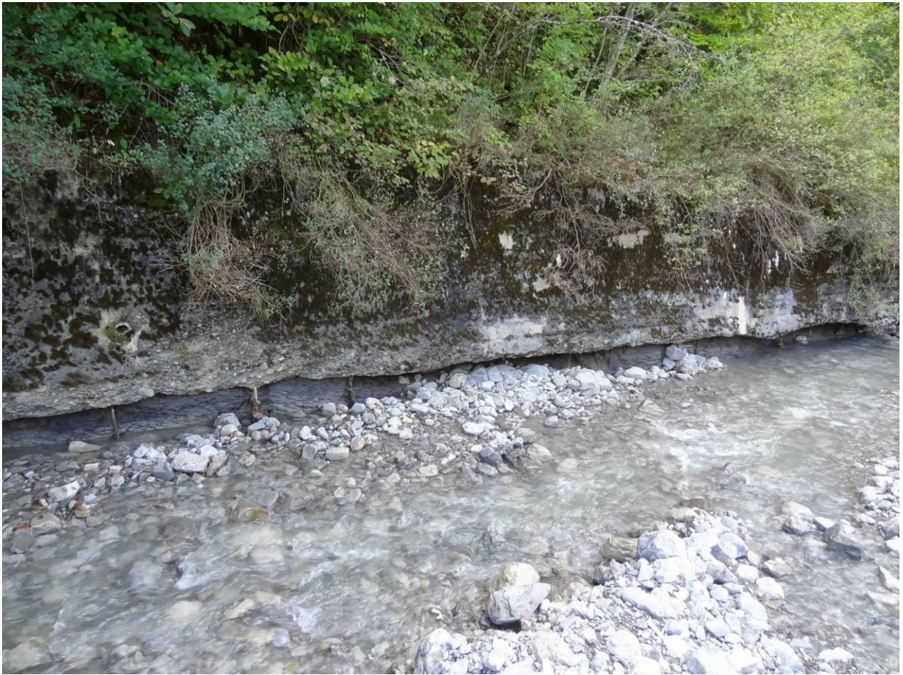
Photo 67 : Mur de soutènement en rive gauche.
