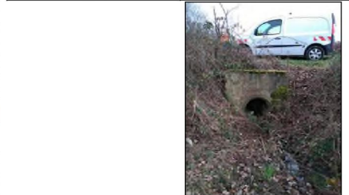
Photos du thalweg
