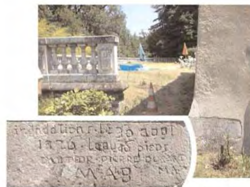
repère de la crue du 30 août 1826 sur une demeure du 19ème siècle longeant le ruisseau de Cruzol sur la commune de Mozac
