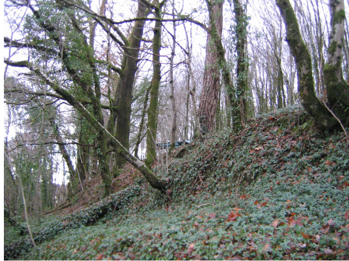
Figure n°16 : Talus de rupture du glissement du chemin de la Brousse
