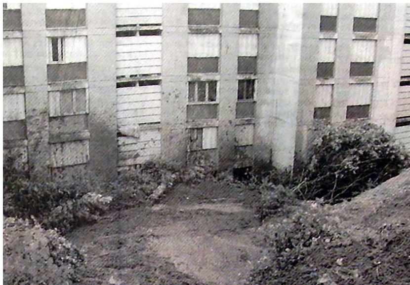
Figure n°28 : la coulée du 5 juillet 2001 sur la face amont de l'HLM des Fages (photo La Montagne, Archives Départementales de la Corrèze)
