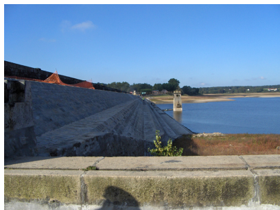
Barrage de Torcy-Neuf
