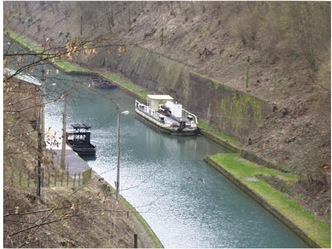
Le Centre mène des études d'ingénierie radio pour certains tunnels fluviaux (entrée du tunnel de Riqueval)
