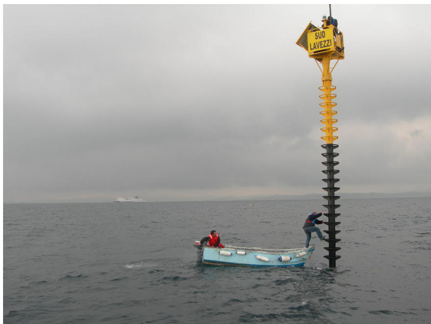
la balise à flotteur immergé «Sud Lavezzi» pèse 10 tonnes
