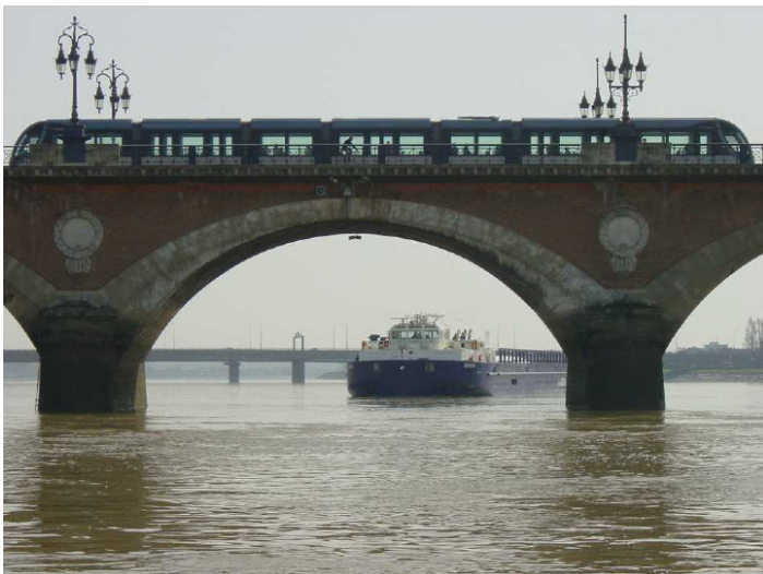
Franchissement du Pont de Pierre de Bordeaux par une barge fluviale
