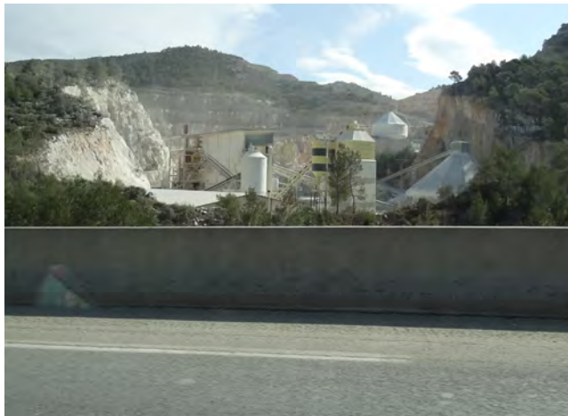
Une installation nichée dans le fond de la carrière, mais trop visible depuis la route.
