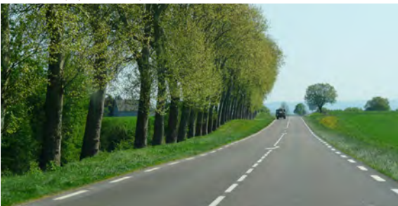
Les axes routiers rectilignes créent des perspectives et offrent des vues sur d'éventuelles carrières. RD978, Chatillon-en-Bazois
