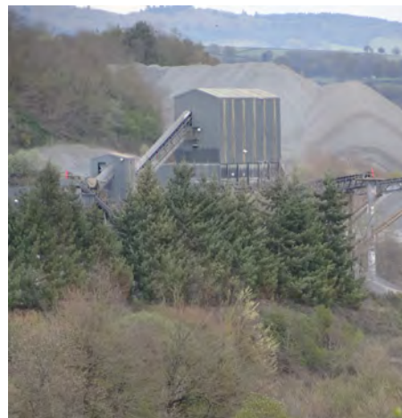
Les couleurs neutres à sombres, ne focalisent pas les regards et participent à la discrétion de l'installation.
