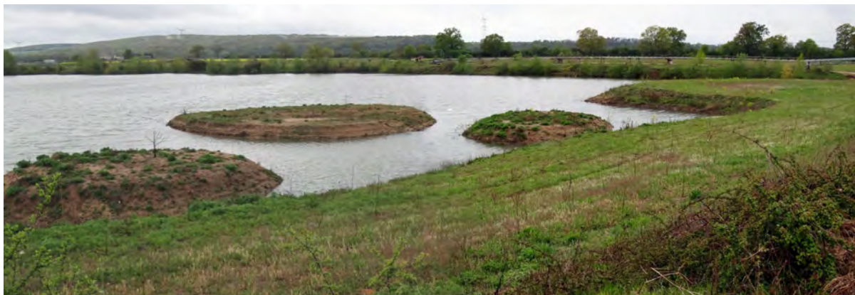
Un réaménagement aux formes inutilement complexes. Modeler les bassins pour aboutir à une forme simple, allongée, qui puisse évoquer un étang «naturel», supprimer les îles, presqu'îles, les digues entre les deux bassins, proscrire les formes trop complexes avec de nombreux redans qui paraissent artificielles.
