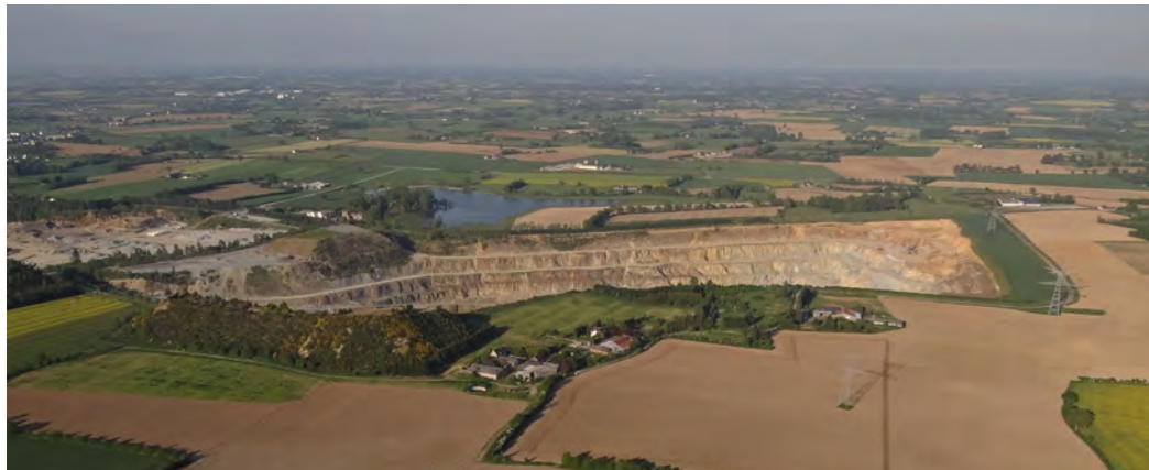
Un gisement de plateau ou de plaine est exploité par surcreusement ce qui limite les vues directes sur l'excavation. Les enjeux résident alors dans le traitement des franges de la carrière et l'implantation des installations et des stockages car la sensibilité visuelle en vue rasante est importante sur un site plan.
