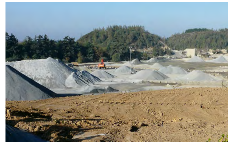
Installation et aire de stockage sont encaissés dans le relief de la carrière et n'émergent pas depuis l'extérieur du site.
