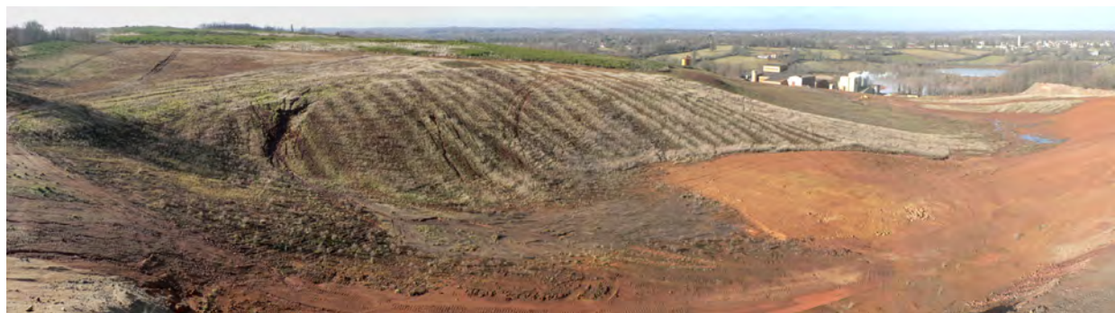
Un exemple de remodelage d'une carrière avec des profils adoucis permettant une future rétrocession agricole
