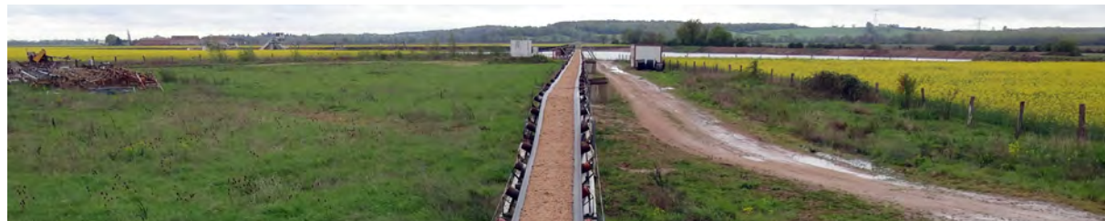
L'utilisation de bandes convoyeuse permet de limiter les nuisances sonores liées au trafic poids lourd mais également d'éloigner les installations de traitement des sites visuellement exposés dans la vallée
