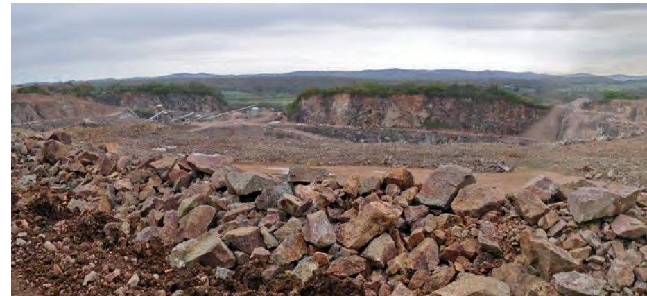
Sur un coteau, l'excavation creusée en fosse ou en entonnoir permet de maintenir une couronne non exploitée qui limite les vues extérieures.
