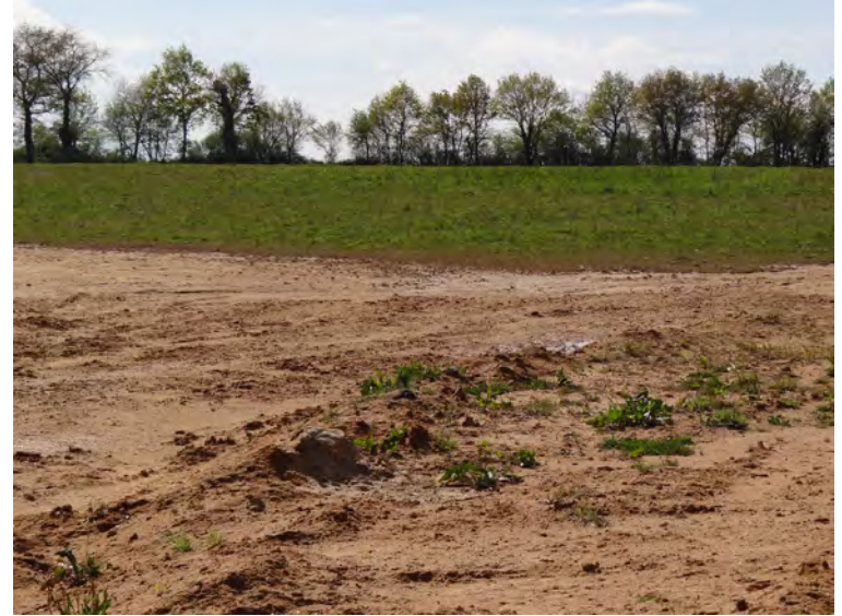
Carrière d'argile en cours d'exploitation : utilisation des stériles et des terres de découverte pour une remise en état agricole de la précédente tranche d'exploitation
