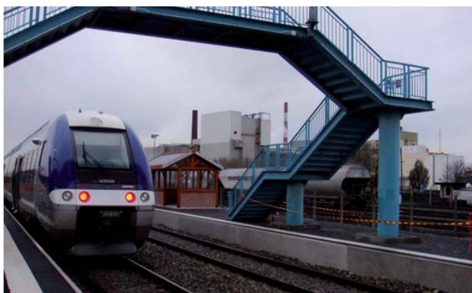
Gare SNCF de Nesle à proximité des usines Ajinomoto et Syral
