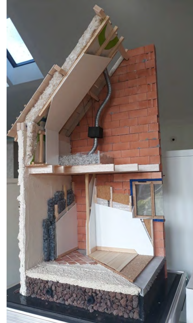
Maquette de démonstration de mise en œuvre des biosourçés
