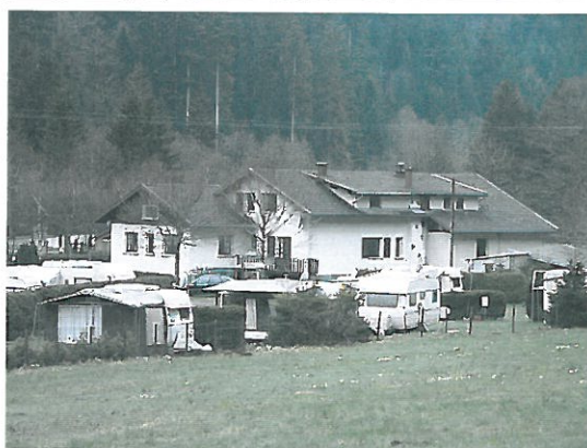
Le bâtiment d'accueil, vue arrière, depuis la route
