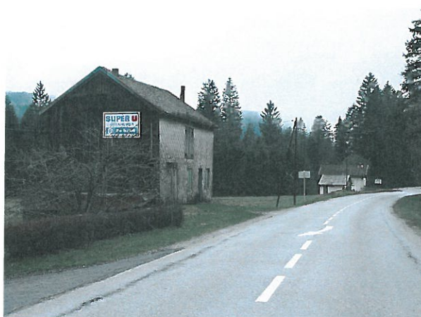
Des bâtiments abîmés sont très visibles depuis la route
