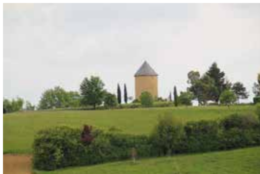
Moulin à vent à Estipouy
