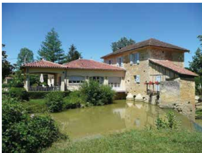
Moulin de Riguepeu sur l'Osse (moulin rénové en activité : fabrique de farine – photographie du site Internet correspondant)
