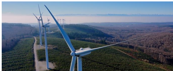
Parc éolien d'Arfons-Sor, Tarn (22 MWc, 11 éoliennes)
