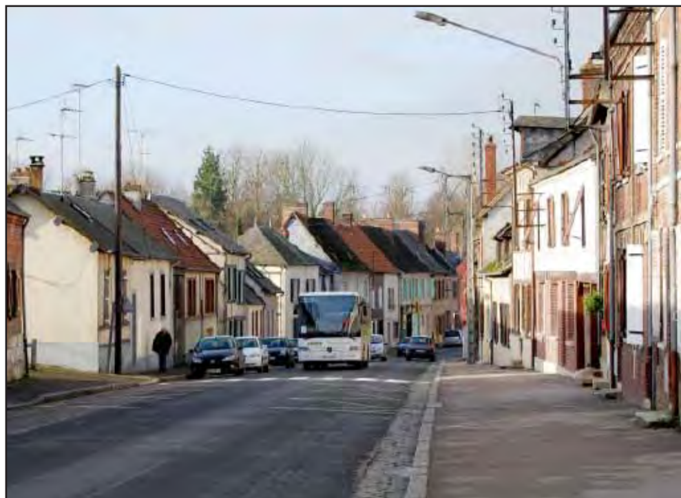
L'entrée d'Etrepagny par la RD 14 bis. (2009 - commune d'Etrepagny)
