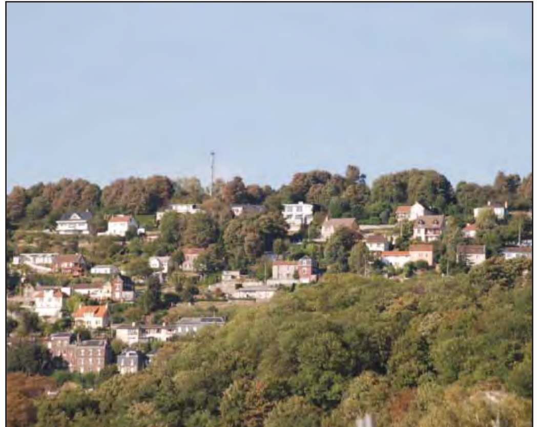
Les coteaux habités en amont du centre de Rouen : la ligne de crête conserve une silhouette arborée et la présence végétale sur les pentes diminue l'impact de l'urbanisation. (2009 - commune d'Amfreville-le-Mi-Voie)
