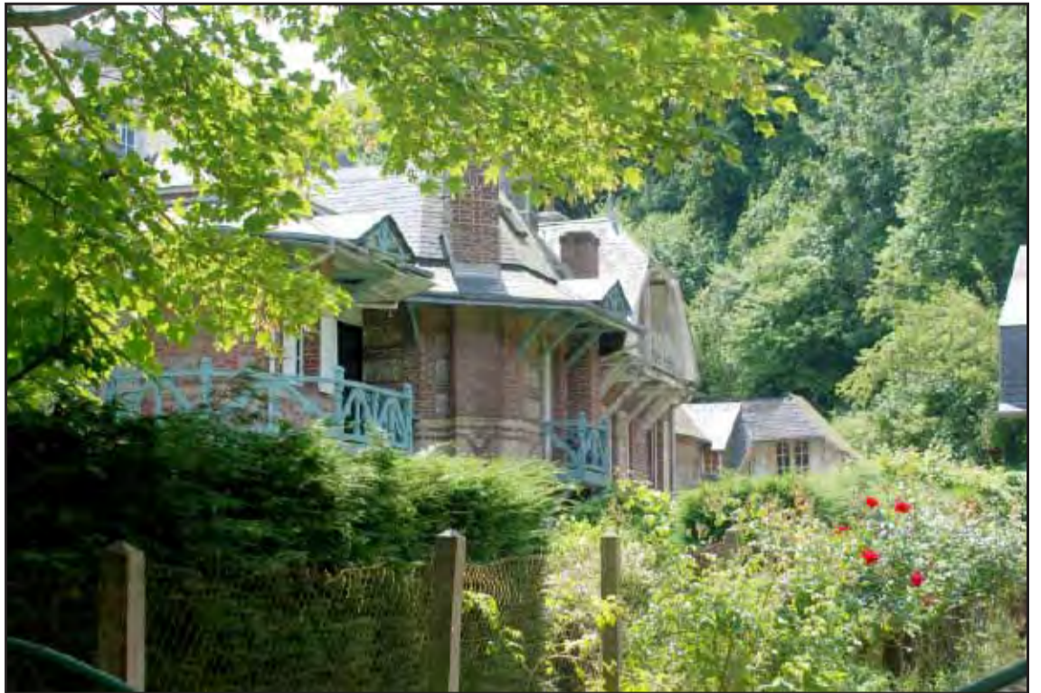
Les maisons à l'architecture typique des cités balnéaires dans la valleuse de Vaucottes.
