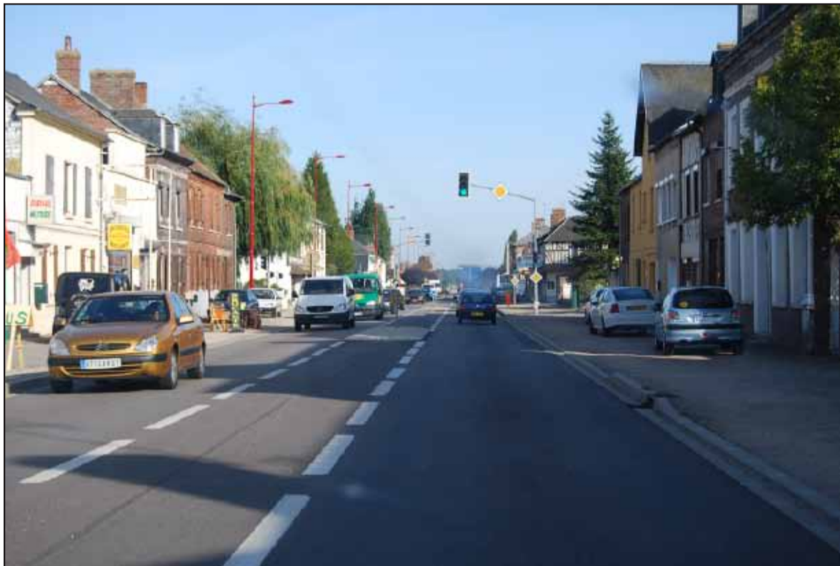
Un aménagement récent d'une traversée de village, qui laisse encore une part trop importante à la chaussée et aux stationnements.
