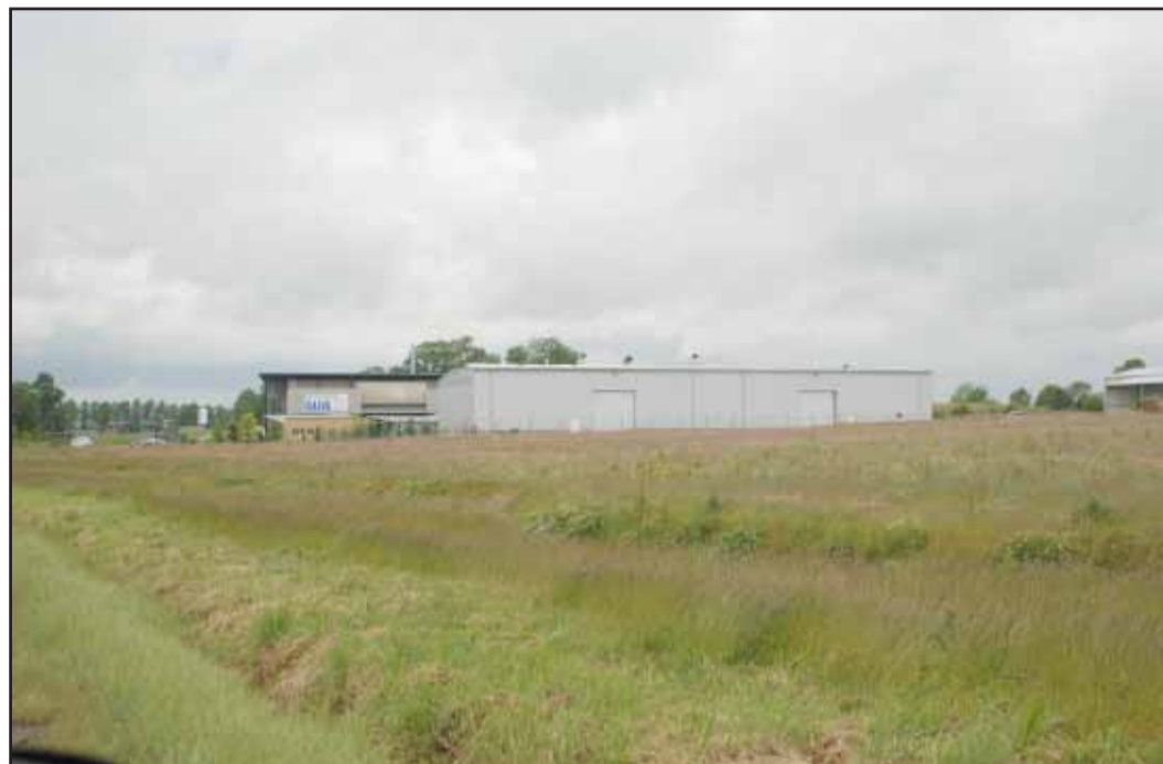
Un bâtiment agricole «sorti» du clos-masure.
