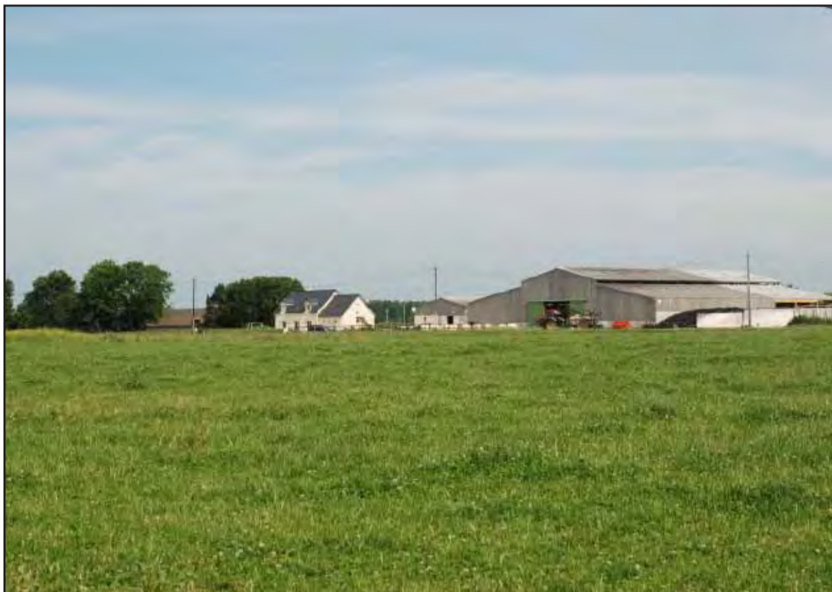
Hangar agricole récent situé à l'extérieur du clos-masure. Il est par conséquent très visible depuis l'espace agricole. En revanche, son bardage en bois et sa volumétrie (toit à plusieurs pentes) lui donnent un caractère soigné.
