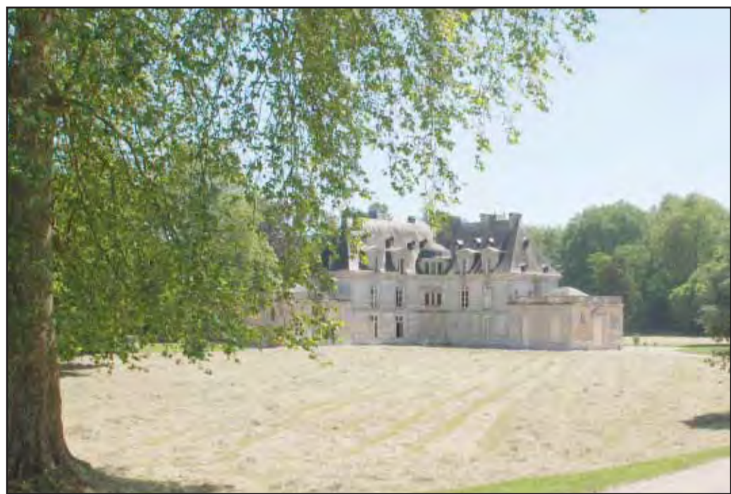
Château d'Acquigny, à la confluence de l'Iton et de l'Eure. (2009 - commune d'Acquigny)
