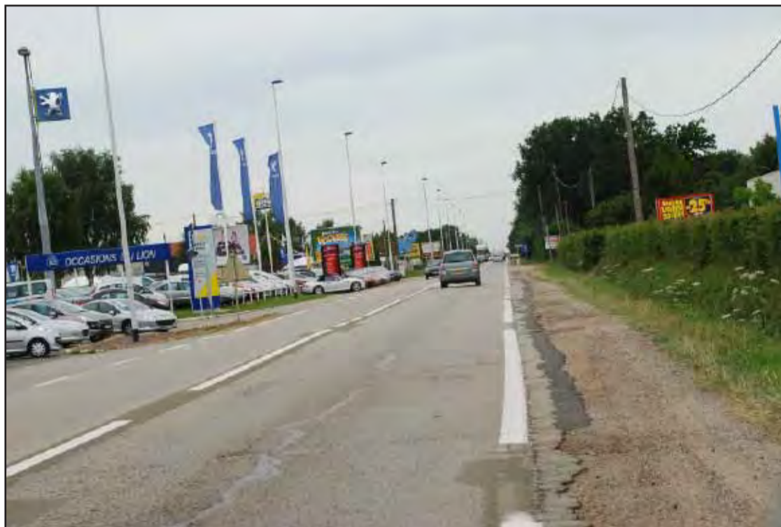
Une entrée de ville dégradée.
