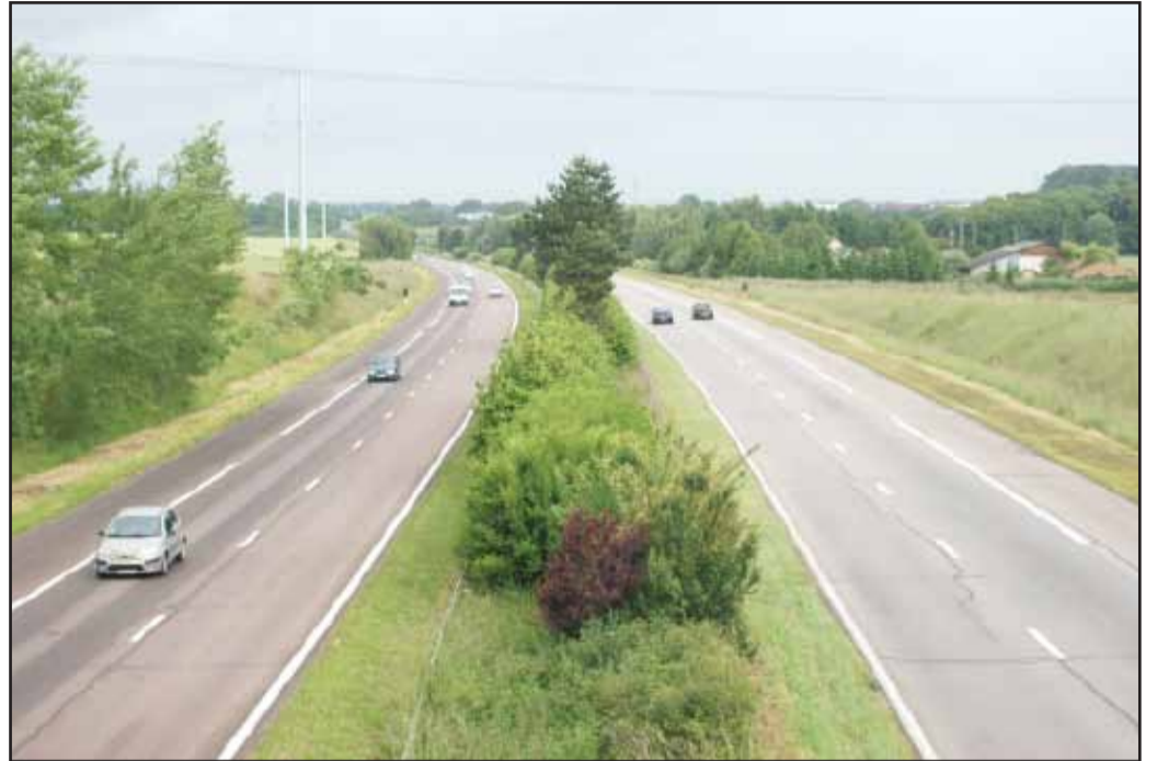
L'A150 au niveau de Roumare. (2009)
