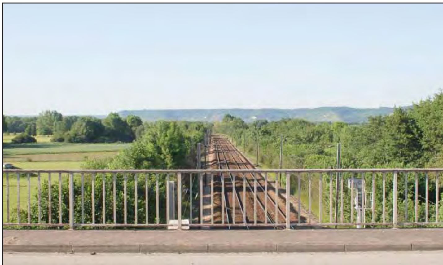
La voie de chemin de fer Paris-Rouen qui forme une frontière. (2009 - commune du Vaudreuil)
