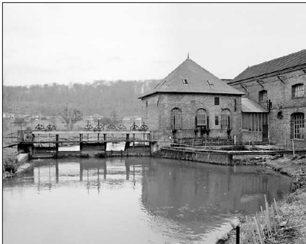
Petit barrage sur l'Andelle à Charleval.
