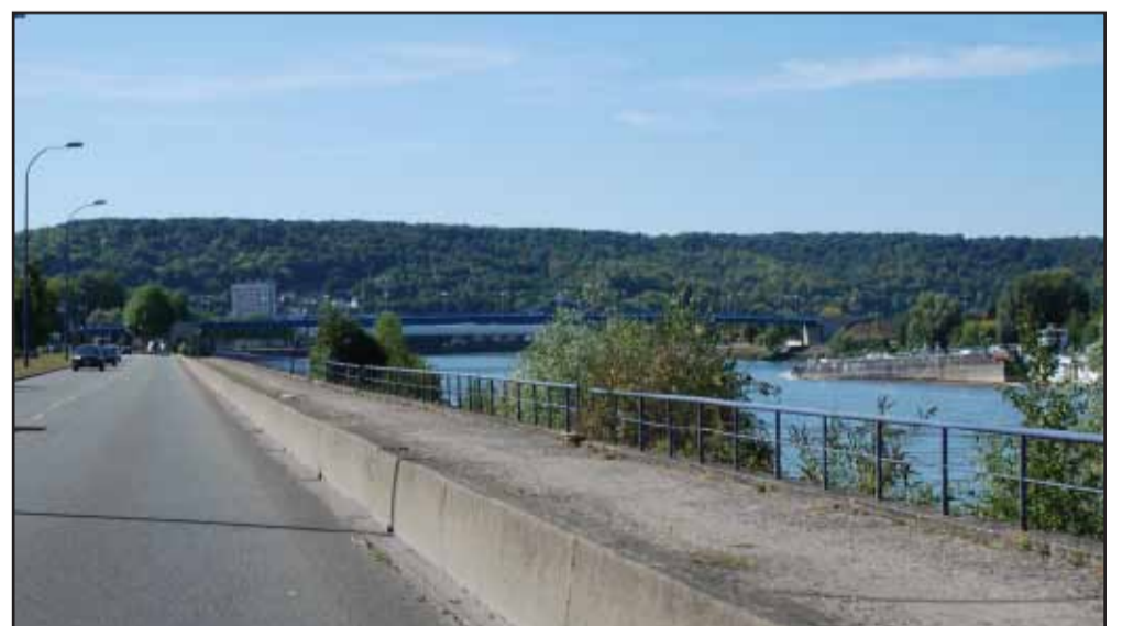
Des quais très minéralisés et peu valorisants à l'entrée d'Elbeuf.
