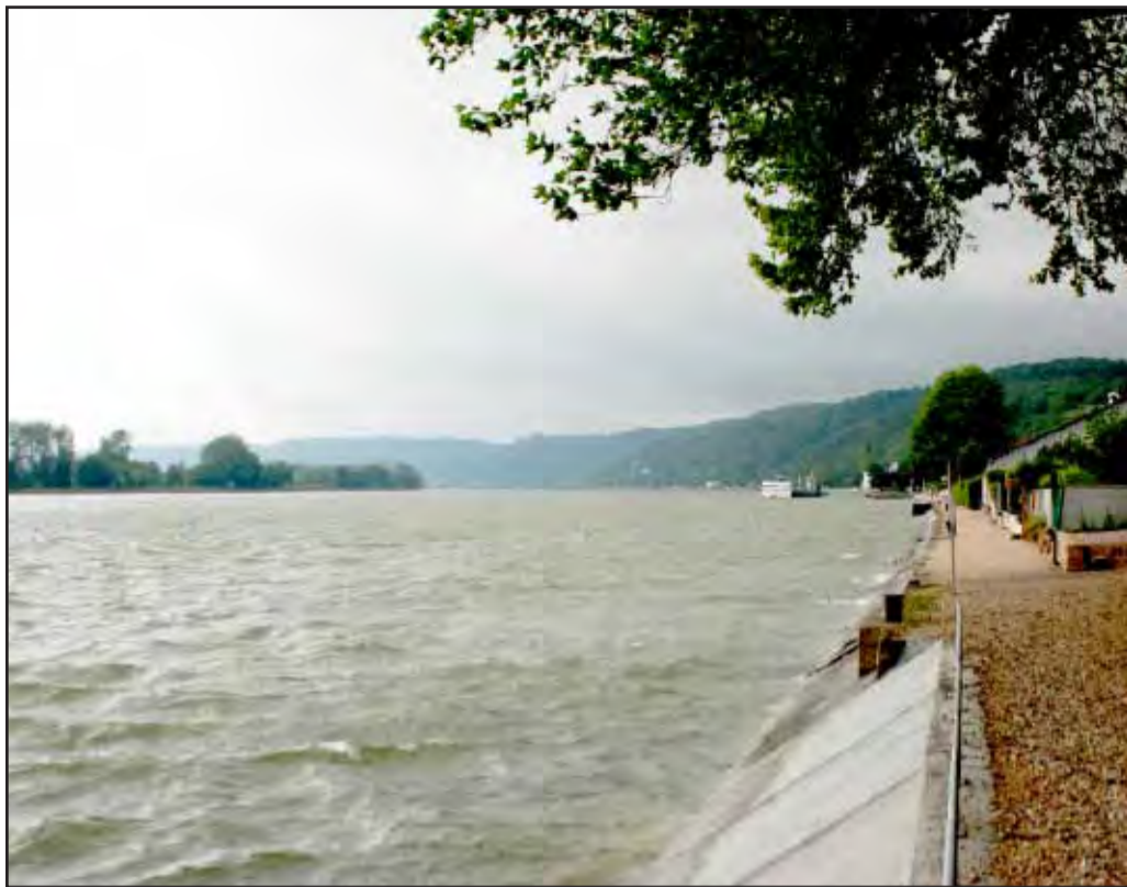
Les bords de Seine à Caudebec-en-Caux : les berges sont le plus souvent bétonnées ou enrochées. (2009 - commune de Caudebec-en-Caux)
