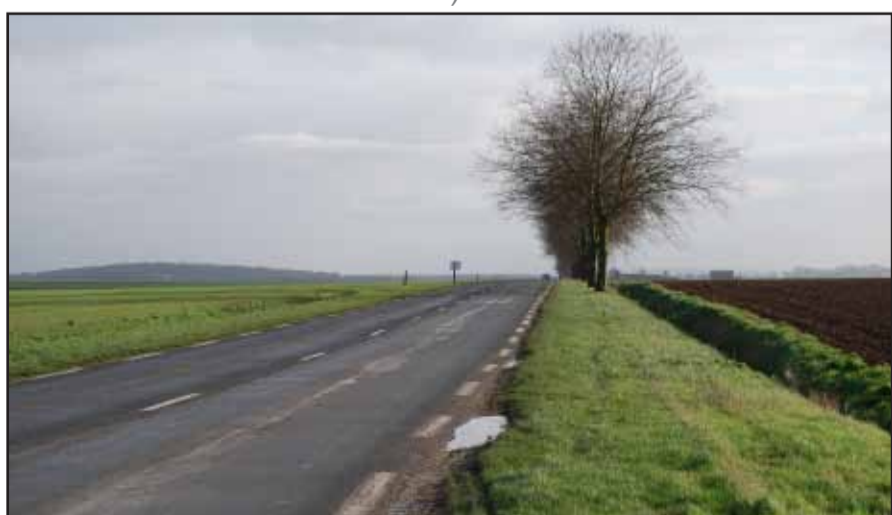
La RD 14 bis à la sortie d'Etrepagny. (2009 - commune d'Etrepagny)
