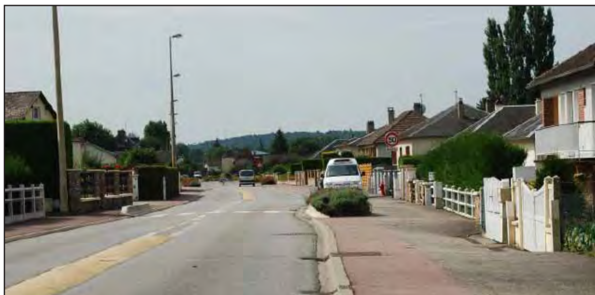
Une largeur de chaussée trop vaste dans ce contexte habité.
