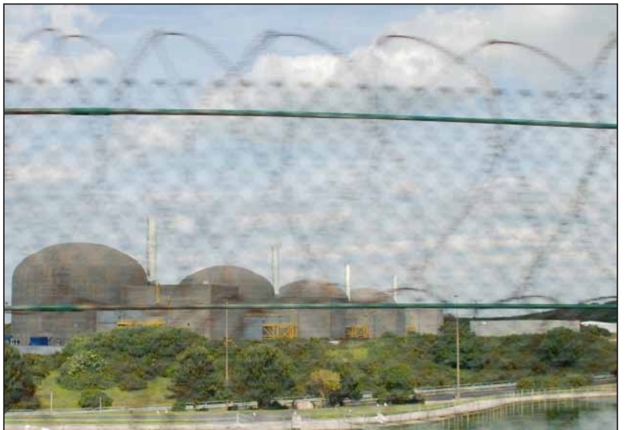
Grillage de sécurité et aménagements routiers donnent une image dévalorisante aux abords de la centrale nucléaire.
