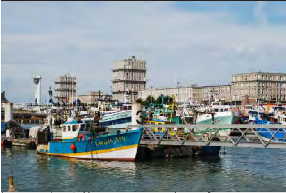
Le centre urbain du Havre reconstruit par Auguste Perret.
