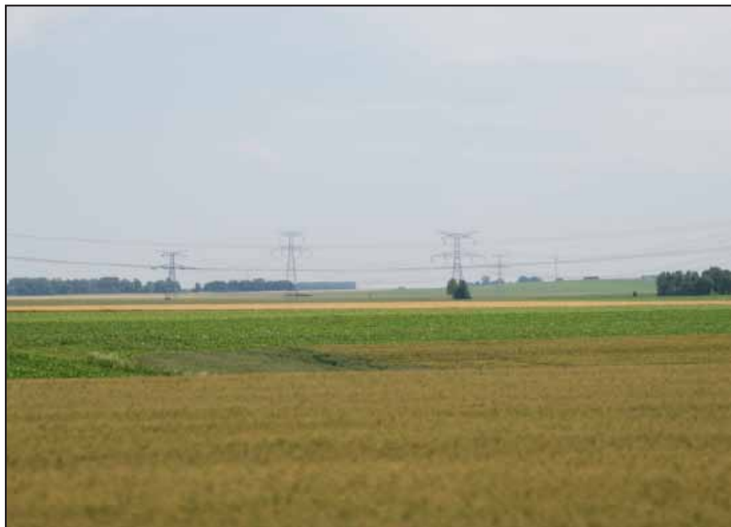
Les lignes à très haute-tension qui traversent le plateau à Biville-sur-Mer. (2009)
