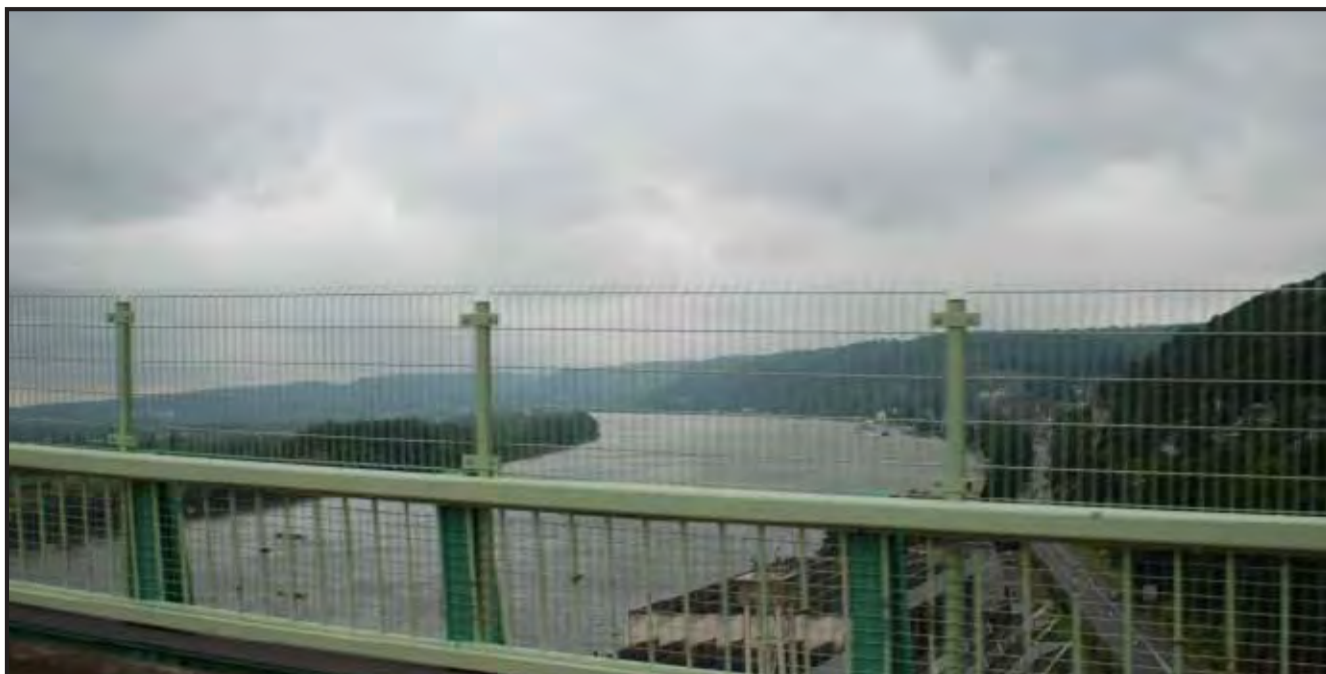
Les rambardes du pont de Brotonne occultent en grande partie le paysage de la vallée.
