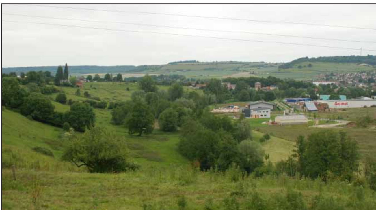
Les bâtiments de la zone d'activités viennent se coller à la rivière et occupent les prairies humides de la vallée.
