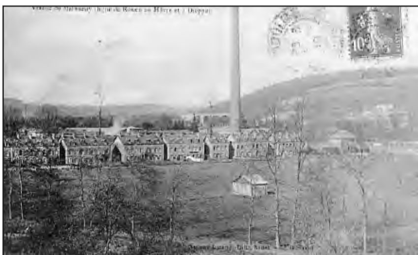
Cité industrielle isolée au milieu de l'espace agricole au Houlme. On distingue clairement des coteaux agricoles très entretenus au second plan.
