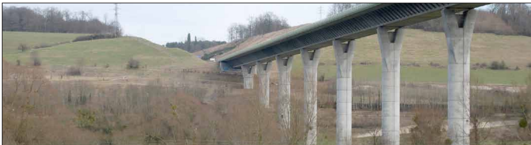
Le franchissement de la vallée de la Bresle par l'A 29 : une infrastructure qui s'affranchit du relief, un ouvrage «transparent», mais des coteaux fortement entaillés. (2010 - commune d'Aumale)
