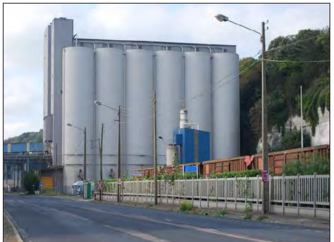
Silo le long de la Seine en aval de Rouen. (2009 - commune de Canteleu)
