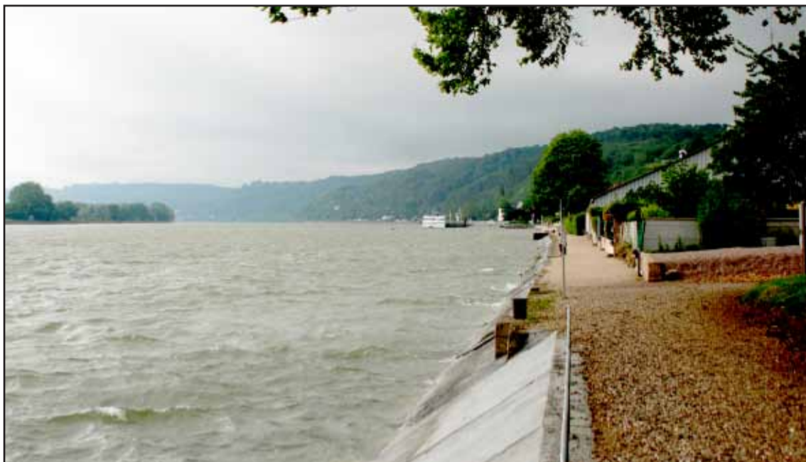
Des bords de seine durcis par la minéralisation des berges.
