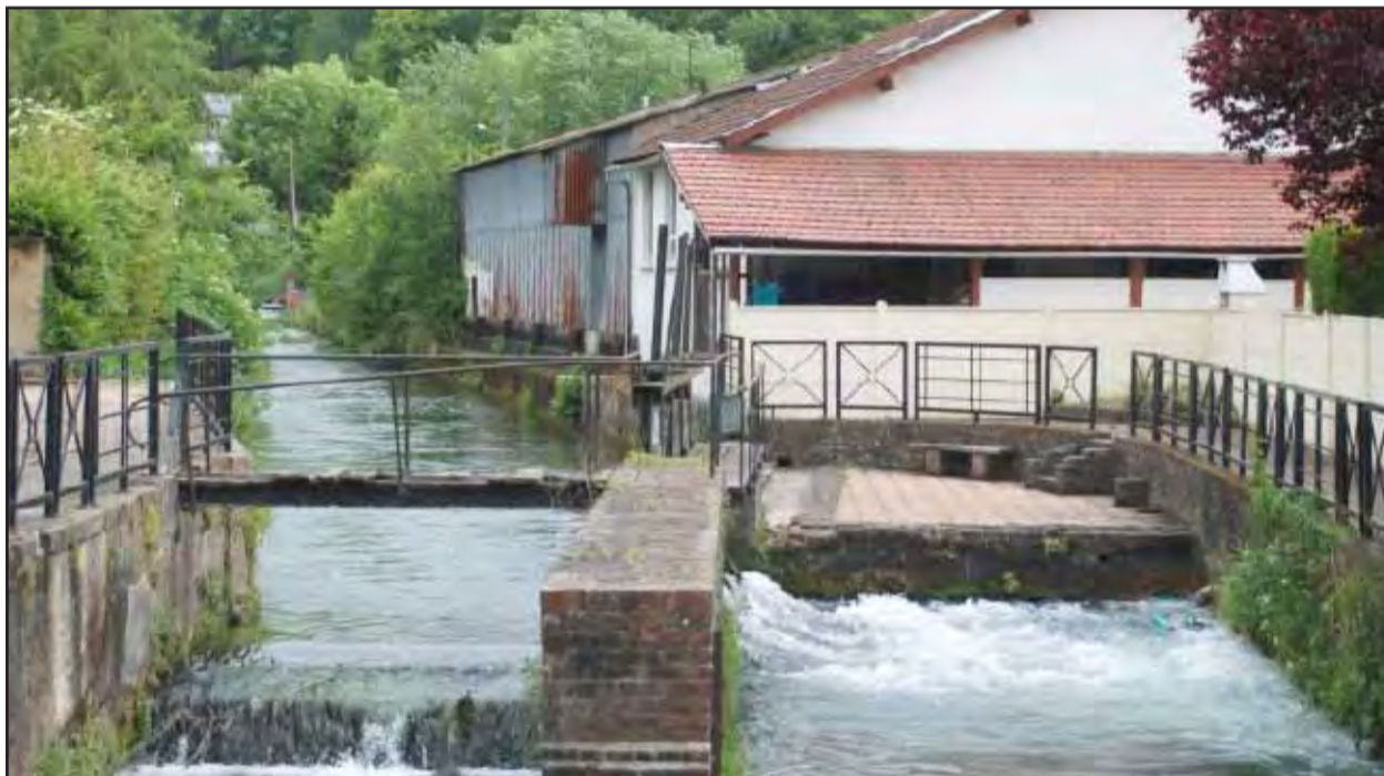
Petits ouvrages hydrauliques insuffisamment mis en valeur.
