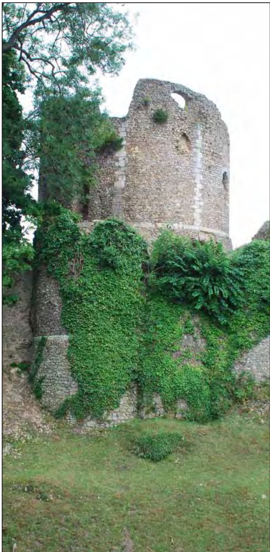
Donjon en ruine de Conches-en-Ouche dominant la vallée du Rouloir. (2009)
