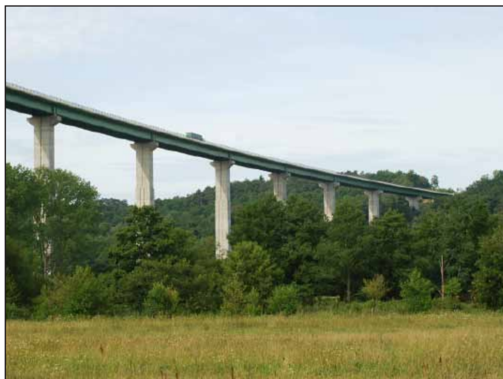
L'autoroute A28 traversant la vallée grâce à d'imposantes infrastructures. (2009 - commune de Calleville)
