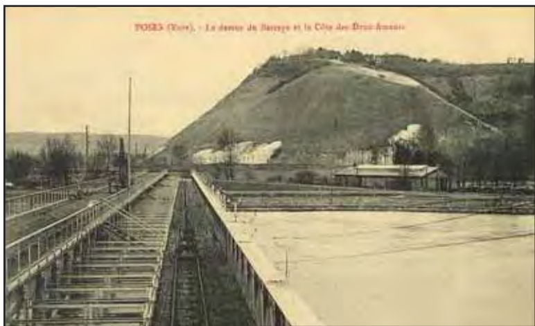
La construction du barrage.
