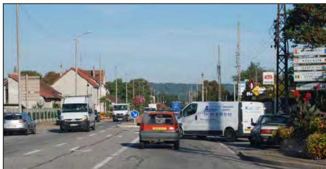
Une traversée de ville encore trop routière (largeur excessive de la chaussée, réseaux aériens et panneaux publicitaires...).
