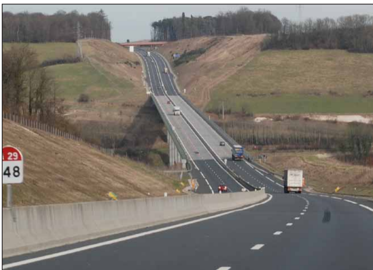
Une végétalisation des talus permettrait de mieux «cicatriser» l'entaille de l'autoroute dans les coteaux.
