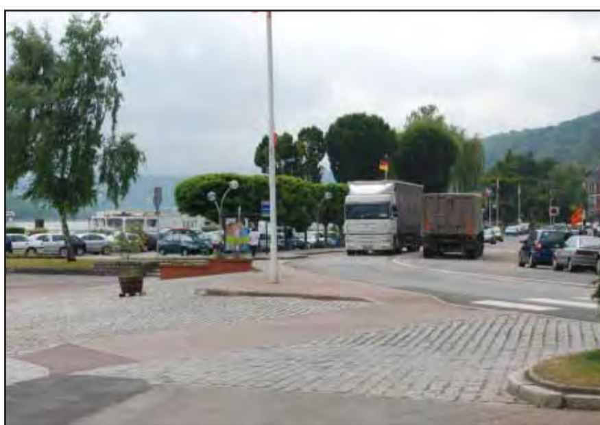
Le centre de Caudebec-en-Caux : un aménagement très envahi par la voiture. (2009 - commune de Caudebec-en-Caux)
