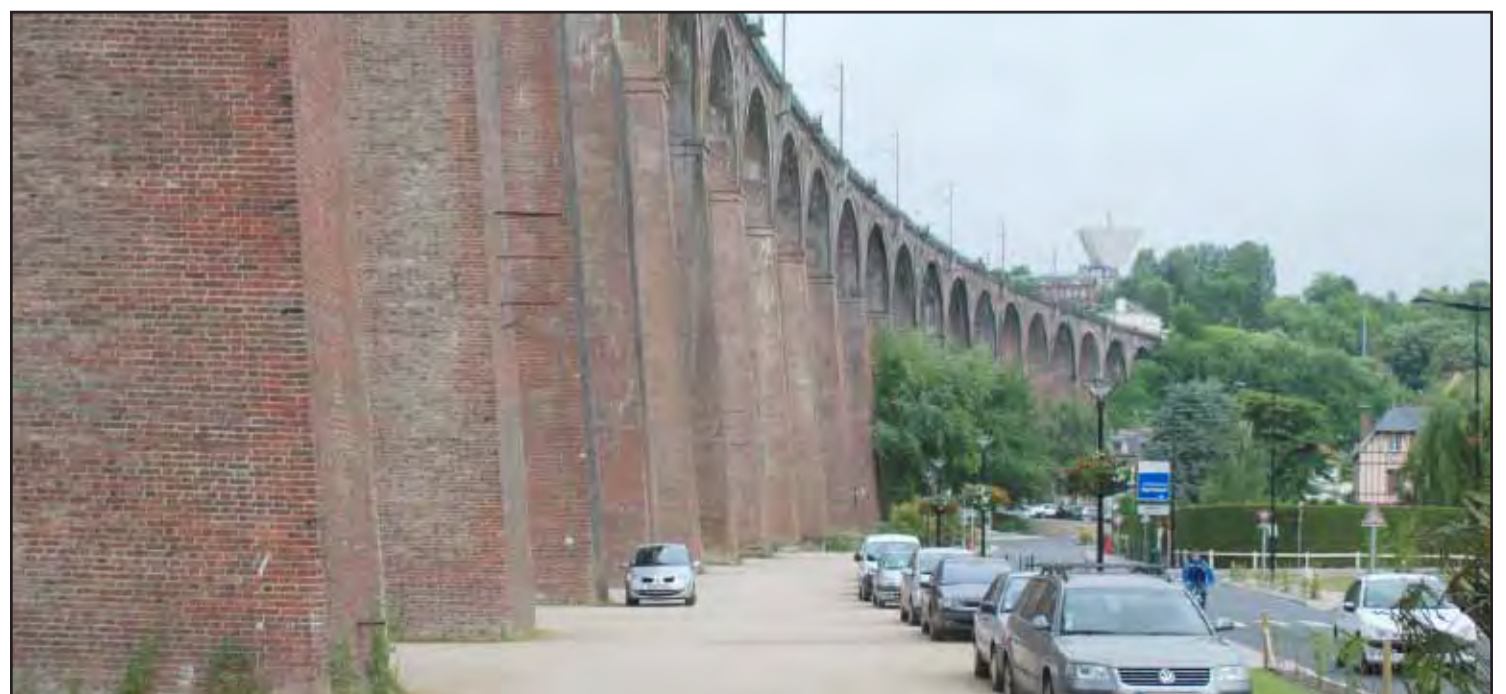
Ouvrage d'art exceptionnel du viaduc de chemin de fer à Barentin.
