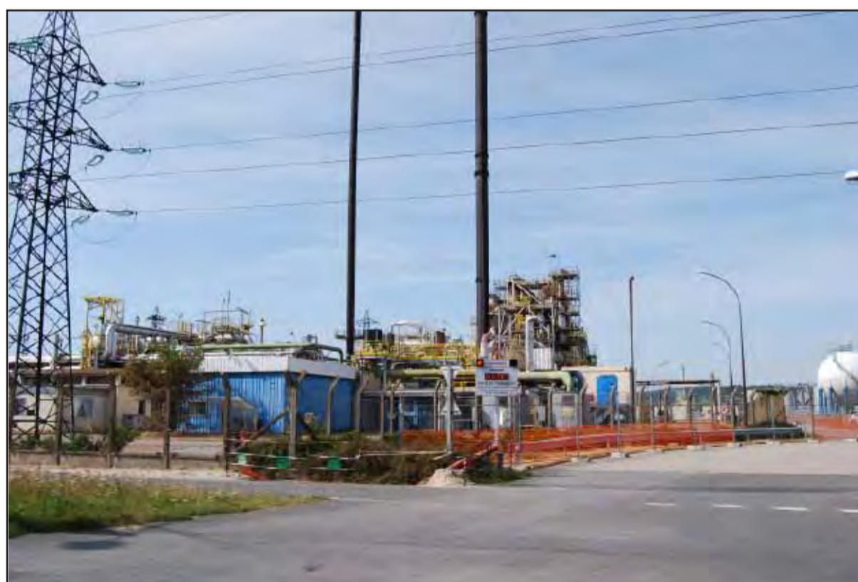
Les espaces publics et les clôtures sont peu soignés dans le site industriel de Port-Jérôme.
