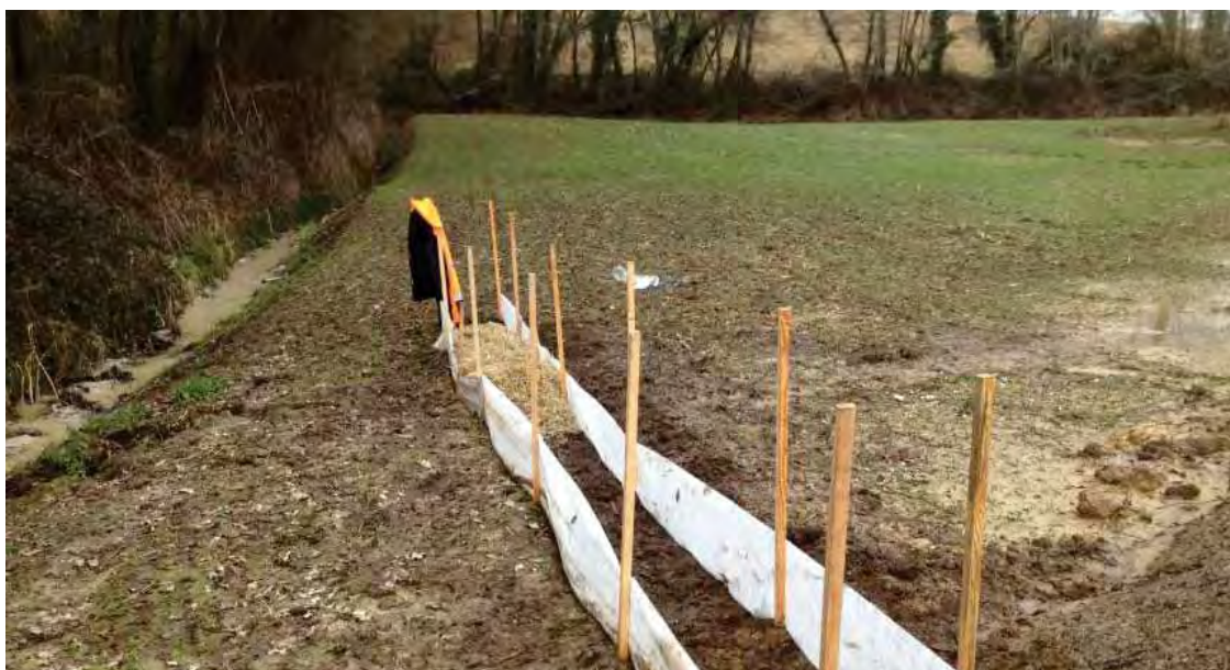
Photo 23 : Exemple de mise en place de barrière à sédiments (Source : Simethis)
