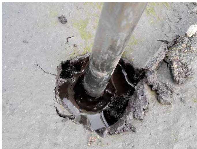
Photo 25 : Sondage 1383 remontée d'eau durant le sondage entre 25 et 40 cm de profondeur
