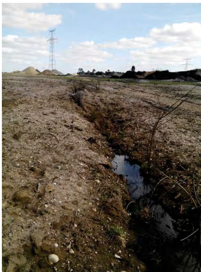
Photo 3 : Fossé à l'intérieur du site projet ayant une fonction de drainage (Source : Simethis)
