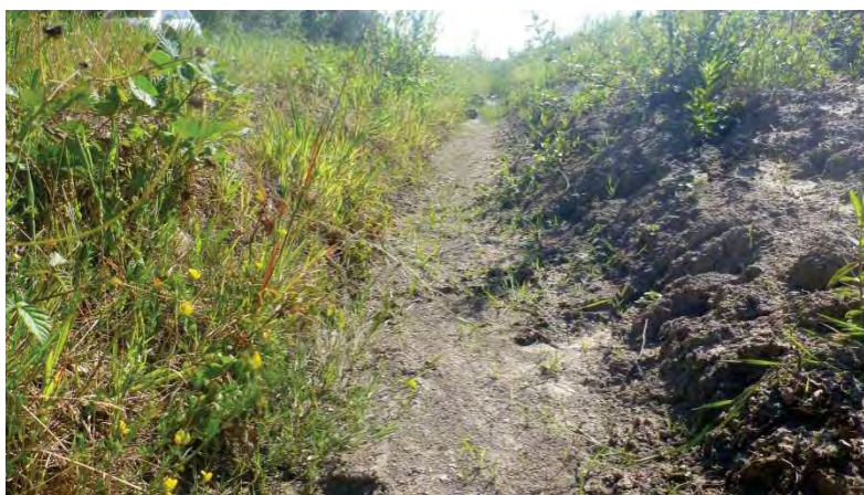
Photo 13 : Vue du fossé à l'endroit colmaté par ruissellement de boue provenant du site (Source : Simethis)
