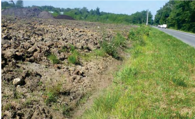
Photographie 1 : Fossé en bordure de route soumis aux impacts de des remaniements de terrain effectués sur le site (Source : Simethis)
