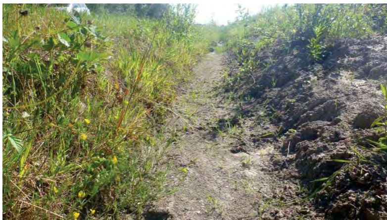
Figure 10 : Vue du fossé à l'endroit colmaté par ruissellement de boue provenant du site (Source : Simethis)
