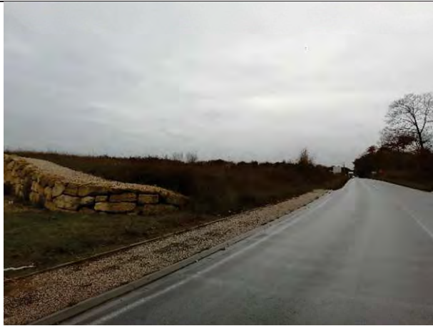
7 – Route des Grands Pins/Route de la Sauque – Site d'étude à gauche
