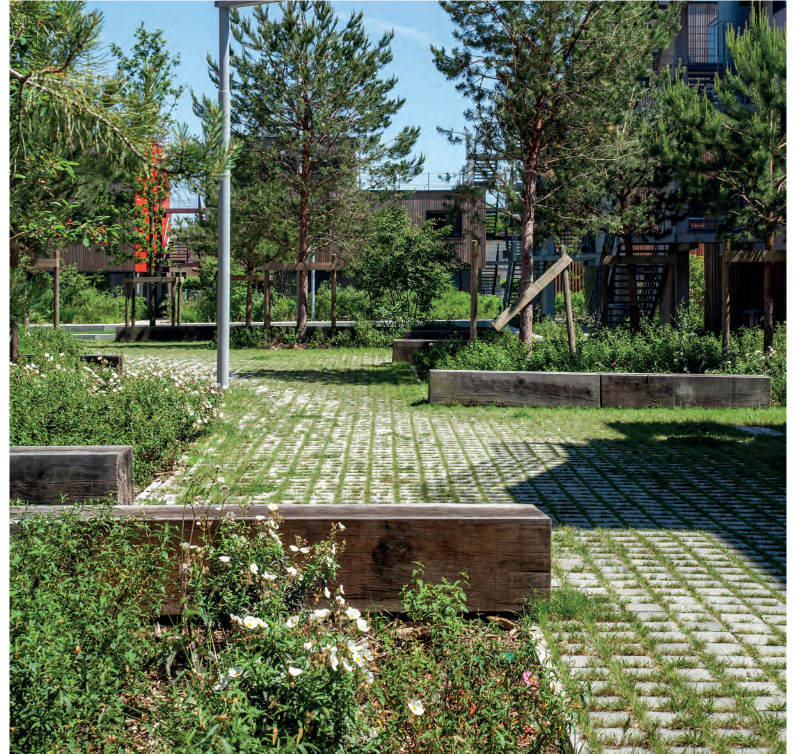
VILOGIA - BNPI - GOLDFINGER - ATELIER GODET RABECQ - LETSGROW Construction d'un ensemble immobilier de 133 logements collectifs en locatif social, accession abordable et accession libre Avenue Alexis Capelle, 33 130 BEGLES
