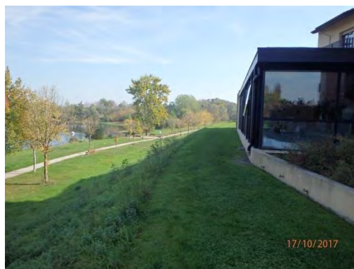
Muret du bâtiment dans la digue
