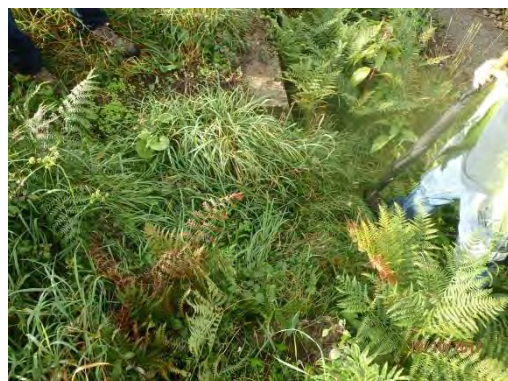
Interruption du mur par un escalier d'accès qui déporte la protection en retrait
