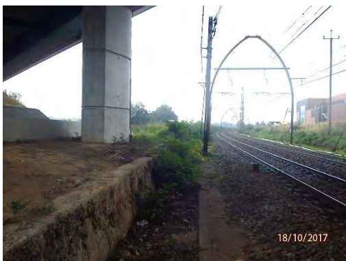
Mur contre la voie SNCF
