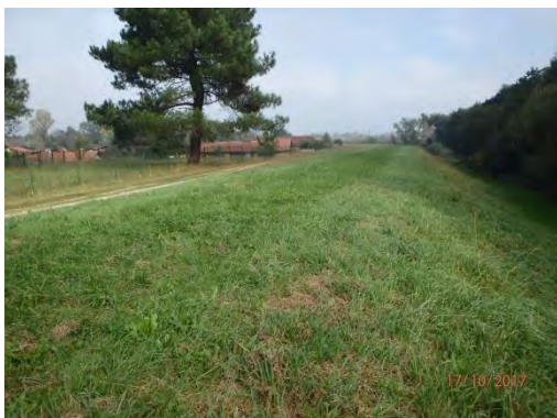
Remblai en terre
