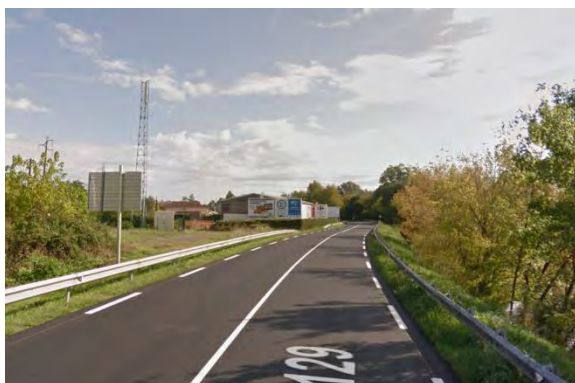
Traversée de la RN129
