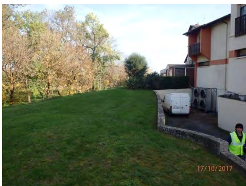
Parking souterrain de l'immeuble dans la digue
