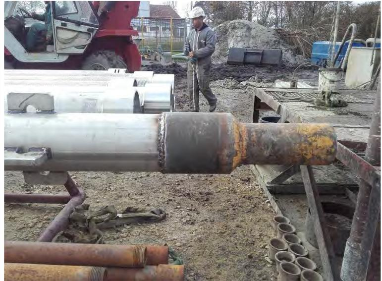
Raccord gauche soudé sur tube inox
