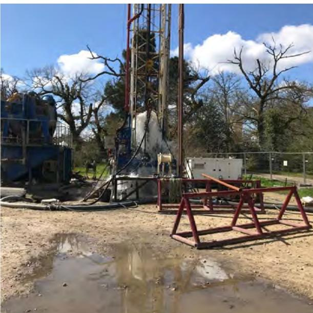
**Développement par soufflage direct avec compresseur 20 000 l/mn à 20 bars. Débit débit obtenu 150 m<sup>3</sup>/H.**
