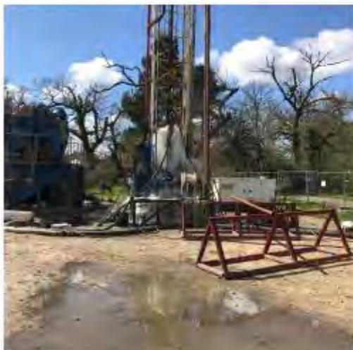
Développement par soufflage direct avec compresseur 20 000 l/mn à 20 bars. Débit obtenu 150 m<sup>3</sup>/H.
