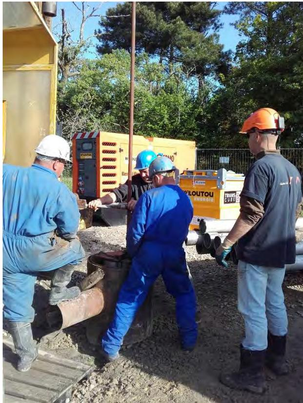
**Mise en place des tiges pour le soufflage plein trou**
