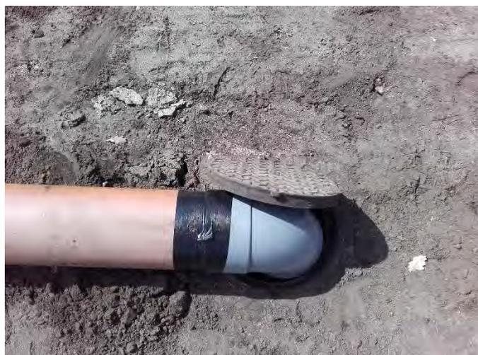
Raccord au rejet d'eau pluviale
